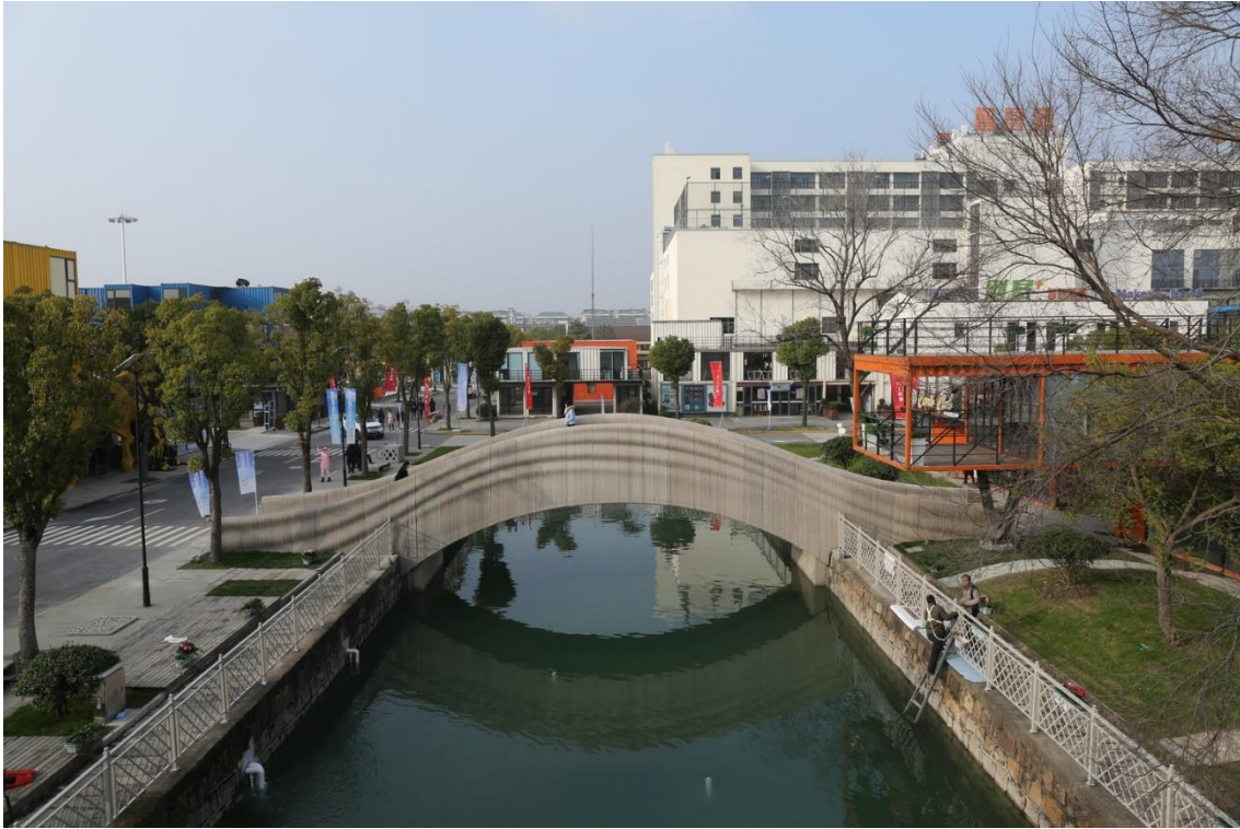
KUVA 18. Shanghaissa 3D-tulostettu betonisilta (Weiguo 2019)
