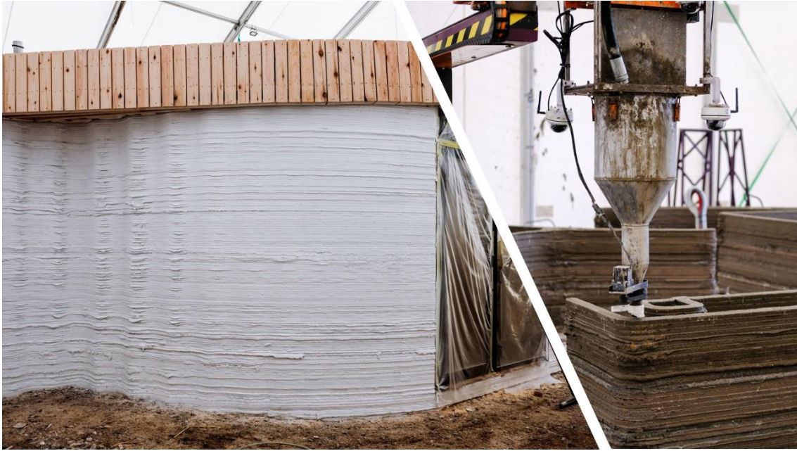
KUVA 20. Kierrätettyjä materiaaleja hyödyntävästä betonimassasta 3D-tulostettu BOD (COBOD International 2017)
