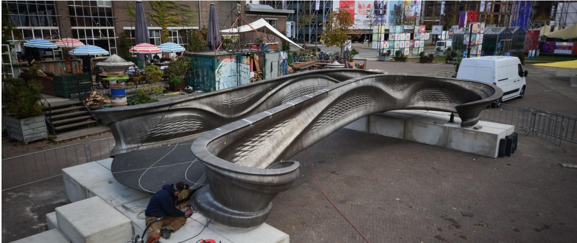
KUVA 19. Vuonna 2018 valmistunut MX3D:n valmistama terässilta (MX3D)
