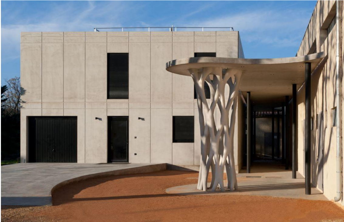
KUVA 21. Ranskassa toteutettu, ”muoto seuraa voimaa” -periaatetta edustava, betonista 3D-tulostettu pilari (Ricciotti 2017)
