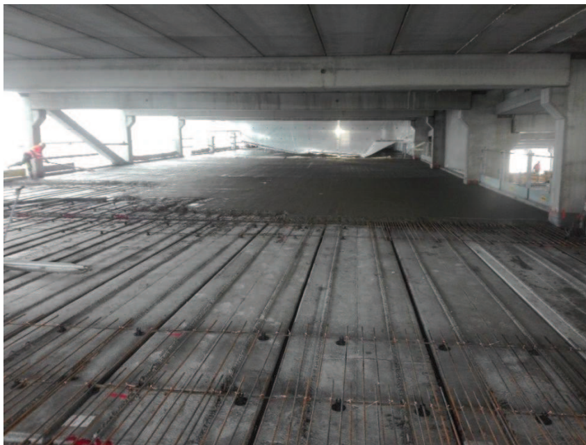
Kuva 12. Kuorilaattojen päälle valettava alusbetonikerros (Koponen 2018)
