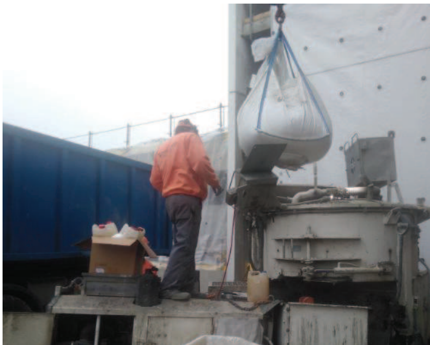
Kuva 14. Kovabetonimassan sekoitus (Koponen 2018)
