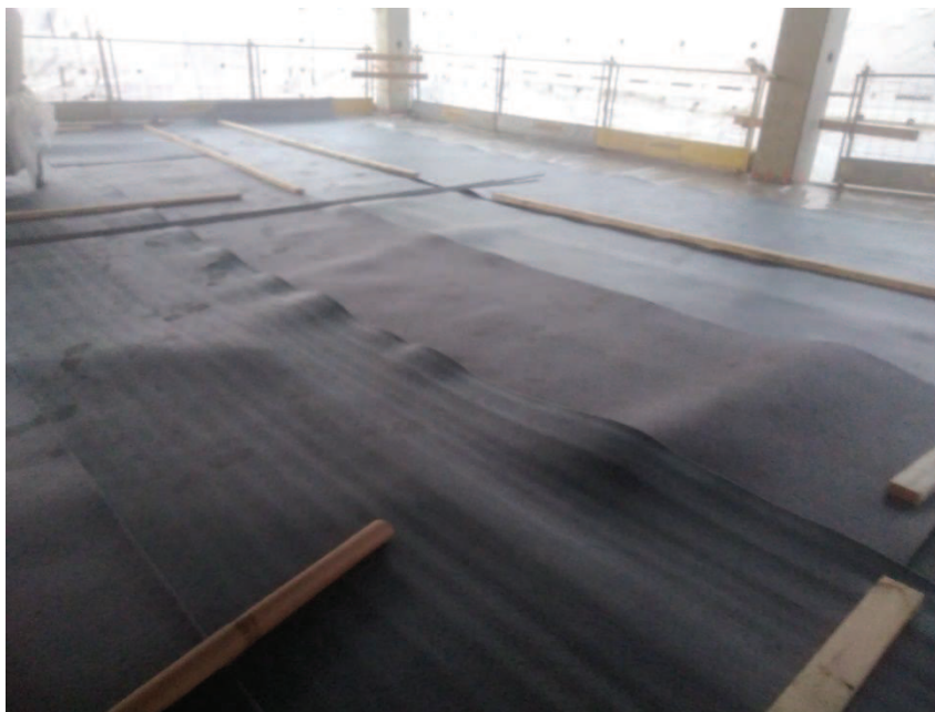
Kuva 18. Valmis pinta suojattu routamatoilla (Koponen 2018)
