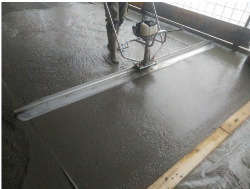
Kuva 16. Kovabetonipinnan tiivistys tärypalkilla (Koponen 2018)
