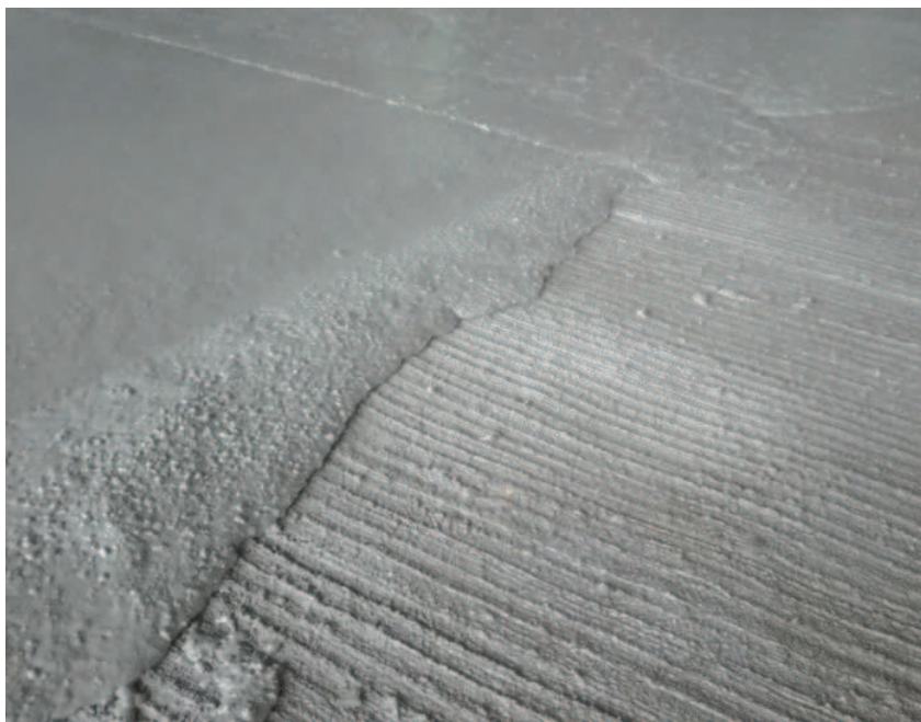
Kuva 2. Kovabetonipintausta kovettuneen alusbetonin päällä (Koponen 2018)
