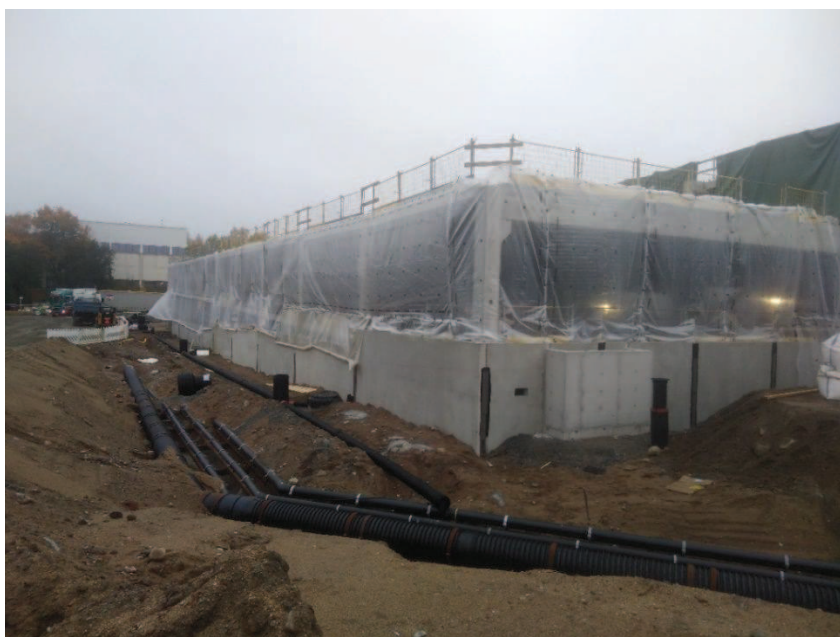
Kuva 9. Pysäköintilaitos tuulisuojapeitteillä suojattuna (Koponen 2018)
