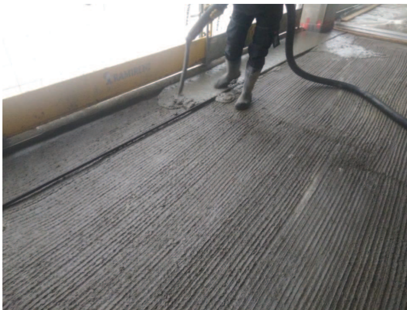
Kuva 15. Kovabetonimassan levitys ohjureita apuna käyttäen (Koponen 2018)
