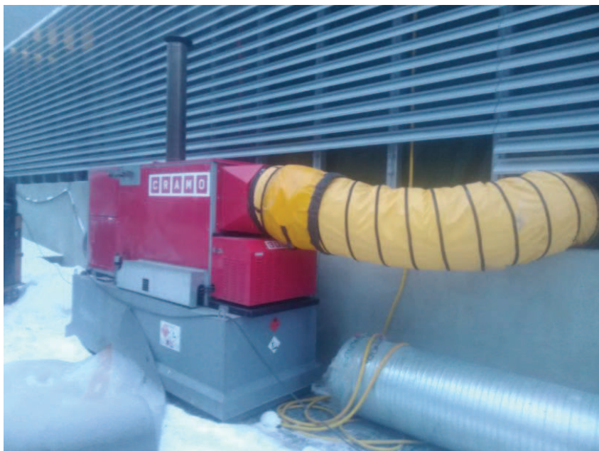
Kuva 10. Rakennuslämmitin (Koponen 2018)
