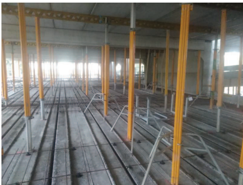
Kuva 11. Yläpuoliset kuorilaatat tuettu holvituilla ja muottipalkeilla (Koponen 2018)
