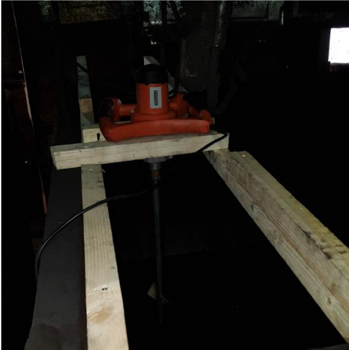
KUVA 14. Sekoituskone ja sille rakennettu teline
