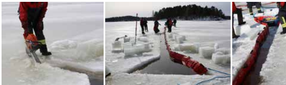
Kuva 29. Puomitusrailon ja keruualan sahaaminen. Kuvat Pohjois-Savon jääolosuhteiden torjuntatarjoituksesta. Kuvat: Justiina Halonen 2018.
