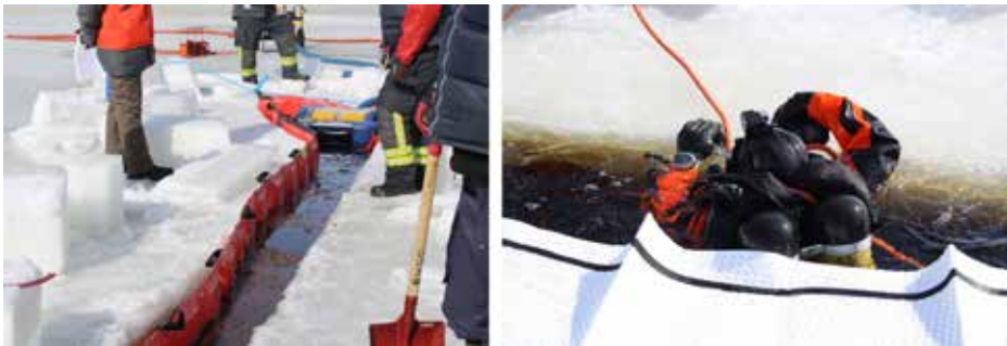
Kuva 17. Kiintojääolosuhteissa puomitus tehdään jäähän sahattuun railoon. Öljyllä on taipumus nousta avoveteen, joten railo toimii myös ilman puomia. Puomia voidaan kuitenkin käyttää tehostamaan öljyn pysäytystä. Virtaus kuljettaa öljyn railoon asetettua puomia myöten railon päähän, josta se kerätään pois. Kuvat: Justiina Halonen 2018.
