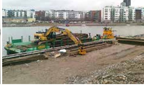
Kuva 3. Työkoneiden lautta- ja proomukuljetukset saattavat mahdollistaa myös työskentelyn veden puolelta, mikäli koneen ulottuvuus ja rannan profiili sallivat. Esimerkiksi kalliojyrkänteiden pesu on turvallisempaa lautalta käsin. Kuvat: Kuormaustyö KM Oy.
