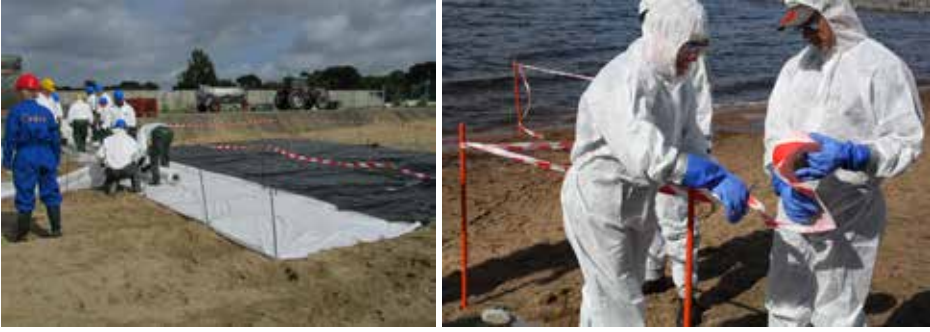
Kuva 6. Keräystyömaan perustaminen käynnissä. Kuvat: Melinda Pascale 2010 ja Justiina Halonen 2018.
