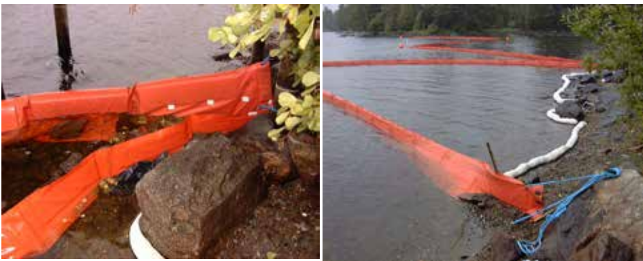
Kuva 31. Rantapuomituksen kiinnitys. Puomin taitetun reunan päälle on laitettu painoksi kiviä, jotta kiinnityksestä tulee tiivis. Kuvat: Pohjois-Savon pelastuslaitos.
