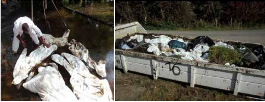
Kuva 16. Esimerkki resurssiviisaasta ja leväperäisemmästä jätesuunnittelusta. Tarkka työnjohtaja käyttää kaiken materiaalin loppuun asti hyödyksi. Esimerkiksi lievästi likaantuneet kertakäyttöhaalarit toimivat hyvin vielä imeytymateriaalina. Oikeassa kuvassa rannalta kerätty öljyinen jäte on koottu lajittelemattomana kuljetusyksikköön. Tällaisen jäte-erän loppukäsittelykustannukset voivat nousta erittäin suuriksi. Öljyisen kiinteän jätteen käsittely maksaa kymmenkertaisesti sekajätteeseen verrattuna. Vastaavasti lajittelemattoman vaarallisen jätteen käsittelykustannukset voivat nousta sata- tai tuhatkertaisiksi. Kuvat: Cedre.
