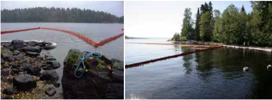
Kuva 30. Rannan suojapuomitukseen tulee muodostaa alueita, joihin öljy alkaa kertyä, muutoin ongelma vain siirtyy eteenpäin. Tällaisia ovat esimerkiksi siksak-puomituksen taskut. Kuvat: Pohjois-Savon pelastuslaitos.
