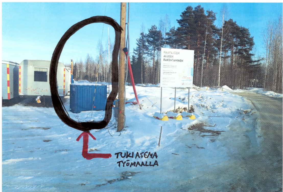
Kuva 5. Kiinteä tukiasema kadunrakennustyömaalla (Veijo Rasanen)
