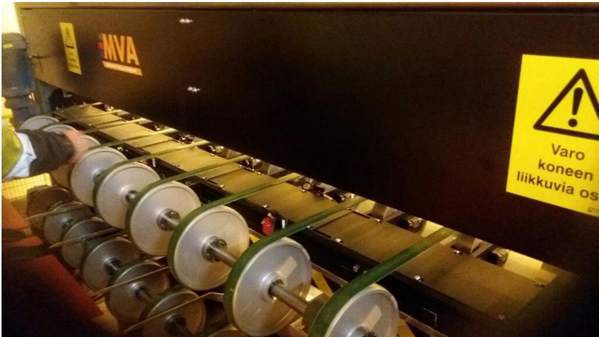
Kuva 6. Koskisen Oy:n uusi Mecano MVA -kosteusanalysointilaitteisto
