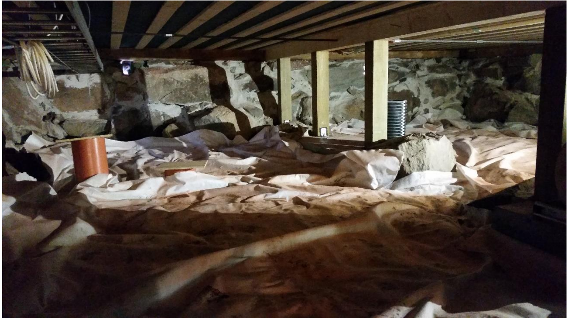
Kuva 9. Maapohja peitettynä suodatinkankaalla.
