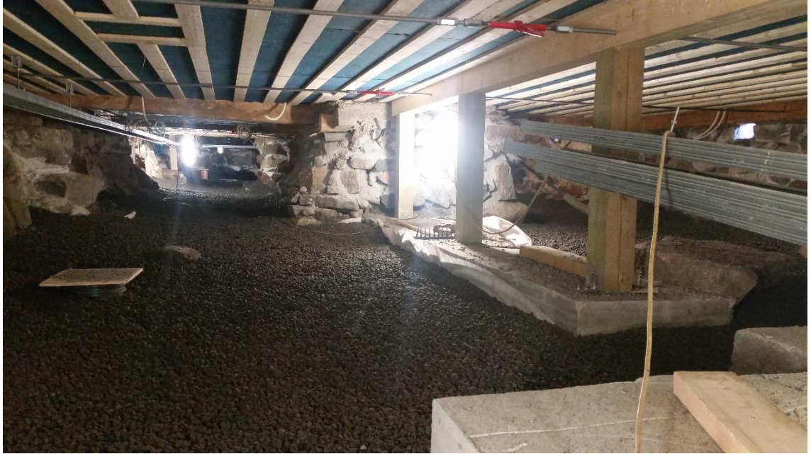
Kuva 10. Kapillaarikatko puhallettuna.
