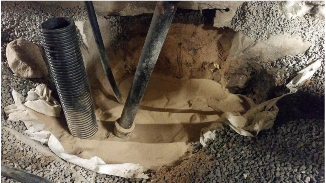
Kuva 11. Putkiläpivienti täytettynä bentoniitti-savella.
