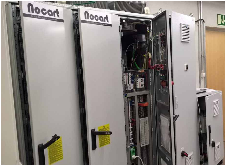
Kuva 31. Nocard, sähkön verkkoosyöttöjärjestelmä BioSamossa. Kuva. Xamk.
