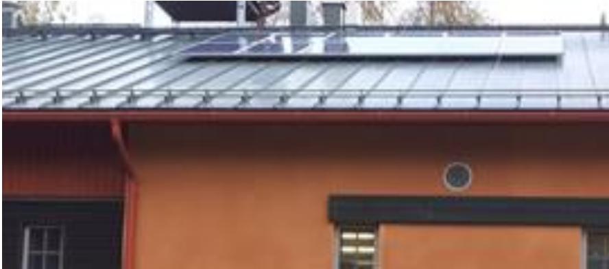
Kuva 39. Aurinkosähköpaneelit BioSampo-rakennuksen katolla. Kuva. Xamk.
