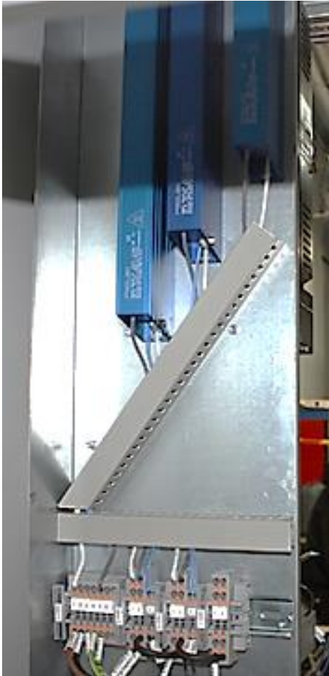
KUVA 15. Jarruvastusten riviliittimet ja jarruvastukset
