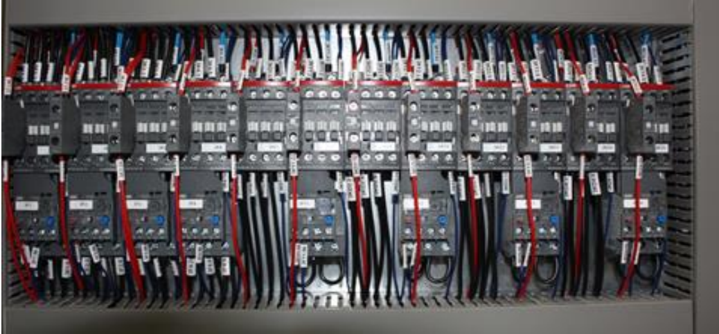
KUVA 26. Moottorien kontaktorit
