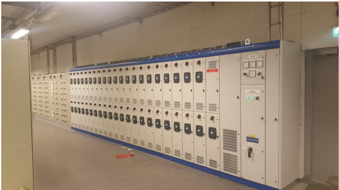
Kuva 2. JVK2 rullaratakäyttöjen taajuusmuuttajakeskus K2109
