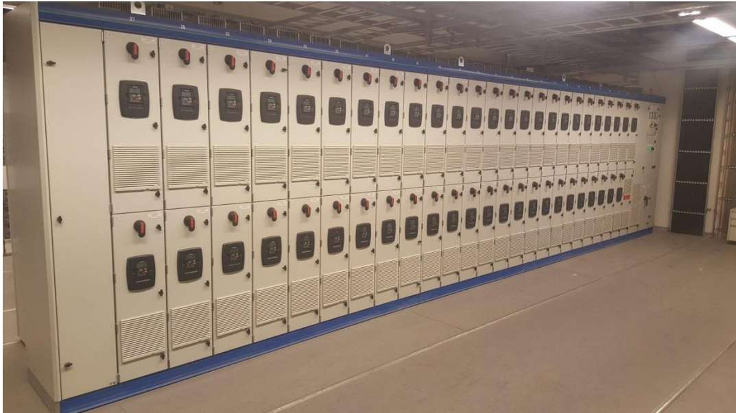
Kuva 1. JVK1 rullaratakäyttöjen taajuusmuuttajakeskus K2033
