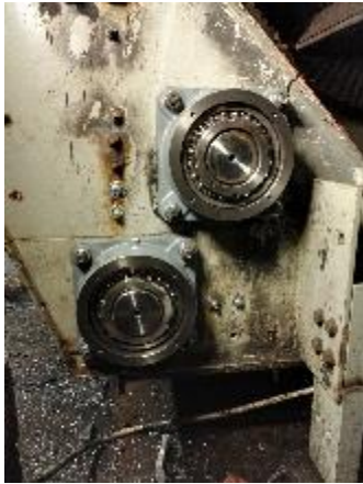
Kuva 48. Maatason laakerit valmiiksi asennettuna, lukuun ottamatta kansia.(Kuva 48)
