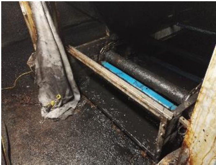
Kuva 15. Pääty- ja sivulevyt purettuina kiristysakselin luota.
