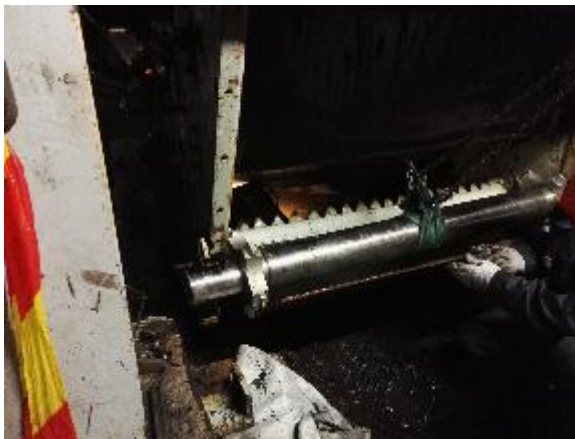
Kuva 45. Taittoakselin asentaminen paikoilleen.
