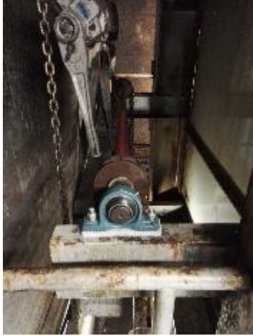
Kuva 52. Yläpuolen akselikokonaisuus asennettuna paikoilleen.
