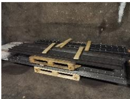
Kuva 37. Uutta kiskostoa odottamassa asennusta.
