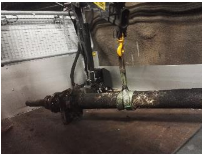
Kuva 30. Akseli on saatu nostettua lavalle ja valmiina laakereiden ja ketjupyörien purkamiseen.
