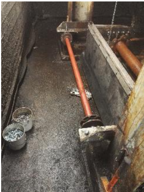
Kuva 51. Vastapainokiristuksen maatason akseli ja sen laakerit valmiina.
