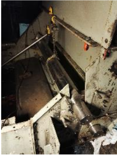
Kuva 46. Ylempi taittoakseli on saatu urilleen ja alempaan laitettua pellit.
