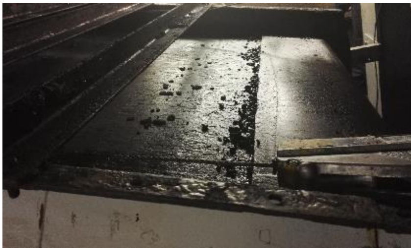
Kuva 12. Lompakkotaljat kiinnitettynä vetopään yläpuolelle.
