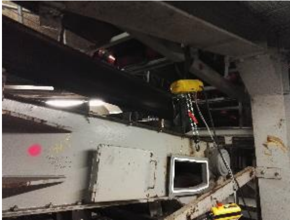
Kuva 56. Pienempi vinssi asennettuna palkkiin kiinni.
