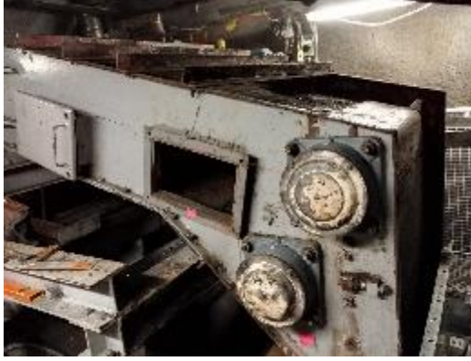
Kuva 50. Ensimmäisen tason akseleiden ja laakereiden asentaminen saatu loppuun.
