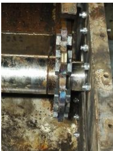
Kuva 41. Kiristysketjupyörä on saatu asennettua keskelle suhteessa kiskostoon.
