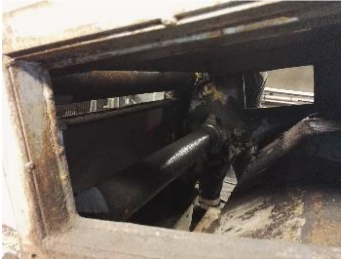
Kuva 20. Ensimmäisen tason taittoakselit valmiina irrottamiseen.
