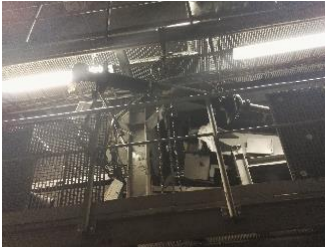
Kuva 29. Vetoakseli on odottamassa HIAB:a.
