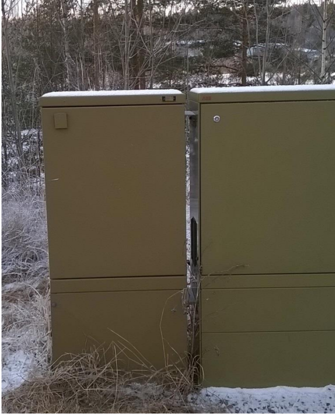
Kuva 18. Tyypillinen katujakokaappi mitatulla alueella.
