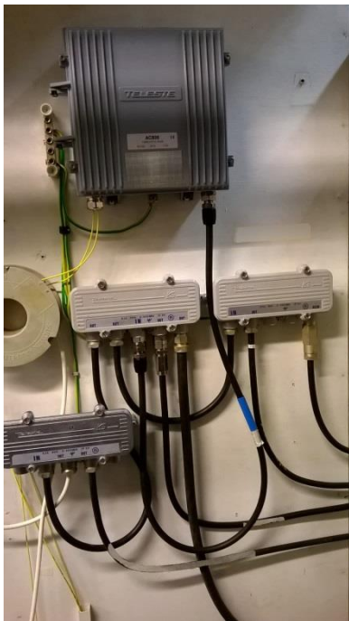
Kuva 20. Node ja passiivilaitteet vuodolla 1379.
