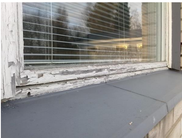
KUVA 13. Makuuhuoneen ikkuna talon eteläsivulla
