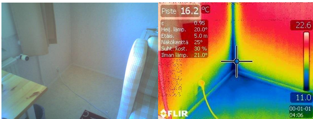
KUVA 12. Makuuhuoneen (MH1) ulkoseinien ulkonurkka
