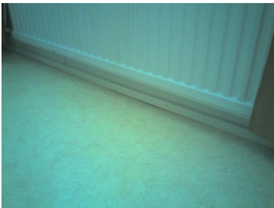
KUVA 35. MH2, lattian ja seinän liittymä
