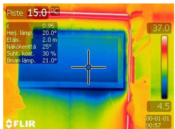
KUVA 32. Lämpökamerakuva vaatehuoneen ikkunasta
