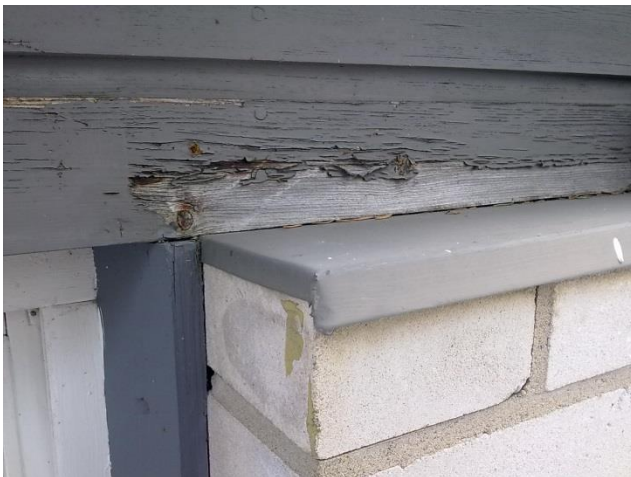
KUVA 8. Tiiliverhouksen suojapelti
