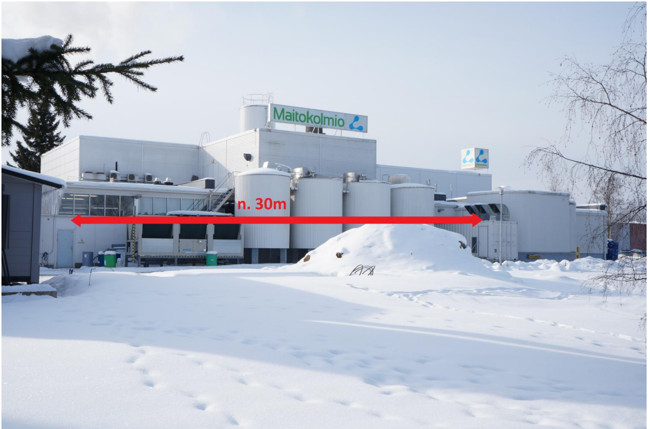
KUVA 6. Paineilma-aseman ja pannuhuoneen välinen etäisyys
