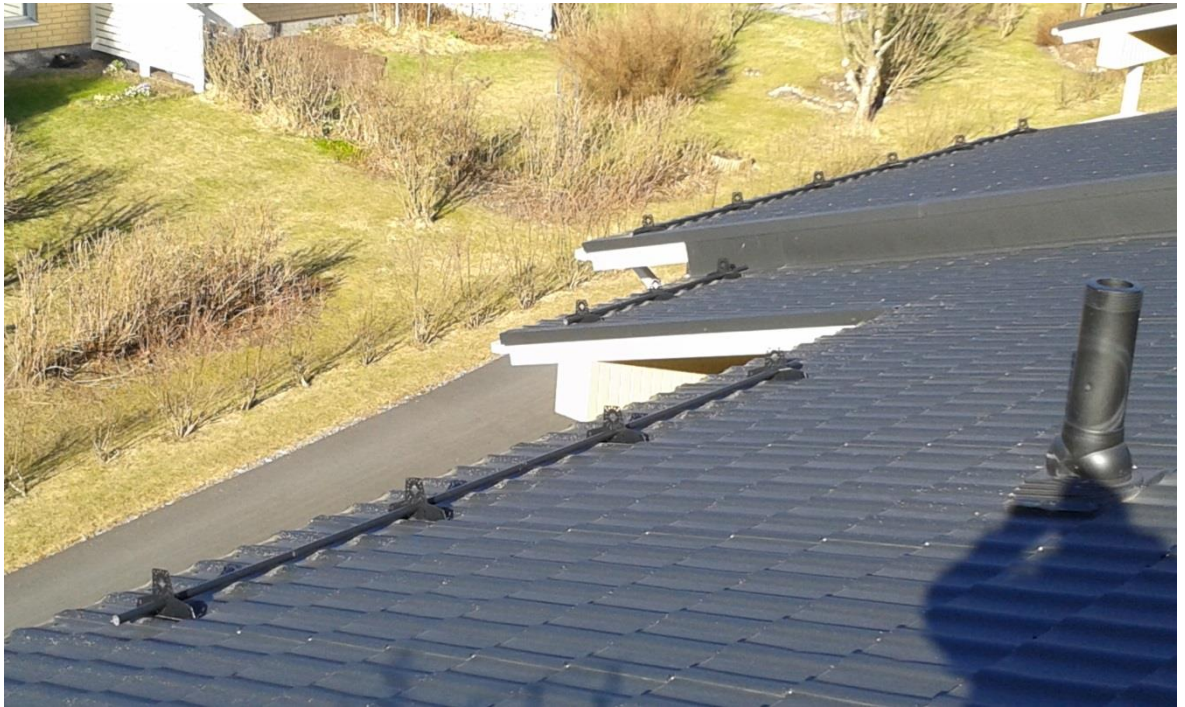
Kuva 9. Puuttuvat yläorret.
