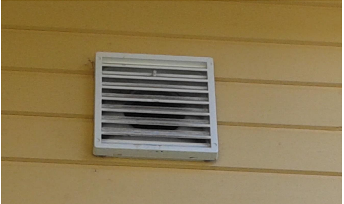
Kuva 11. Raitisilmasäleikkö.
