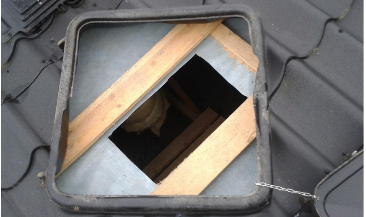
Kuva 10. Paloluukkujen kulkuesteet.
