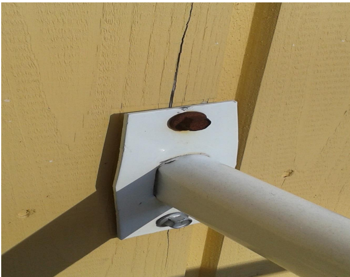
Kuva 31. Talotikkaan kiinnitys
