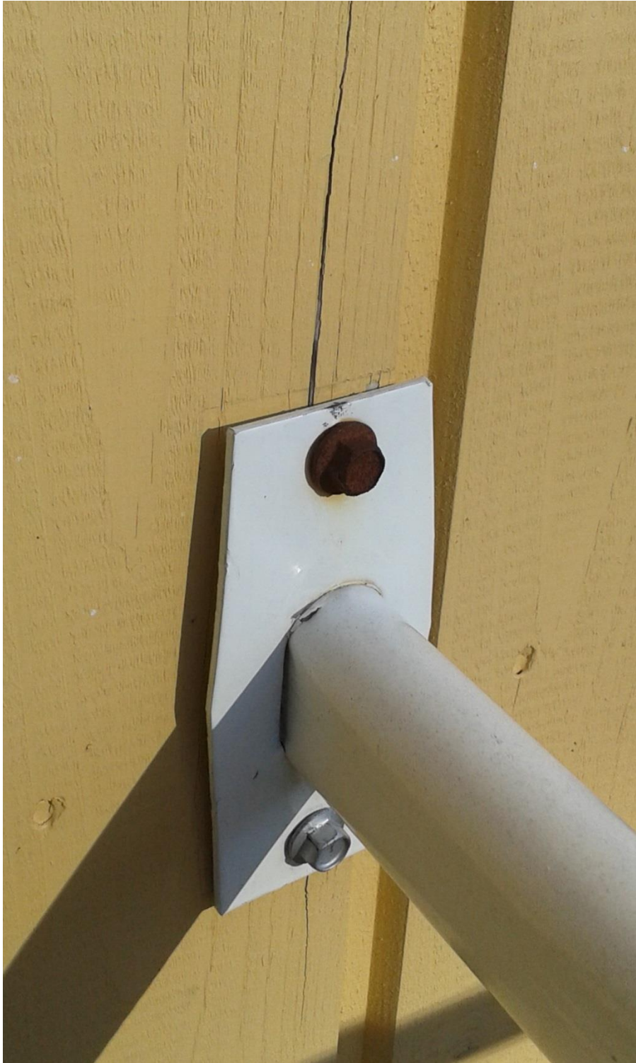
Kuva 7. Talotikkaiden kiinnitys.
