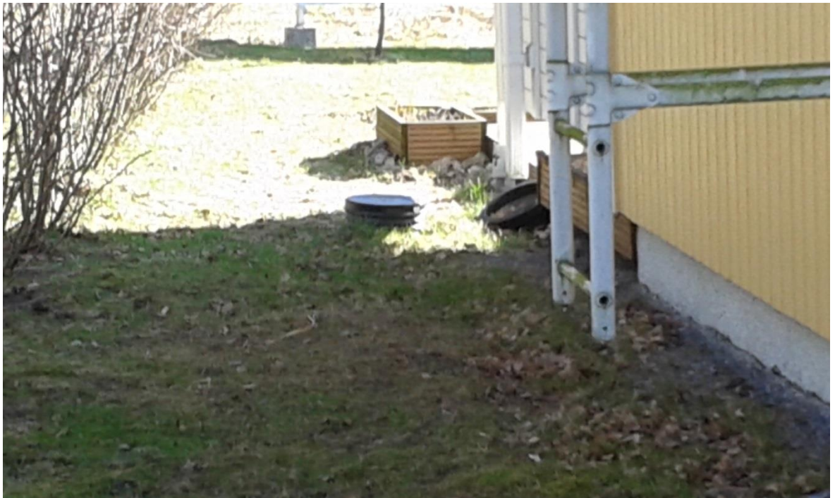
Kuva 2. Itäpäätty ja salaojan tarkastusputki.
