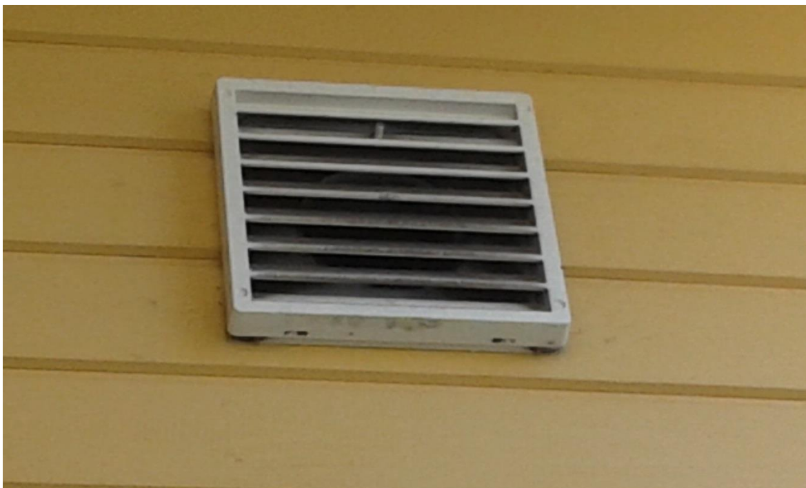
Kuva 32. Raitisilmaventtiili
