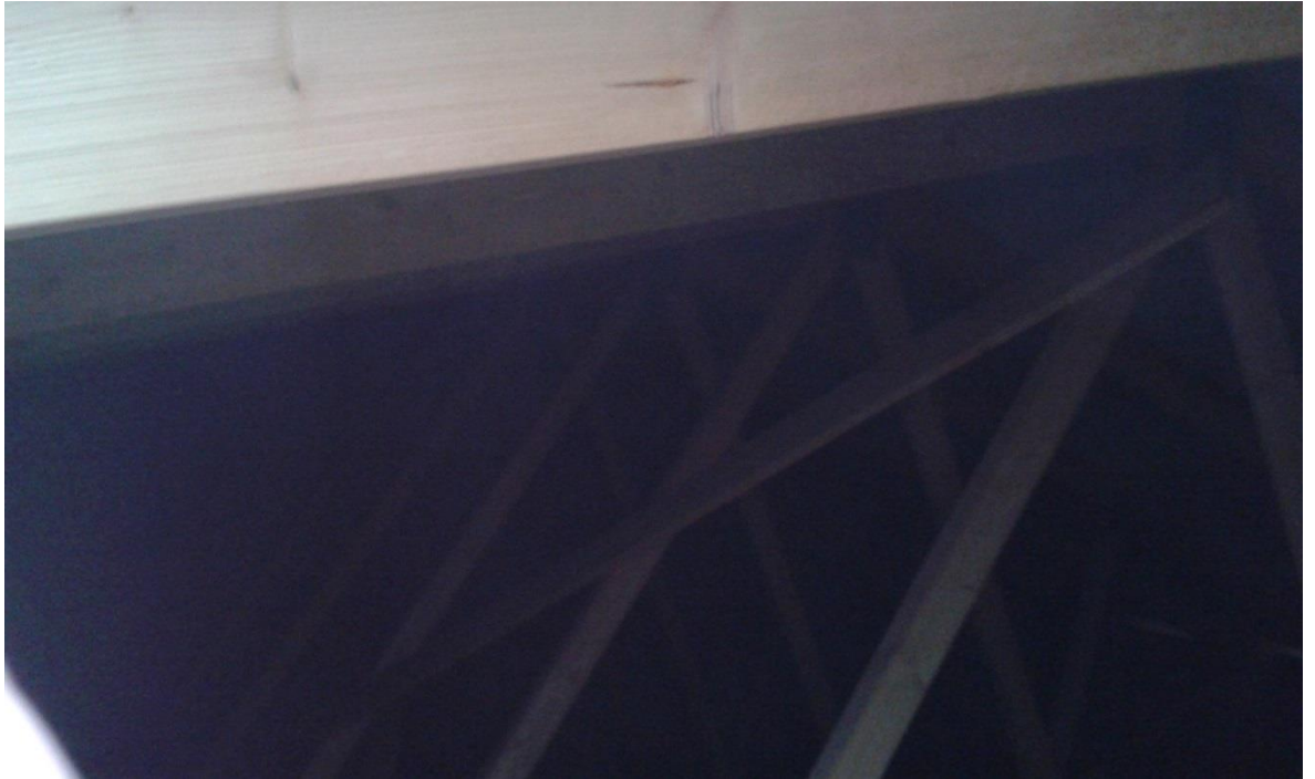
Kuva 28. Vesikattorakenteet, rakenne on jäykistetty vinolaudoituksella.
