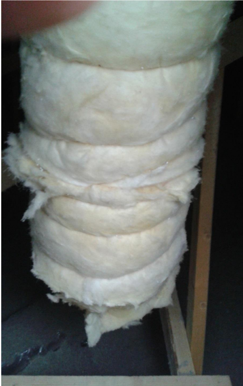
Kuva 30. Poistoilmakanavan eristys
