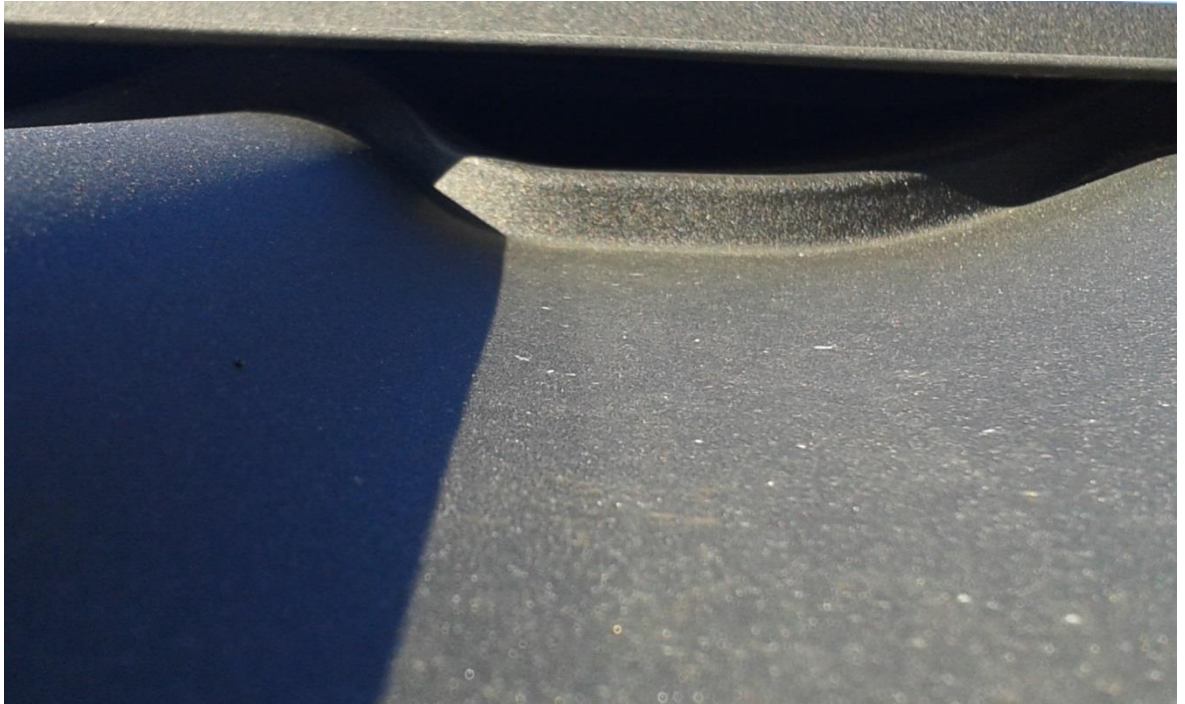
Kuva 26. Harjatiivisteet puuttuvat.
