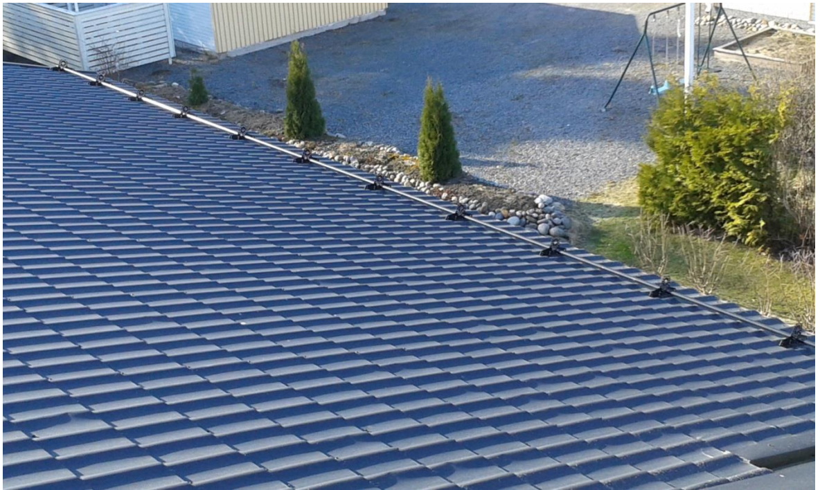
Kuva 21. Päärakennus, lumiasteiden yläorret puuttuvat.
