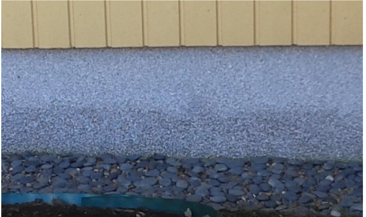
Kuva 17. F-huoneiston sokkelin tummentuma
