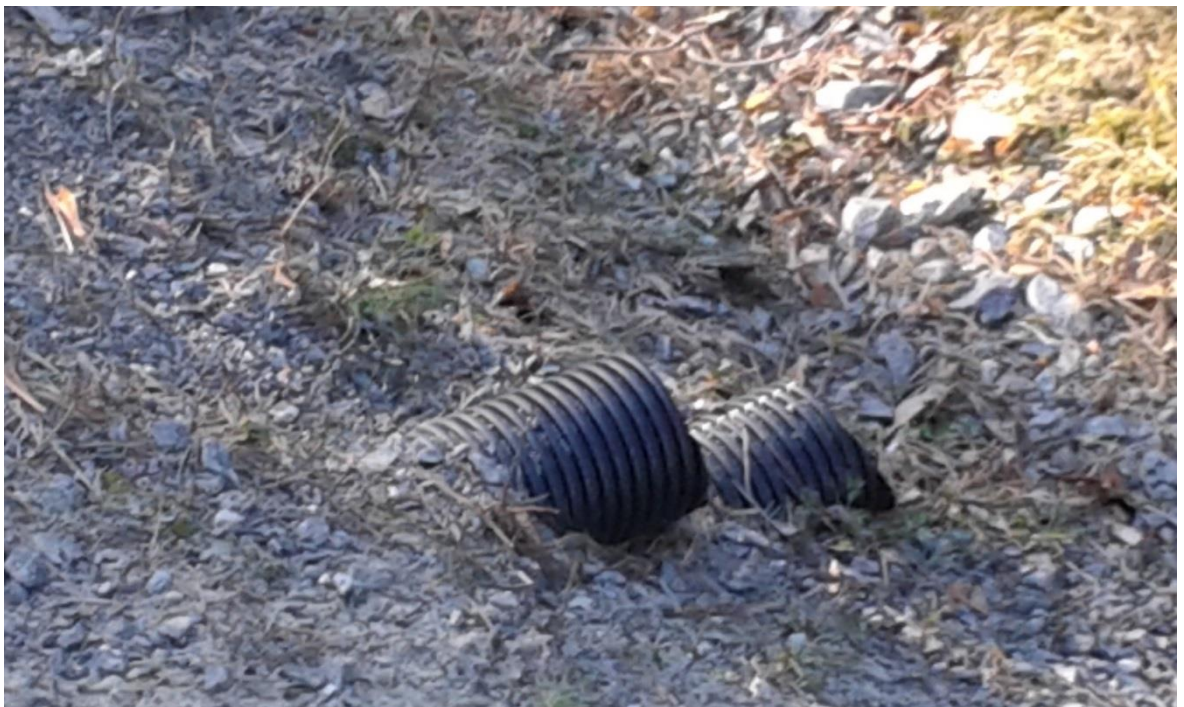
Kuva 3. Kattovesien purku tonttiojaan.
