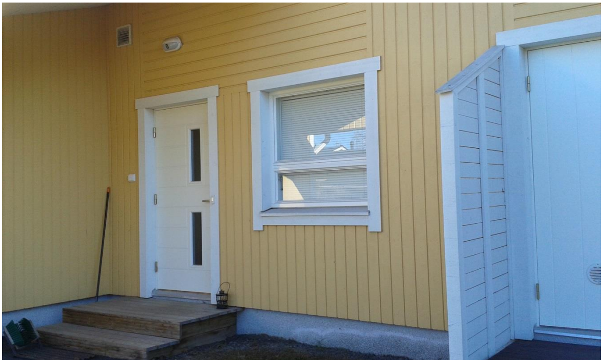
Kuva 8. Ovet ja ikkunat.
