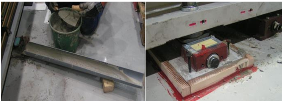
Kuvat 21 a ja b. Säätojalan valaminen
