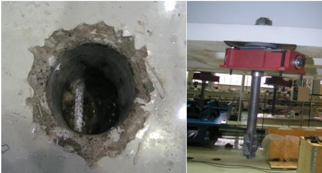
Kuva 20 a ja b. Säätojalkojen esiasennus
