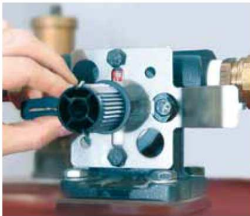
KUVIO 25. OUMAN EH-800 -säätimen asennus (Ouman EH-800 älykäs lämmönsäädin omakotitaloihin).
