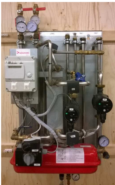
KUVIO 15. Högfors UNIS 100-2R -lämmönvaihdinpaketti (Hattunen 2014).
