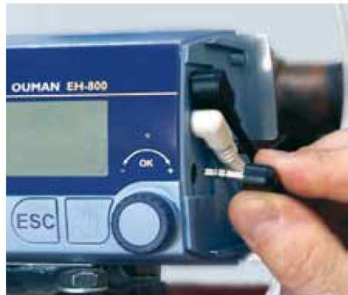
KUVIO 25. OUMAN EH-800 -säätimen asennus (Ouman EH-800 älykäs lämmönsäädin omakotitaloihin).
