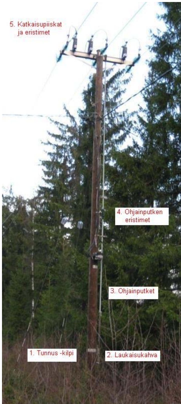
Kuva 10. Linjaerottimen tarkastus kohteet.
