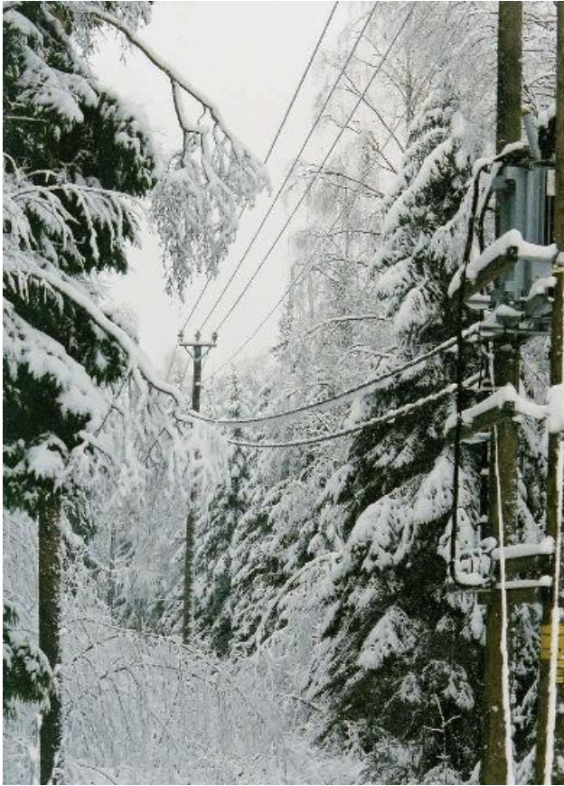
Kuva 4. Vieruspuut linjan läheisyydessä (Ensto, Ilmajohtoratkaisut 6-45 kV, 2007.)
