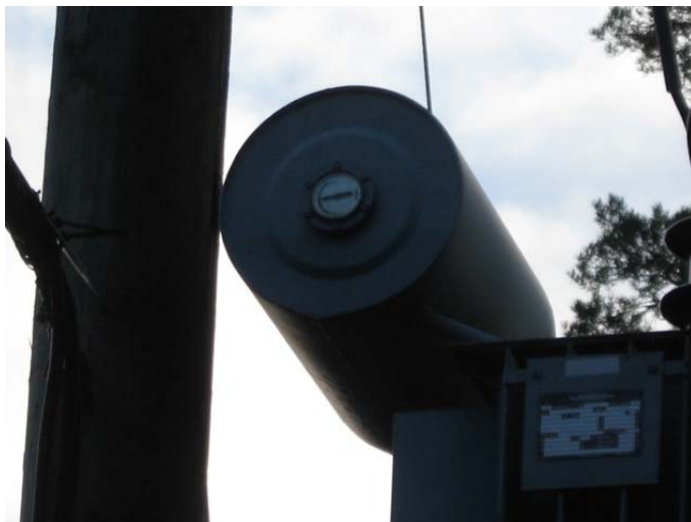
Kuva 11. Muuntajan öljysäiliö.
