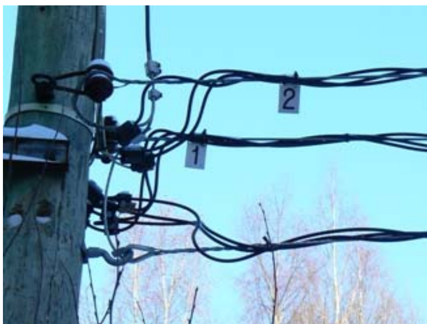
Kuva 12. Puutteelliset lähtömerkinnät muuntamolla (Voimatel Oy, 2008.)
