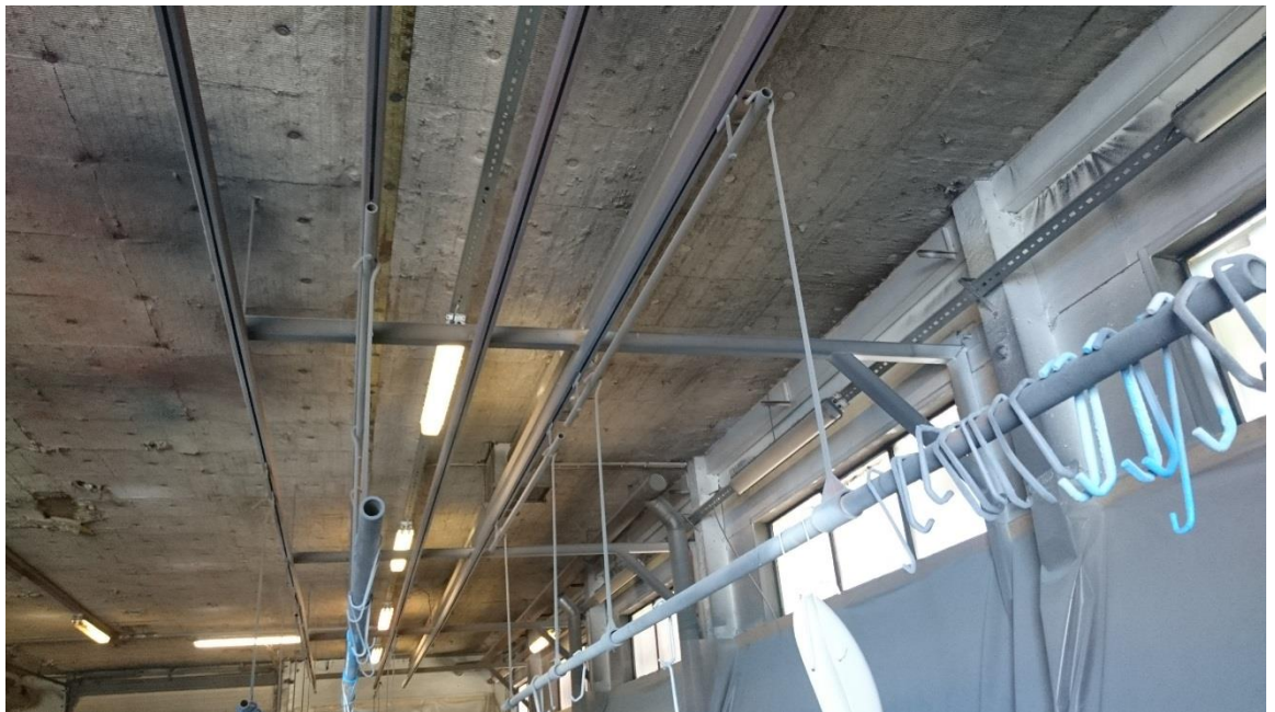
Kuva 20. Hallin katossa sijaitsevat neliosaiset kiskot.
