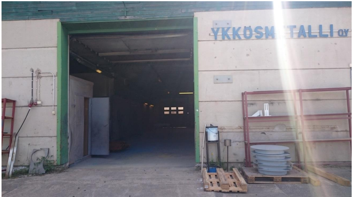
Kuva 11. Vanha maalaamorakennus etupuolelta.
