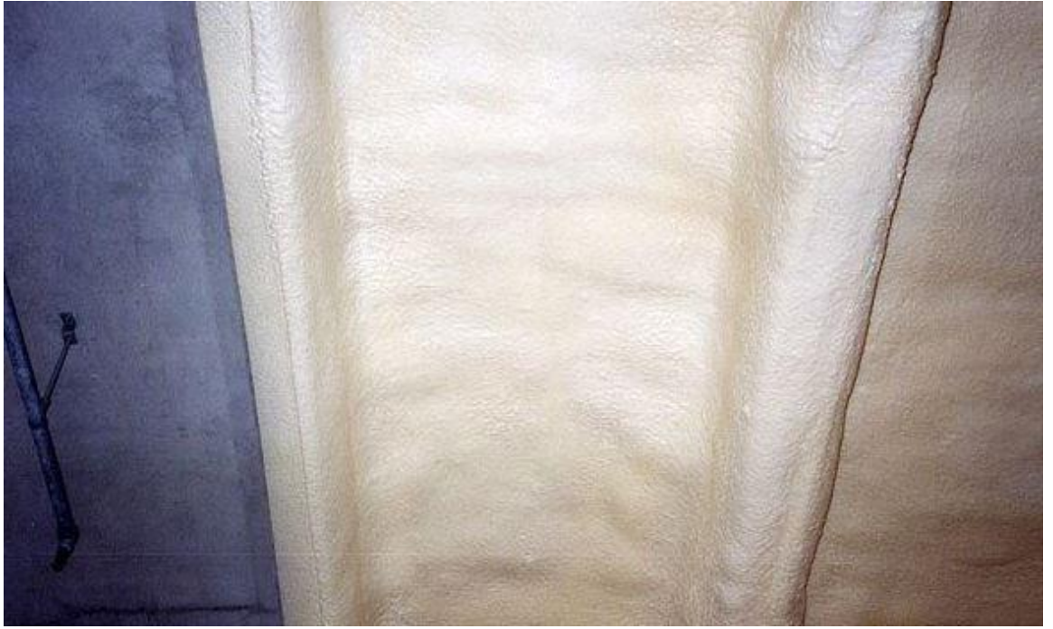
Kuva 34. Kyseinen pinta on käsitelty polyuretaaniruiskuseoksella. [12]
