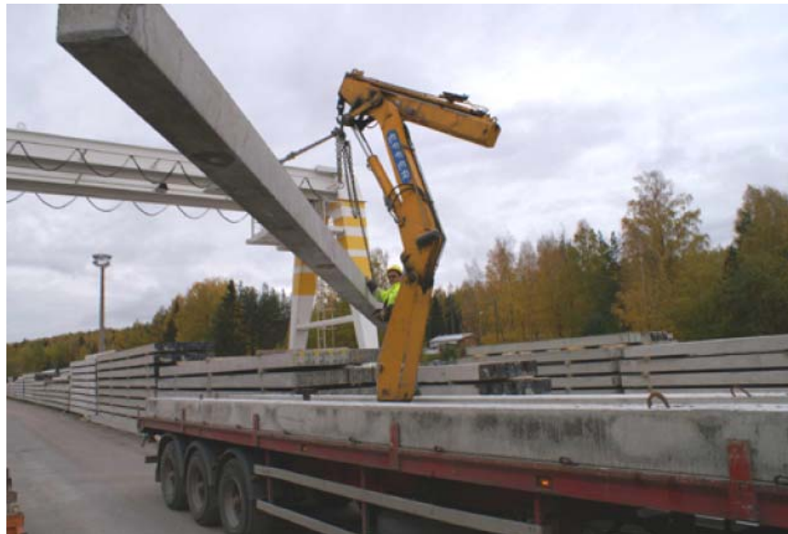
Kuva 12 Paalukuorman kasaus tehtaalla /5/
