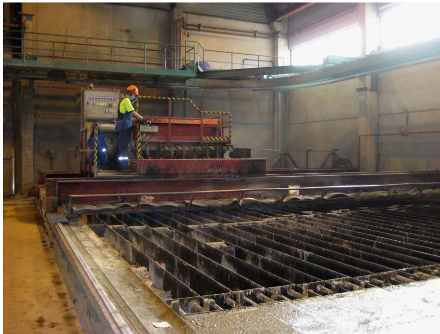
Kuva 9 Valukone muottikentän päällä
