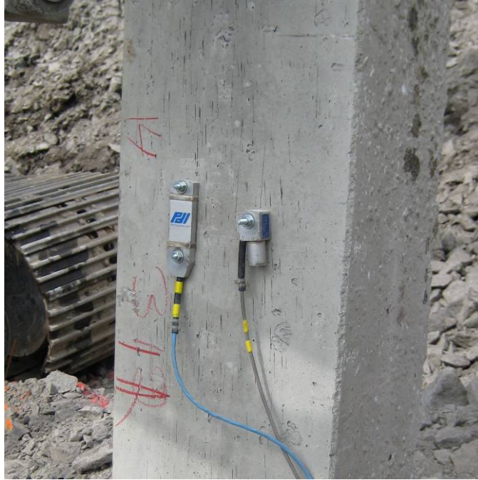
Kuva 22 PDA-sensorit paalun pinnassa
