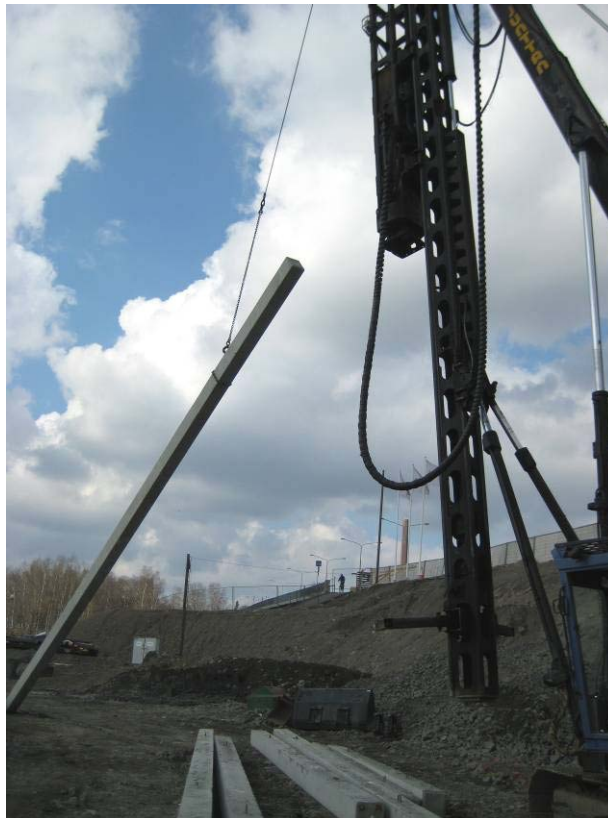
Kuva 17 Paalun nostaminen paalutuskoneeseen
