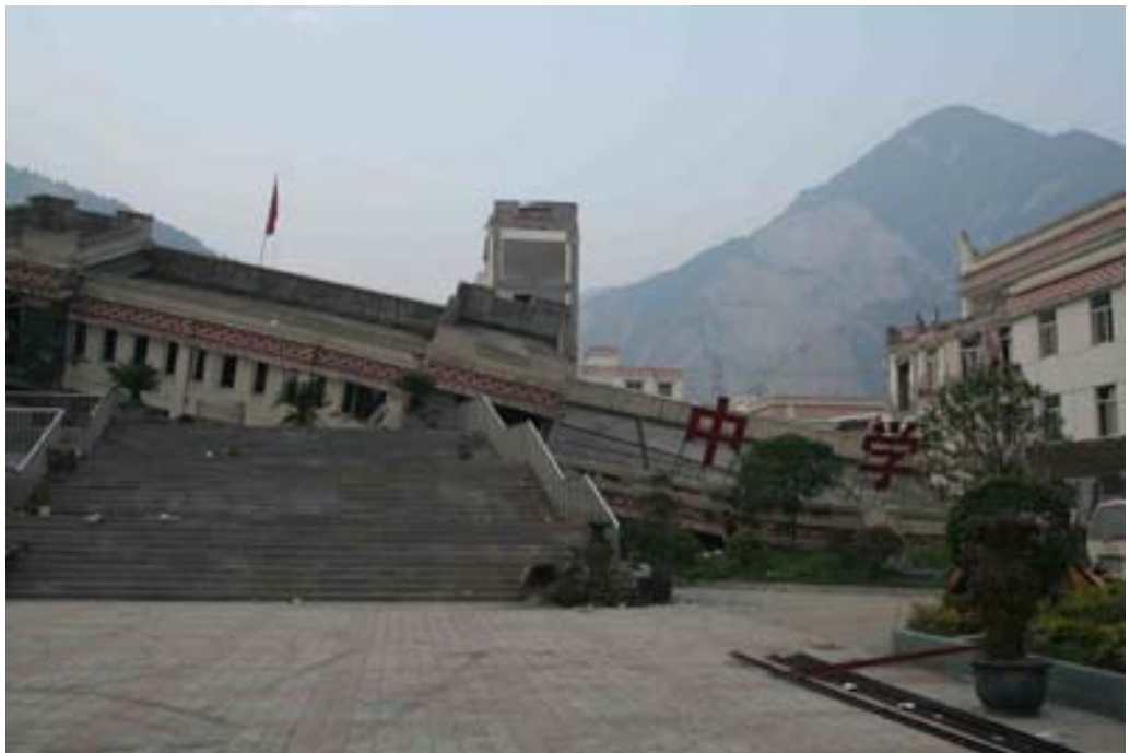
Kuva 1 Maanjäristyksen tuhoama koulurakennus Kiinassa /8/.
