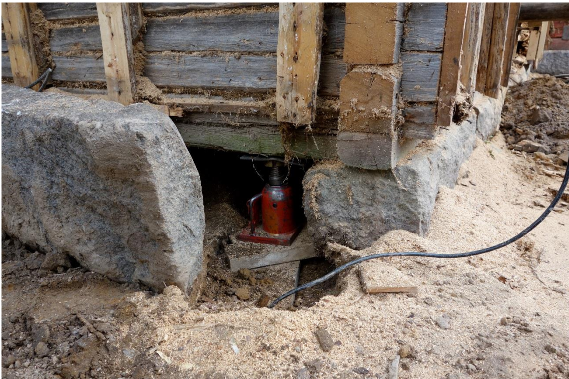
KUVA 20. Seinän alapuolinen tuenta Koivulassa uutta perustusta varten
