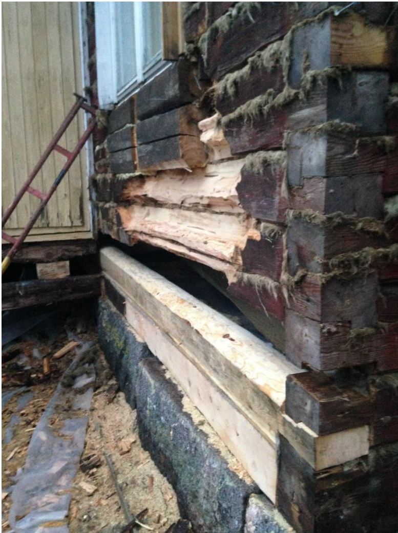
KUVA 27. Salin hirsirungon paikkauksia Koivulassa
