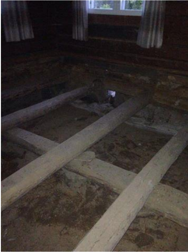
KUVA 23. Koivulan vanhan torpan puoliset säilytettävät alapohjan puurakenteet
