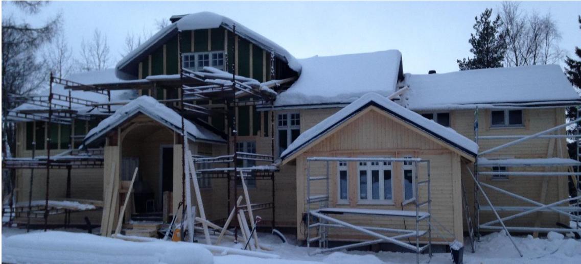
KUVA 28. Koivulan pihanpuoleisen julkisivun rakennusvaihe
