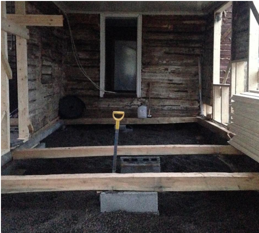
KUVA 21. Keittiön ja piian kammarin alapohja rakennettiin kokonaan uudelleen
