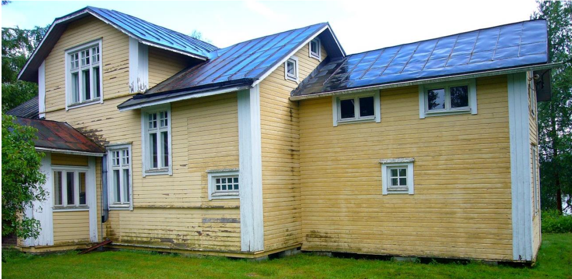
KUVA 8. Pihanpuoleisen julkisivun osa, jossa purettu eteinen on ennen sijainnut
