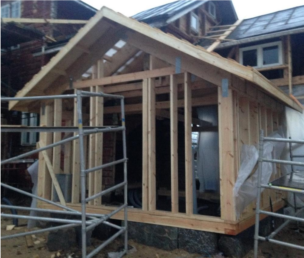
KUVA 37. Koivulan laajennusosan runko valmiina
