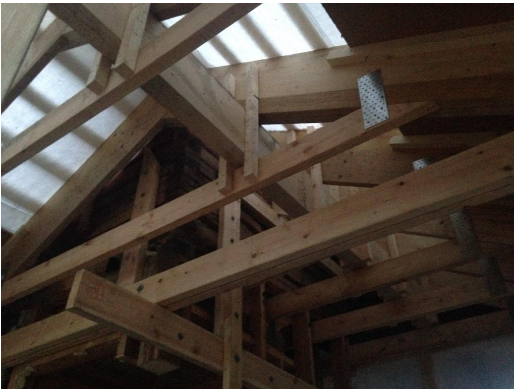
KUVA 38. Koivulan laajennusosan kattorakenne
