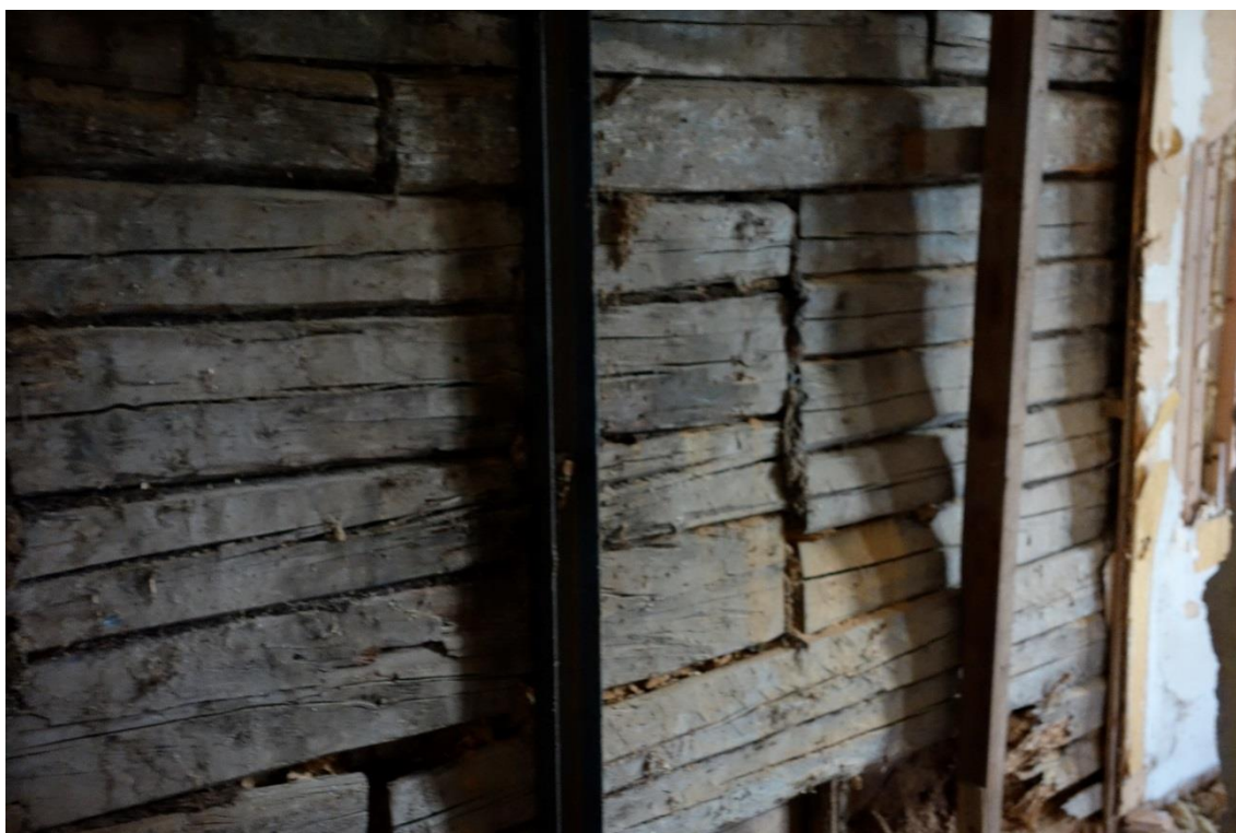
KUVA 12. Vanhoja rungon korjauksia näkyvillä Koivulassa
