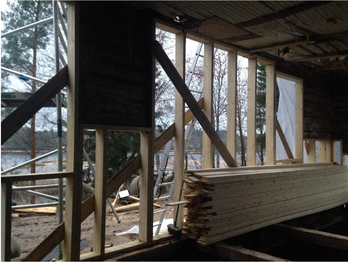
KUVA 26. Rungon korjauksia piian päädyssä Koivulassa
