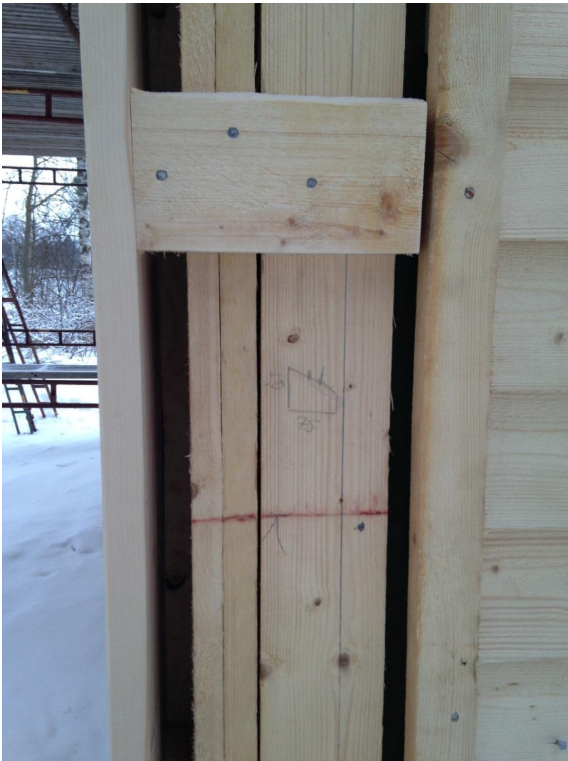
KUVA 30. Leveän nurkkalauoituksen tuulettuva rakenne
