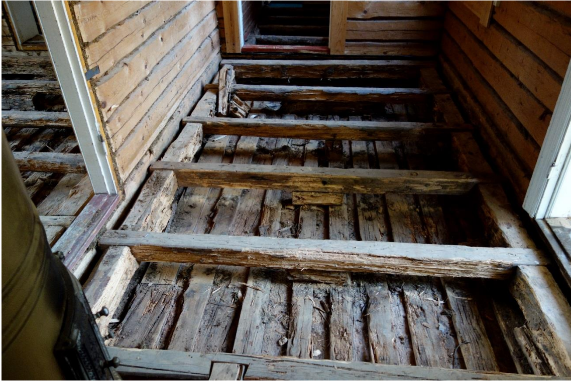
KUVA 10. Alapohjan laudoitus, korotuspalkit ja laiturirakenne
