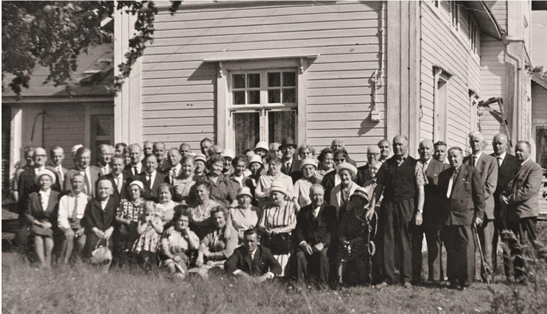
KUVA 9. Vanhassa valokuvassa näkyvillä Koivulan alkuperäiset ikkunat, nurkkalaudoitukset sekä osa puretusta eteisestä (Häikiö 2012)
