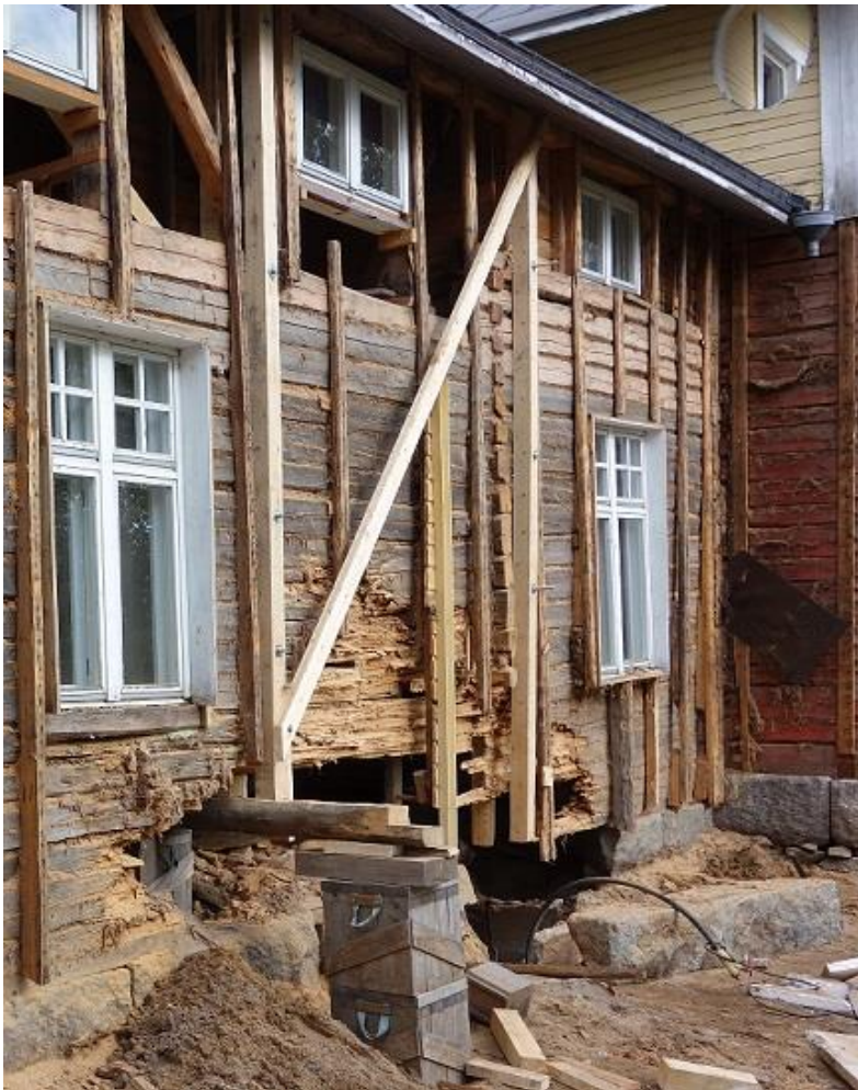
KUVA 25. Hirsiseinän korjauksenaikainen tuentatapa
