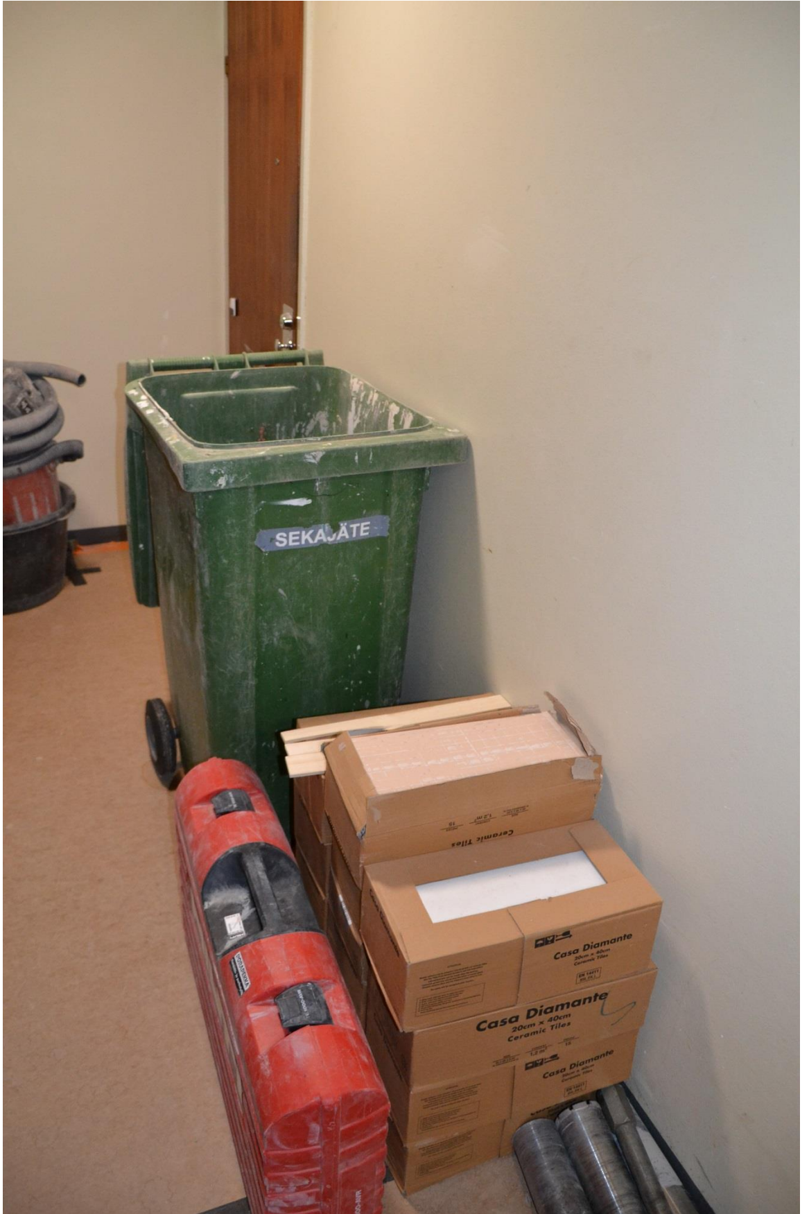
Kuva 23. Jäteastia kerroksessa purkujätteitä varten.
