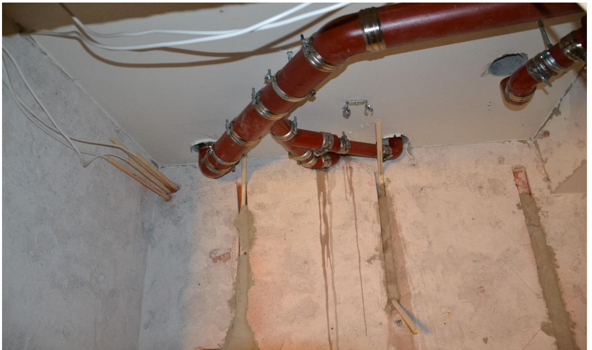
Kuva 22. Yläpuolella olevasta kylpyhuoneesta tulevat uudet putket.
