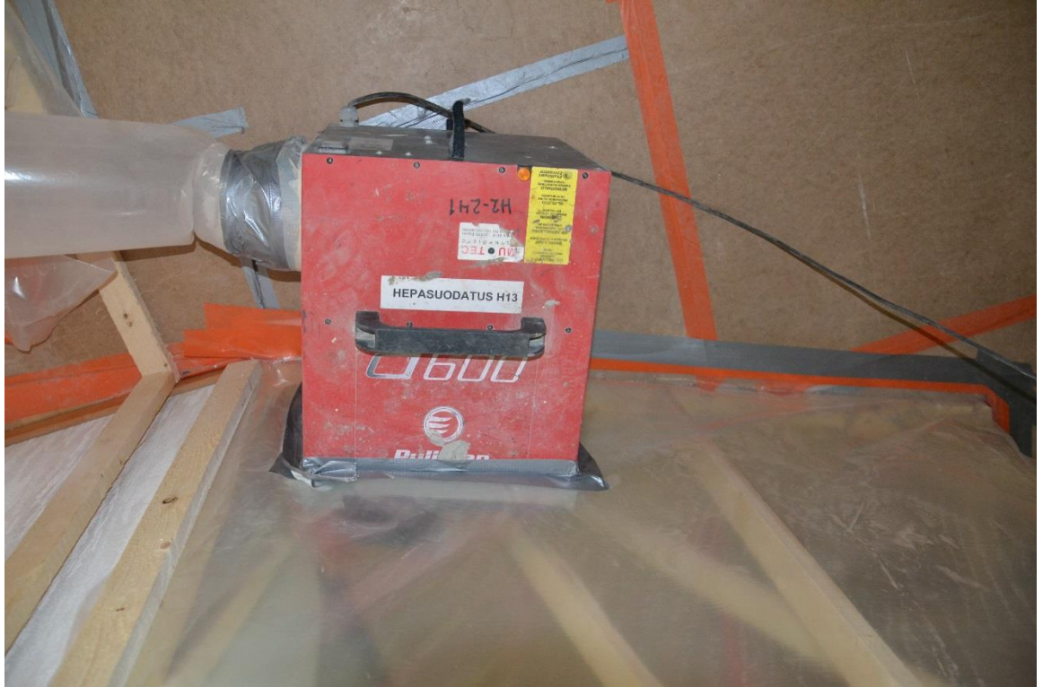
Kuva 17. HEPA H13 -suodattimella varustettu käynnissä oleva alipaineistaja.
