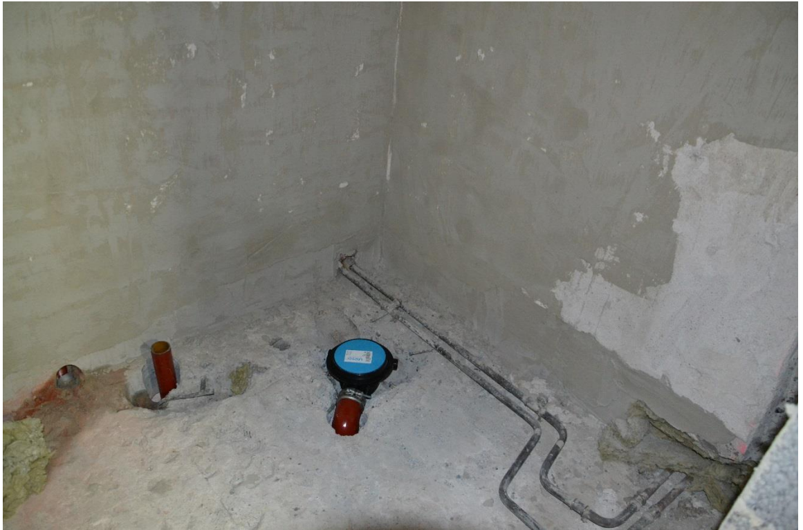
Kuva 20. Betonia on piikattu uusia putkistoja varten.
