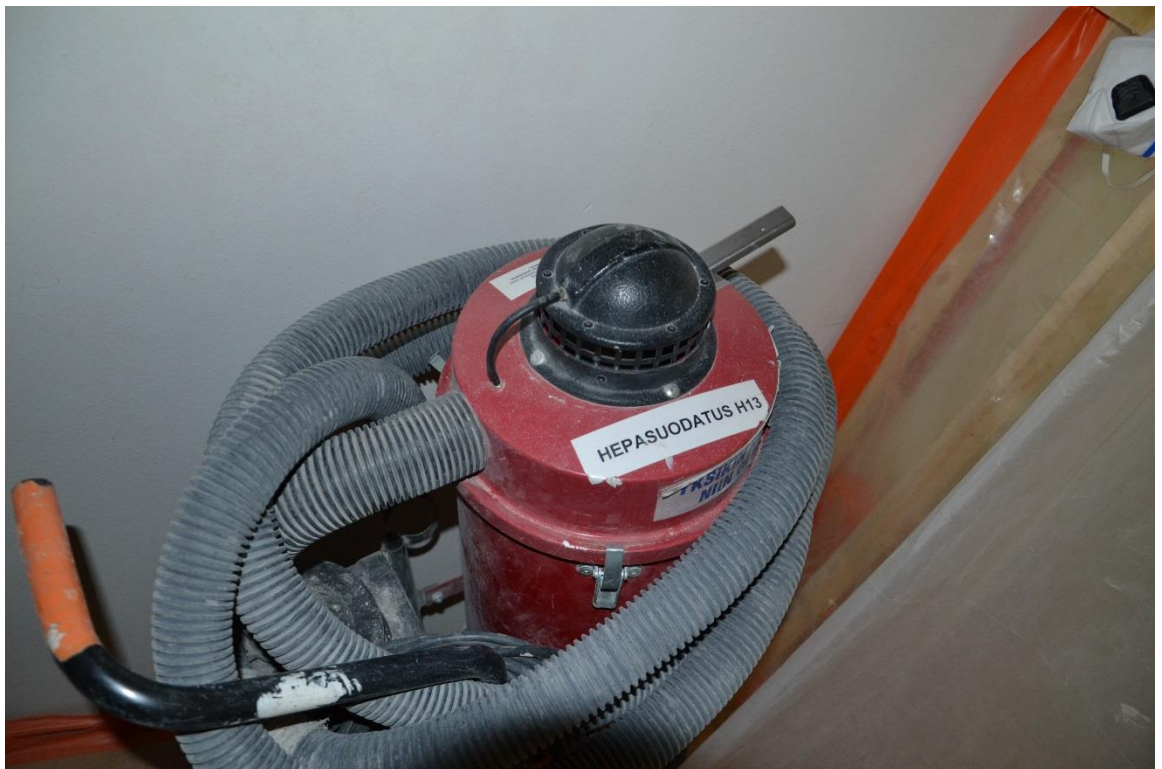
Kuva 7. Työmaalla oleva pölynimuri, joka on varustettu HEPA H13 -suodattimella.
