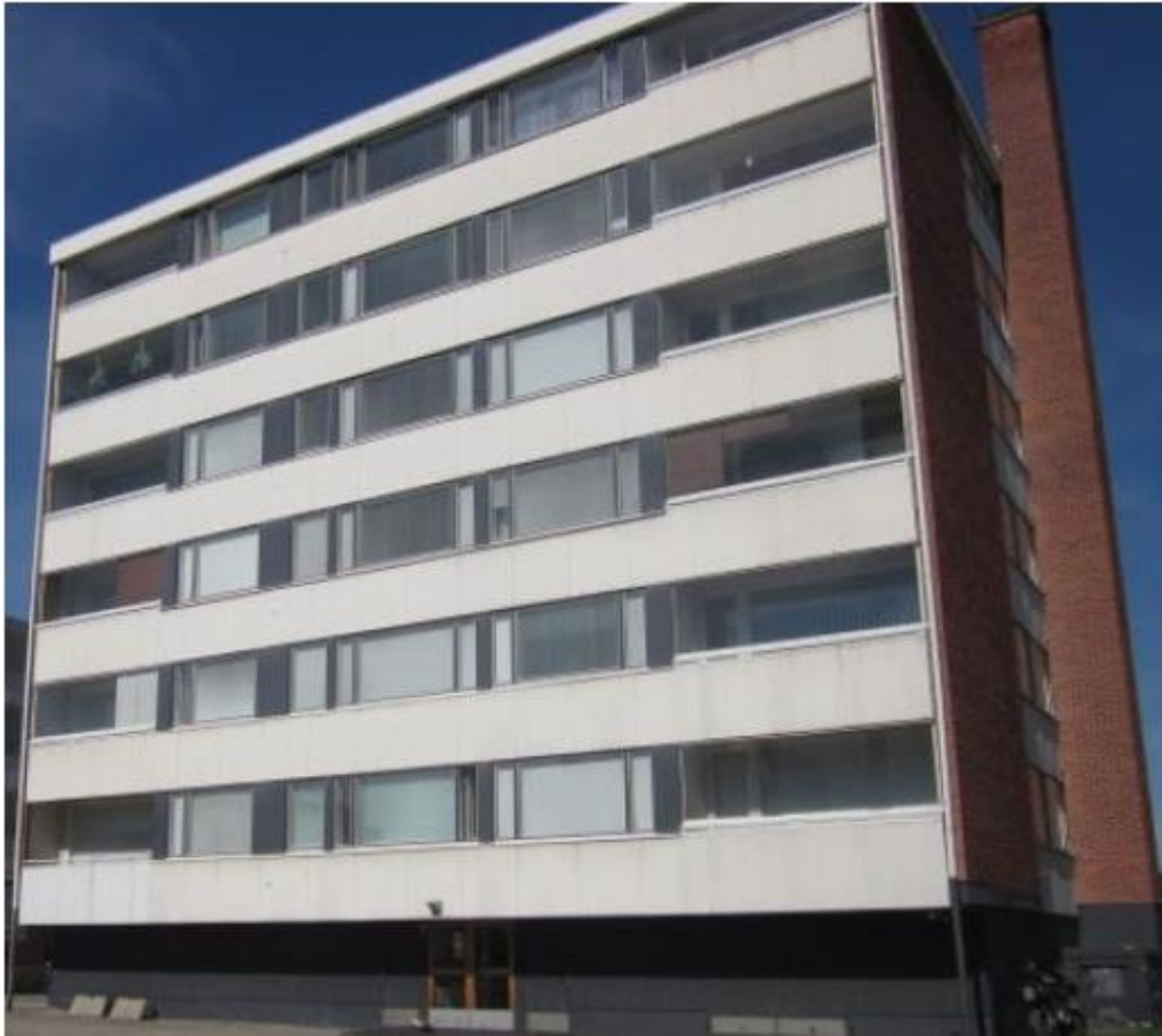
Kuva 15. Julkisivukuva kohteesta Brahenkatu 12, Kajaani.
