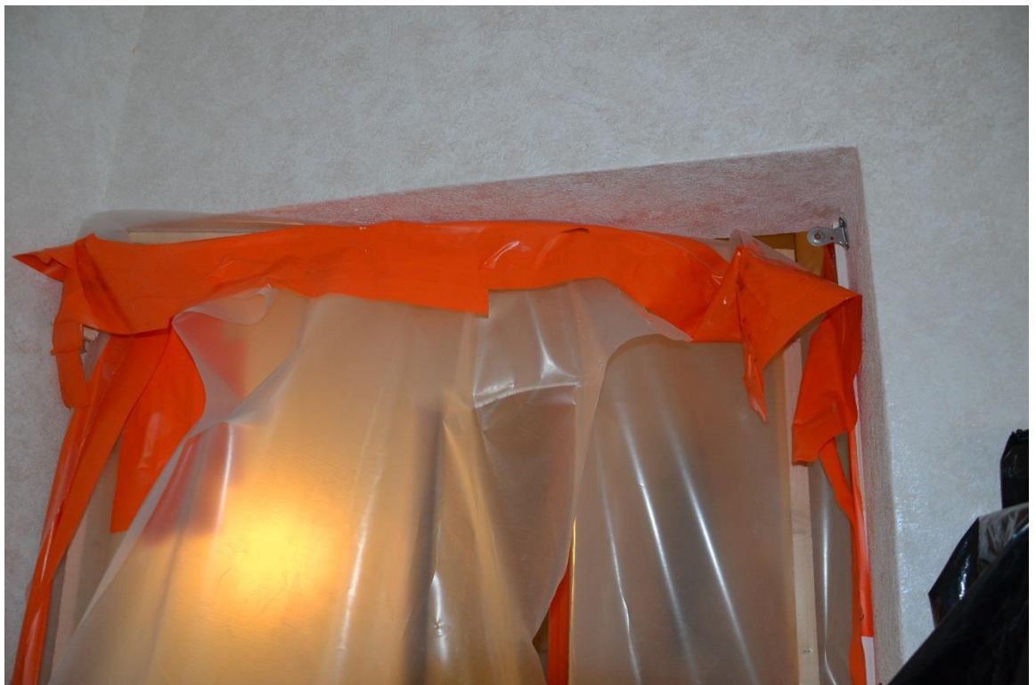
Kuva 10. Rikkonainen suojaseinä.
