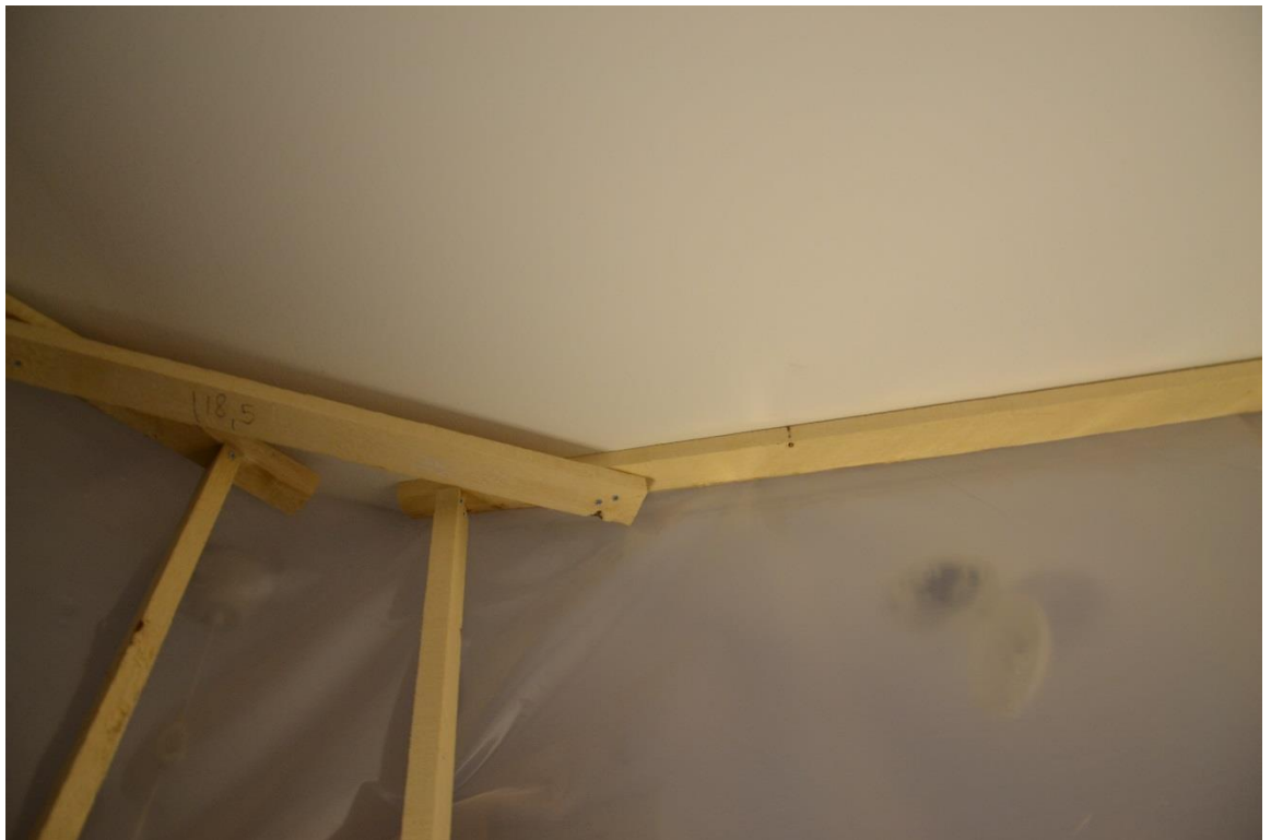
Kuva 16. 22x50 mm rimoista tehty tukirakenne suojaseinille.
