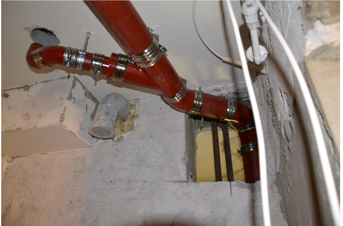
Kuva 21. Valurautaisten viemäriputkien liittyminen rakennuksen putkikuiluun.
