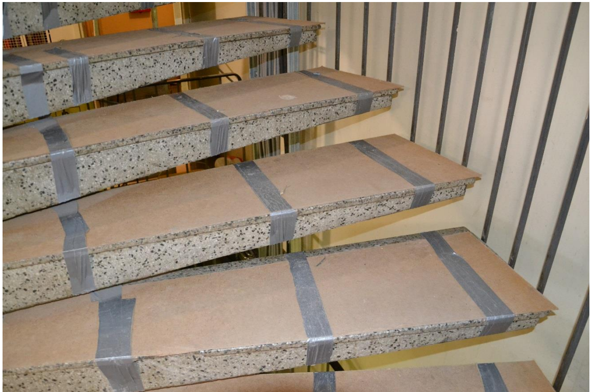
Kuva 24. Pahvien ja teippauksien avulla suojattu portaikko.
