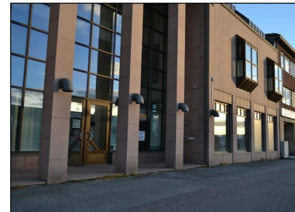
Kuva 1. Tyhjiällä oleva pankkirakennus Kemijärven keskustassa (Hyytiäinen, 2013)
