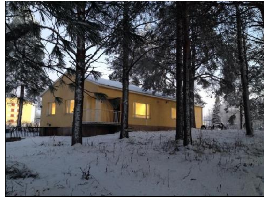
Kuva 12. Kylätalon julkisivu takapihan puolelta (Hyytiäinen, 2014)
