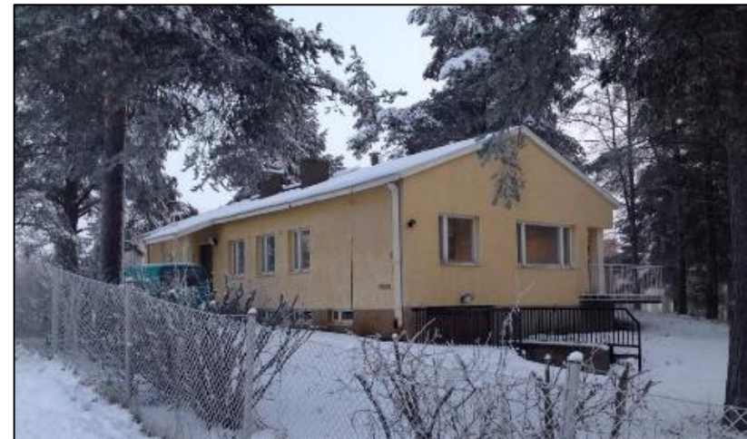
Kuva 13. Kylätalon julkisivu tontin etupuolelta (Hyytiäinen, 2014)
