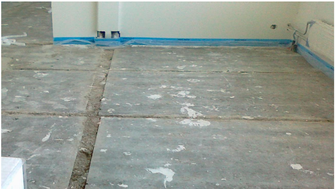
KUVA 17. Ontelolaattojen korkoeroa tuli pienentää ennen lattiatarvikkeiden asennusta
