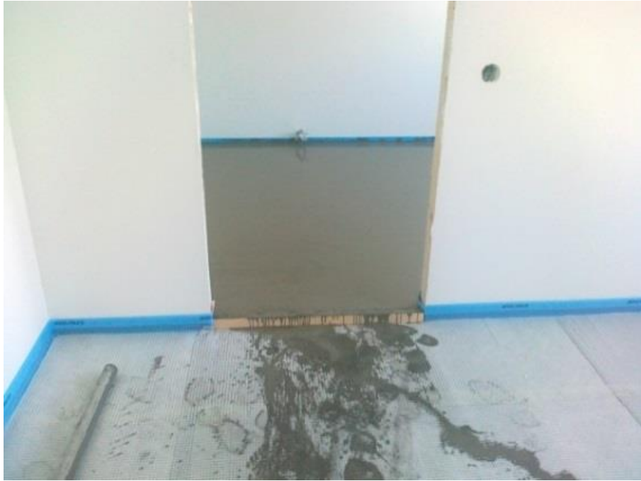
KUVA 13. Valettavat alueet rajattiin stoppareiden avulla, jotta valetut lattiat ehdittiin työstää ennen niiden kuivumista
