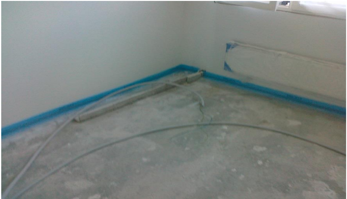
KUVA 18. Ulkoseinäelementin kiinnitysteräksiä tuli madaltaa ja lyhentää ennen lattiatarvikkeiden asennusta
