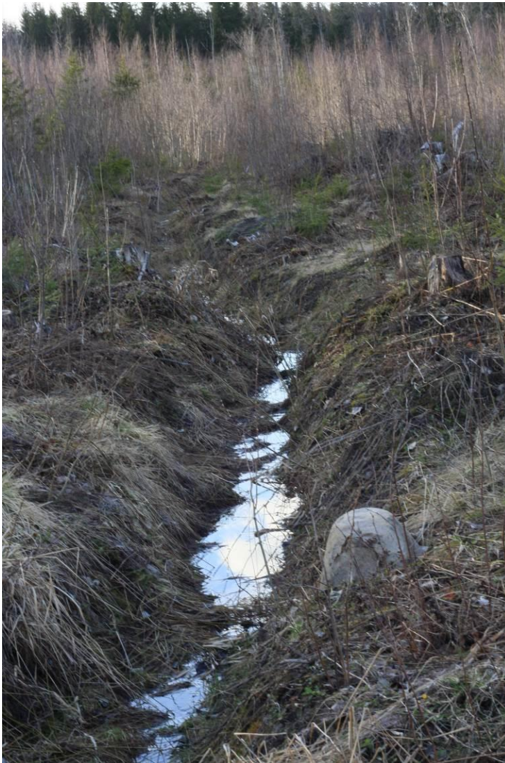
Kuva 6. Alueella on kaivettu kuivatusojia. 28.4.2015. (Kuva: Sonja Purho)
