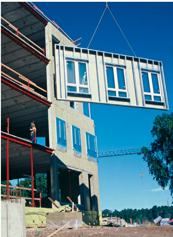
Kuva 6.31 Tasaisten, esivalmistettujen seinäelementtien asentaminen teräsrunkoon.
