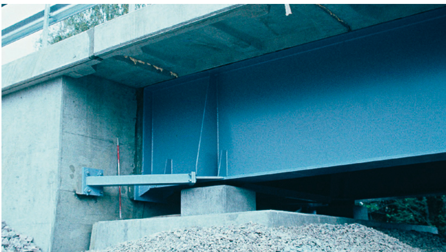
Kuva 7.13 Liittopalkkisilta, jossa on kynnysmuurit.
