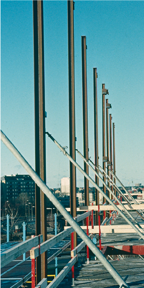
Kuva 9.17 Pilareiden jäykistäminen ankkurointituilla.
