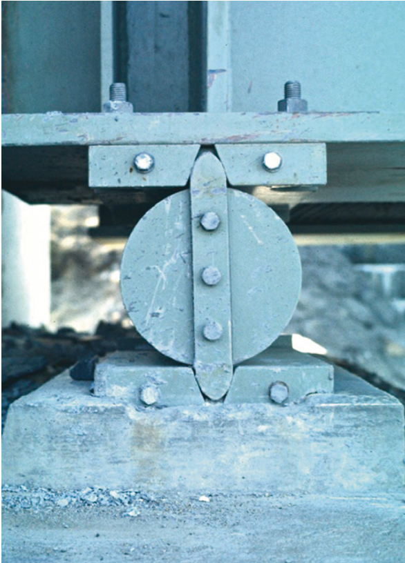
Kuva 7.10 Esimerkki liikkuvasta siltalaakerista.
