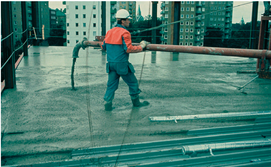
Kuva 14.21 Liittoväli­pohjan valaminen.
