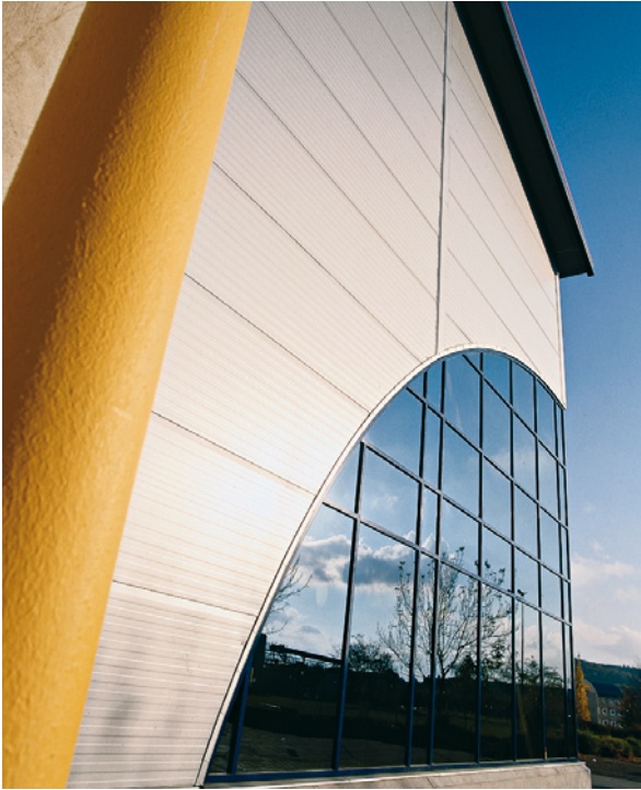
Kuva 13.1 Kinnarps Arenan seinät on rakennettu Plannjan sandwich-paneeleista.
