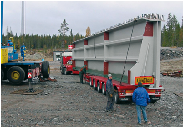
Kuva 3.10 a Hitsattu I-palkki siltarakenteeseen.
