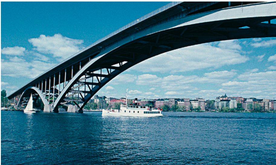
Kuva 1.6 Tukholmassa Ridarfjärdenin yli kulkeva Västerbron-silta muodostuu kahdesta tyylikkästä kaaresta, jotka on rakennettu niitatuista teräslaatikoista. Hyvä esimerkki teräsrakenteiden pysyvyydestä on se, että silta oli maalattava uudelleen vasta 50 vuoden kuluttua sen valmistamisesta.
