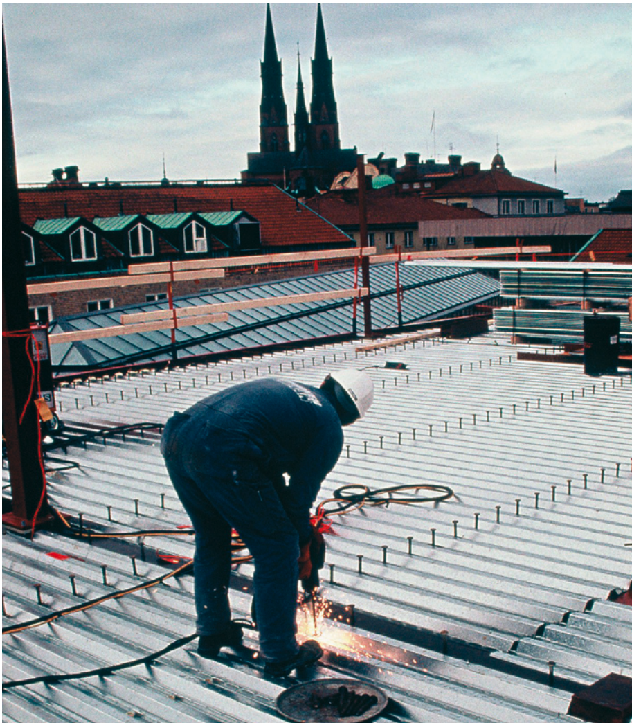
Kuva 14.3 Työn alla oleva välipohja. Liittopalkit kuuluvat kantavaan rakenteeseen.
