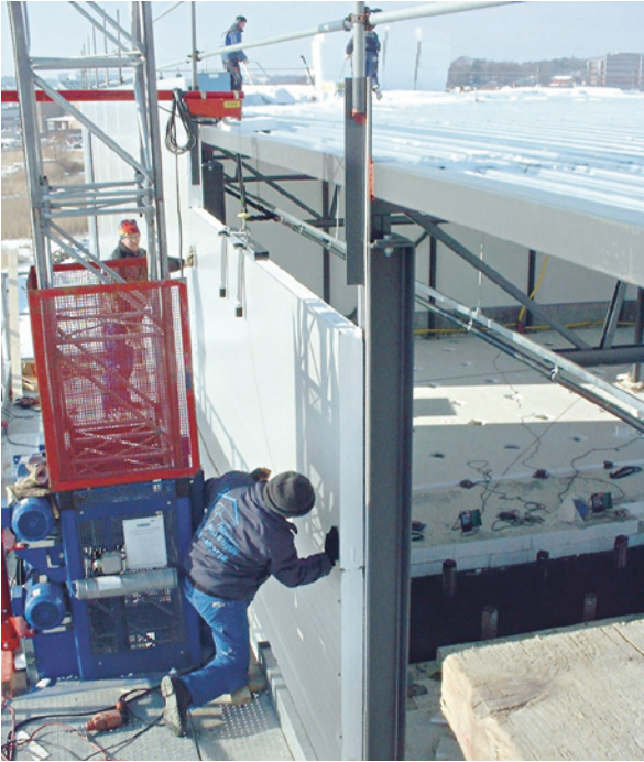
Kuva 13.42 Pilareihin nojaavien sandwich-paneelien asennus.
