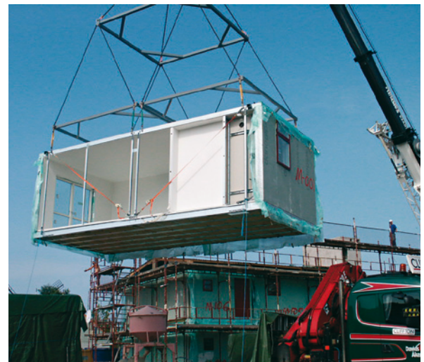
Kuva 6.32 Esivalmistettujen massatuotantoelementtien asentaminen terästukirunkoon.
