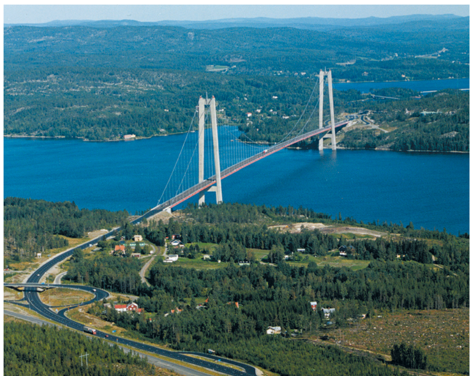
Kuva 7.25 Högabron on Ruotsin pisin riippusilta. Sen kokonaispituus on 1 800 metriä, ja kahden 180 metriä korkean pylonin (siltapilarin) välinen jänneväli on 1 210 metriä.
