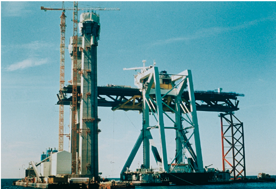
Kuva 7.24 Öresundin sillan kansiosia nostetaan paikoilleen.
