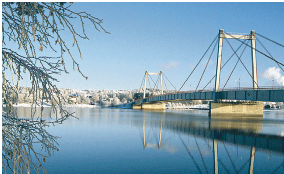
Kuva 7.22 Strömsundin silta (Ruotsissa).
