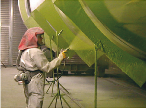
Kuva 11.4 Levitys korkeapaineruiskutuksella. Tämä on tavallisin ruostesuojamaalin levitysmenetelmä.
