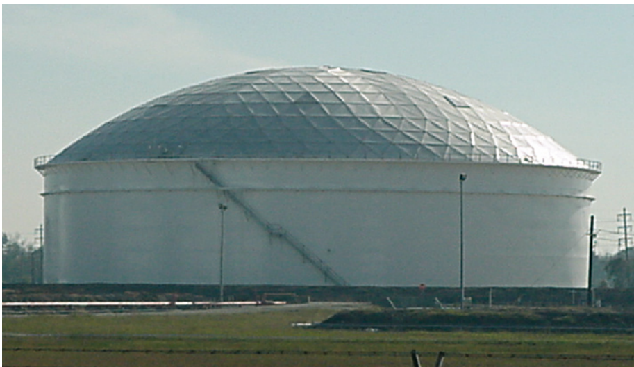
Varastointisäiliö on maalattu ulkoapäin uusimmalla maalityypillä, akryylimodifoidulla polysiloksaanilla.
