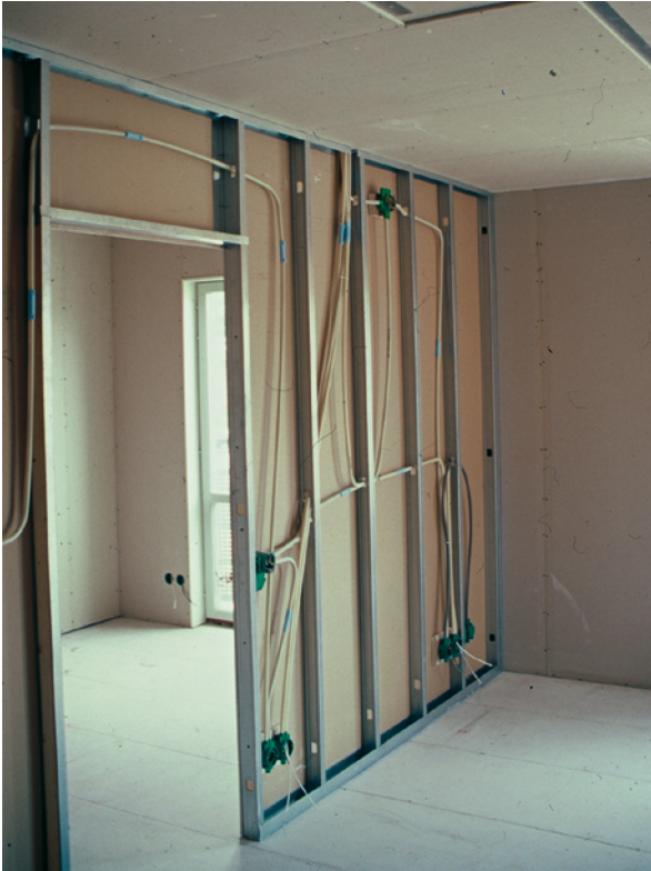
Kuva 6.23 Huoneet toisistaan erottava sisäseinä.
