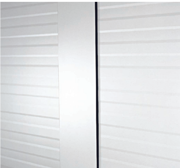
Kuva 13.44 Peitetty paneelien välinen päätyliitos.
