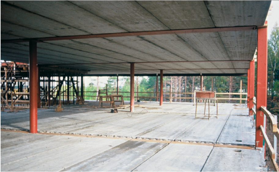
Kuva 6.2 Kun rakennuksessa on käytetty pila-ri-palkkirakennetta, jossa on tai ei ole sisäisiä pilaririvejä, tilaa on mahdollista käyttää joustavasti: huoneiden väliset seinät voidaan sijoittaa hyvin vapaasti, ja muutoksia on helppo tehdä jälkepäin.
