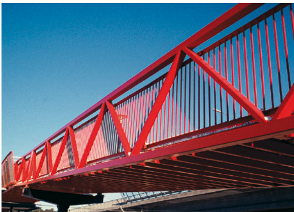
Kuva 3.10 c Hitsattu ristikkopalkki siltarakenteeseen.
