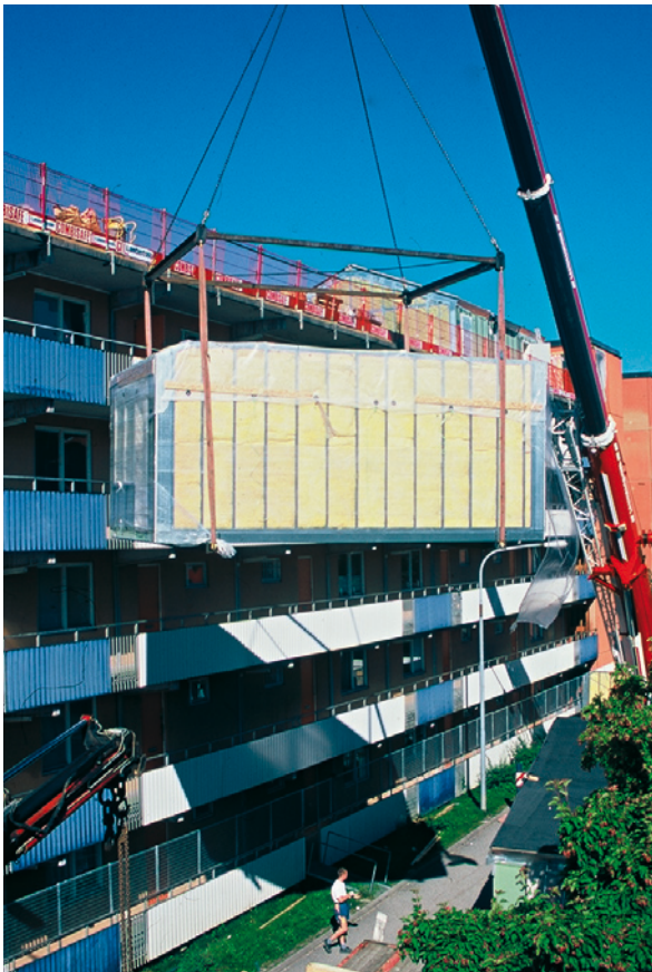
Kuva 6.29 Olemassa olevan asuinrakennuksen päällera- kentämisessä käytettäviä moduuleja. Koska rakennelman omapaino on matala, vältetään olemassa olevan raken- nuksen jäykistämiseltä jne.
