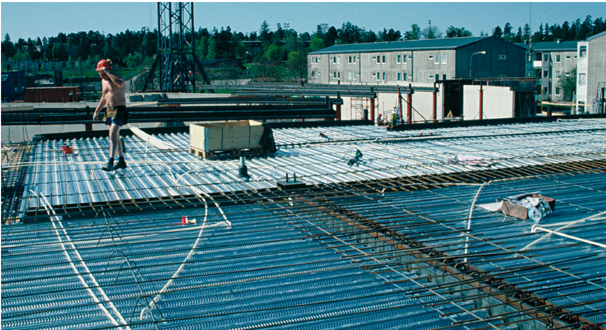
Liittorakenne välipohjassa.
