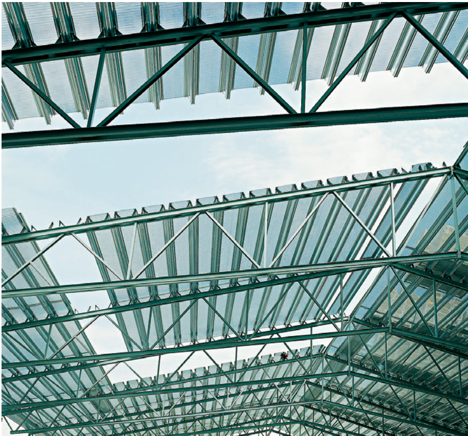
Kuva 13.17 Profiloitu levy kattorakenteessa.
