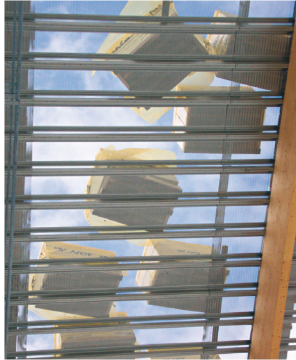
Kuva 13.2 Perforoitu profiloitu levy takaa hyvän äänieristyksen.
