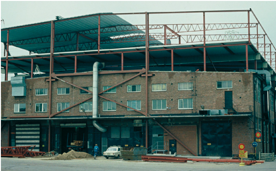
Kuva 1.15 Teräsrunkoista lisärakentamista teollisuuskohteessa.
