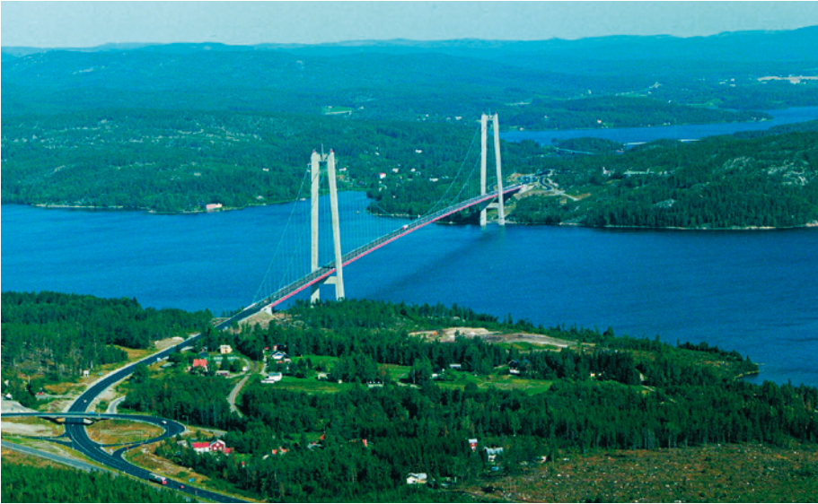
Kuva 1.13 Ångermanälven-joen yli kulkevan Högabron -sillan jänneväli on Ruotsin pisin: 1 210 metriä. Riippusilta on rakennettu teräksestä, ja sen ajorata on muodostuu yhdestä teräslaatikosta.
