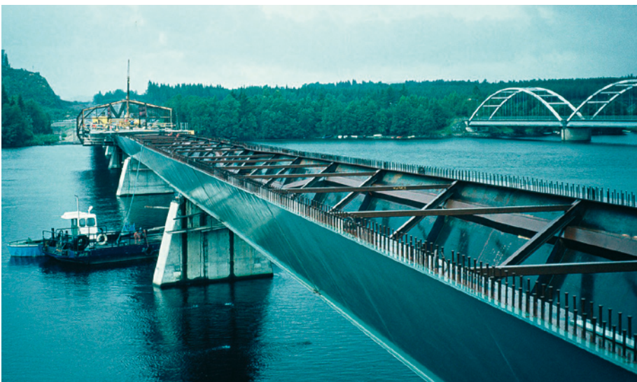
Kuva 7.11 Liittopalkkisilta, jonka ylälaipassa on hitsattuja pultteja.
