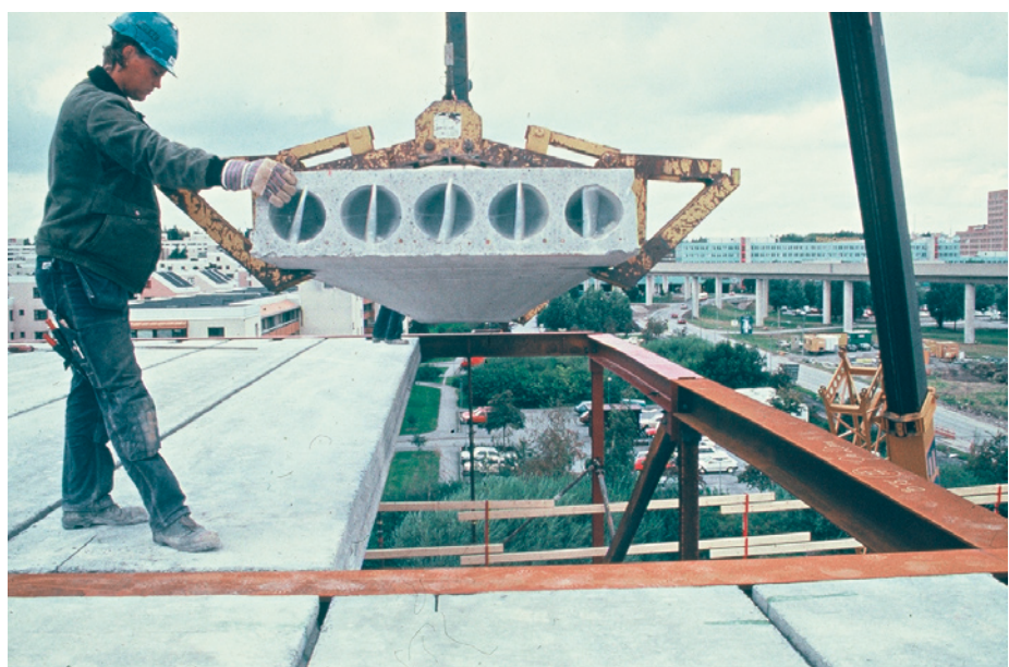
Kuva 9.16 Välipohjaelementtien asentaminen.
