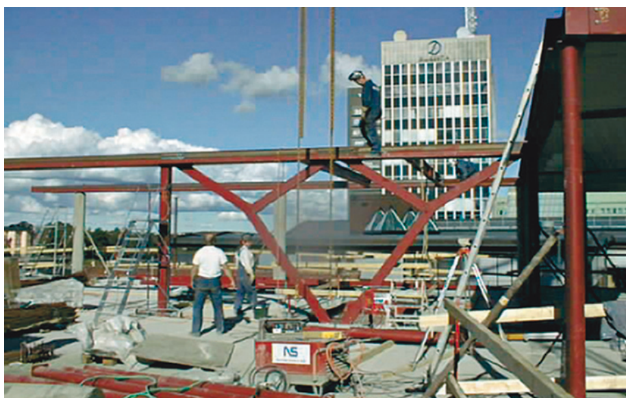
Kuva 9.14 Rakenteilla oleva teräsrunko, asennustyöt kesken.
