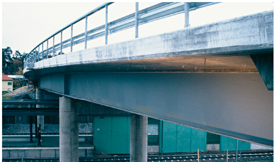
Kuva 14.4 Rautatien yli kulkeva liittopalkkisilta. Silta muodostuu hitsatuista teräspalkeista, jotka toimivat yhteisvaikutuksessa betonisen sillankannen kanssa.
