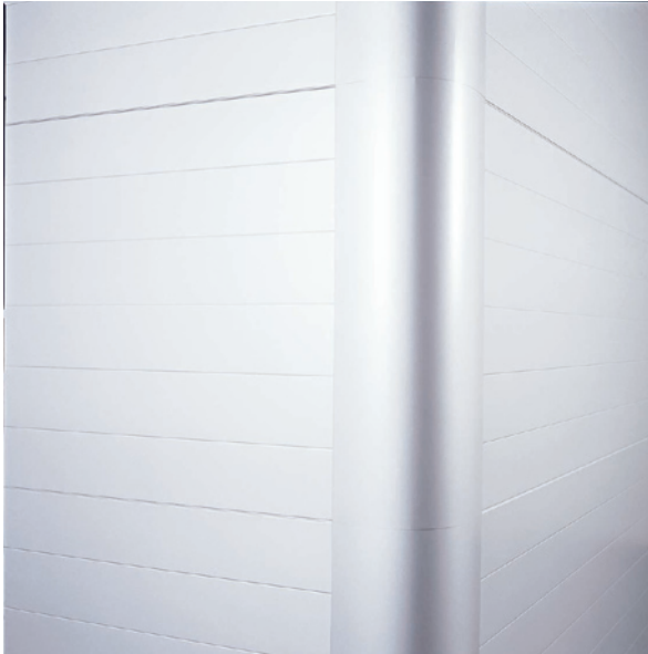
Kuva 13.46 Pyöristetty kulma paneeliseinässä.
