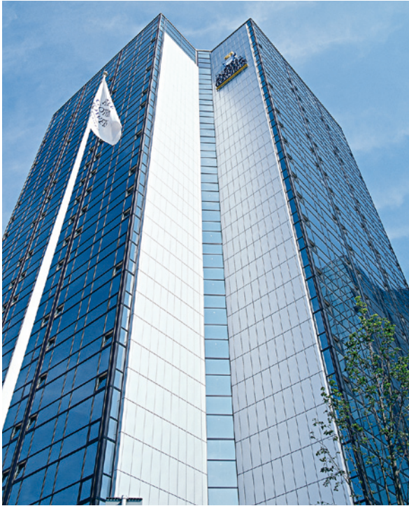
Kuva 6.25 Sandwich-elementeistä valmistettu ulkoseinä. Vasemmalla Göteborgissa sijaitsevan Hotel Gothia Twin Towers, jossa ulkoseinät muodostuvat sandwich-paneeleista, joita on täydennetty ulkoisilla julkisivukaseteilla ja sisäisellä tukirungolla. Oikeanpuoleisessa kuvassa on tavallinen talorakennuksissa käytettävä sandwich-elementti.
