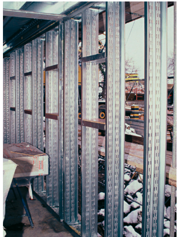
Kuva 1.12 Terästä hyödyntävässä kevytrakentamisessa käytetään ohutlevyprofiileja, kipsilevyjä ja mineraalivillaa. Menetelmää käytetään 3–4-kerroksisten asuinrakennusten rakentamiseen, ja se edustaa teolliseen tuotantoon hyvin soveltuvaa kuivarakennustekniikkaa.
