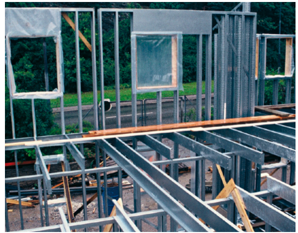
Kuva 6.30 Matalammissa rakennuksissa voi olla kannatta- vaa rakentaa kantavat seinäelementit ohutlevyprofiileista. Kantaviin seiniin kiinnitetään sitten kevyet, teräksiset väli- pohjaelementit.
