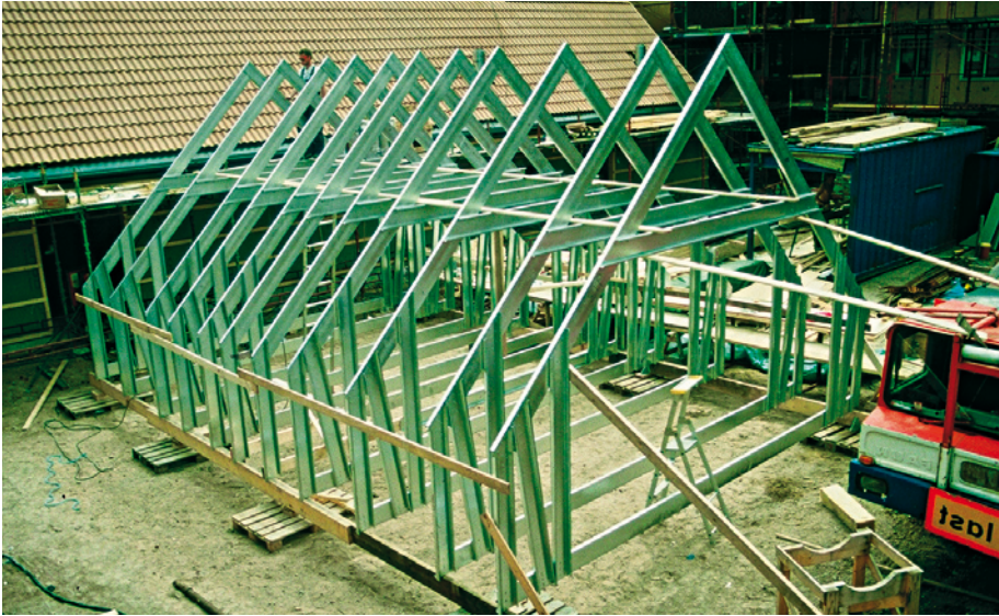
Kuva 6.27 Ohutlevystä valmistettujen kattotuolien eduksi voidaan laskea pieni omapaino ja helppo valmistus.
