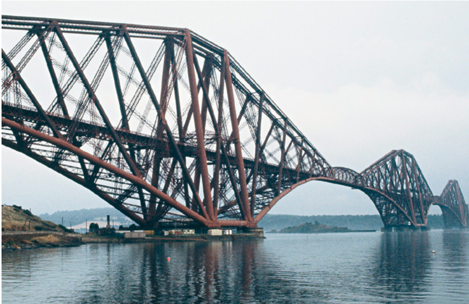
Kuva 7.4 Firth of Forthin silta.
