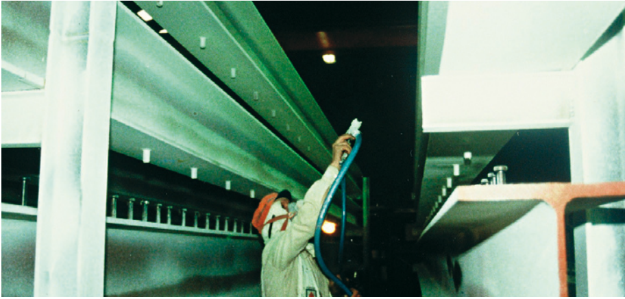
Kuva 10.12 Palonesto- maalin levittäminen ennen asentamista.
