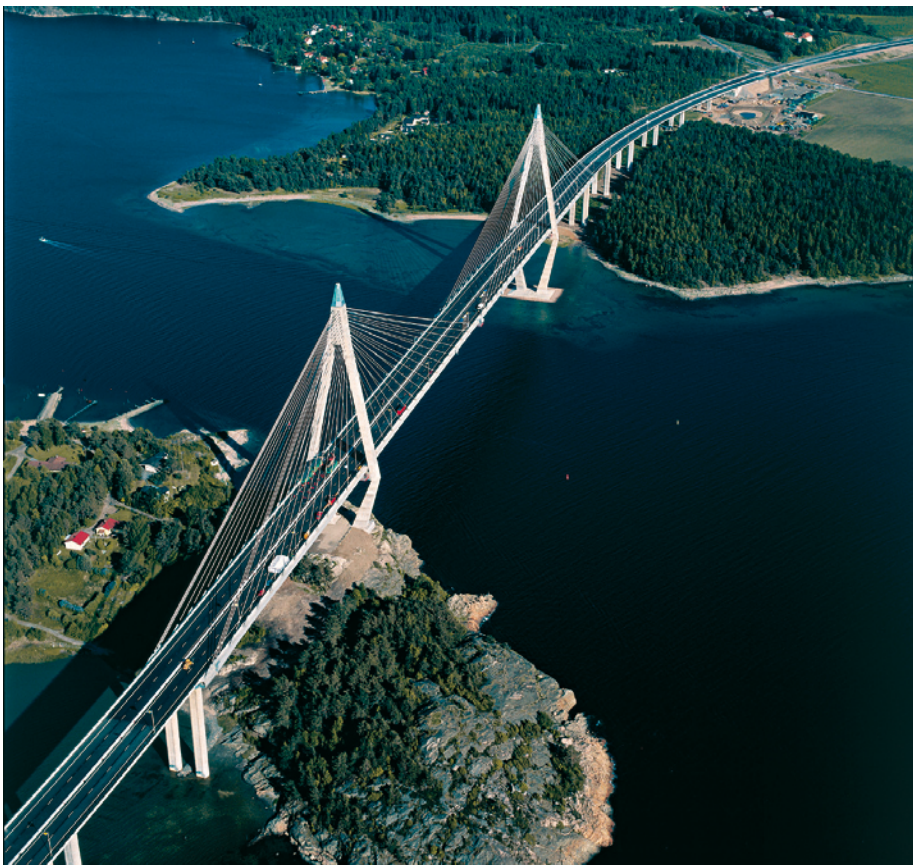
Kuva 7.21 Uddevallan silta (Ruotsissa) on esimerkki vinoköysisillasta. Uddevallan sillan kokonaispituus on 1 712 metriä, ja suurin jänneväli on 414 metriä.
