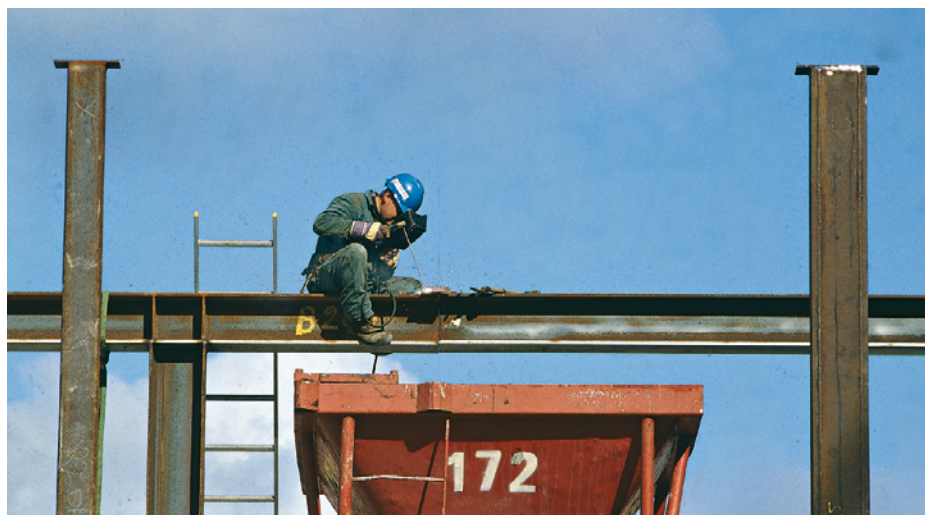
Kuva 9.12 Liitoksen hitsaaminen.
