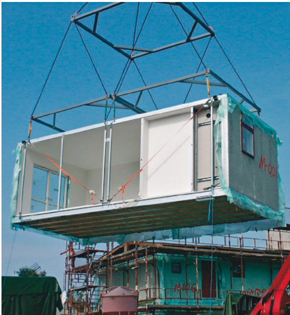
Kuva 15.3 Esimerkki kevytrakentamisesta, jossa käytetään terästä. Kuvassa massatuotanto-elementtiä nostetaan paikoilleen.
