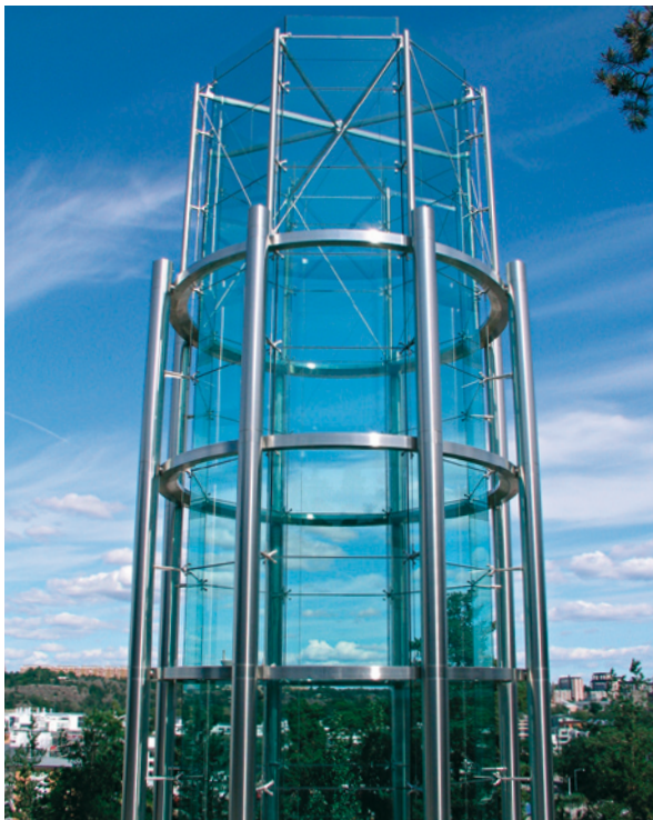
Kuva 2.10 Södra länken -pakokaasutorni. Hyvä esimerkki rakennelmasta, jossa on käytetty ruostumatonta terästä kantavana rakenteena.
