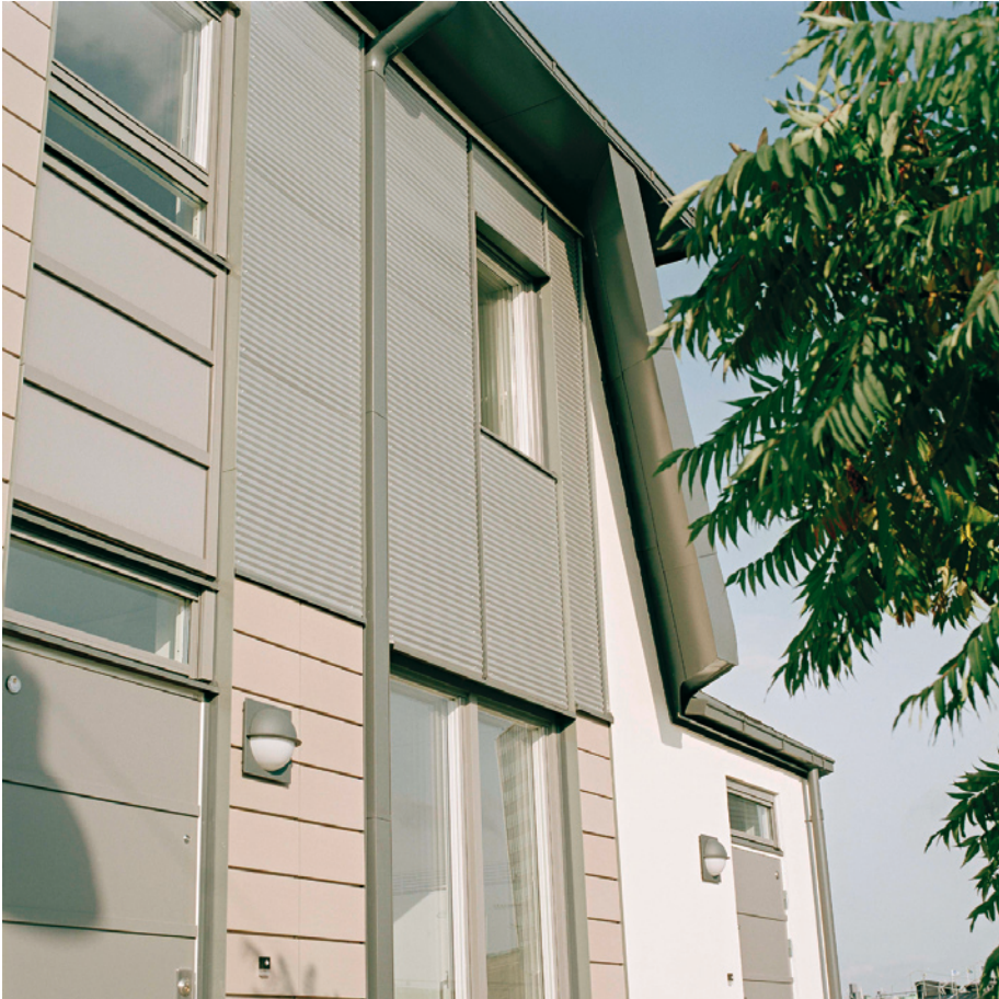
Kuva 13.6 Tehtaalla maalatusa ohutlevystä rakennettu julkisivu.
