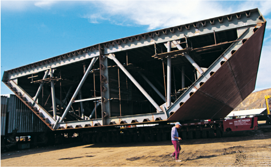
Kuva 7.14 Sillankansiele- mentti riippusiltaan, jossa on ortotrooppinen kansirakenne.
