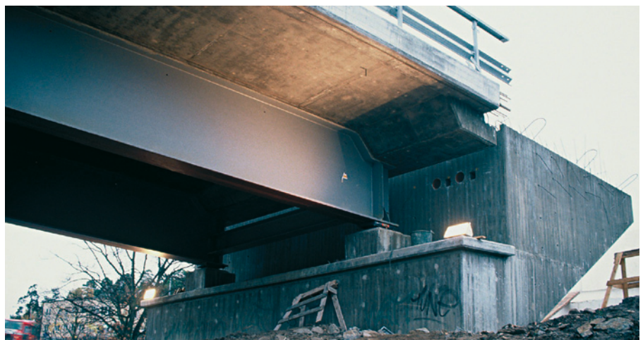
Kuva 7.9 Maatuki ja siipimuuri.
