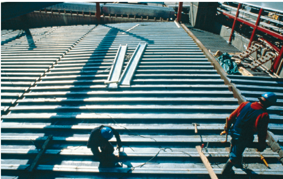
Kuva 3.17 Rullamuovattuja valukasetteja mediumlevystä. Kasetteja käytetään mm. välipohjarakenteissa.
