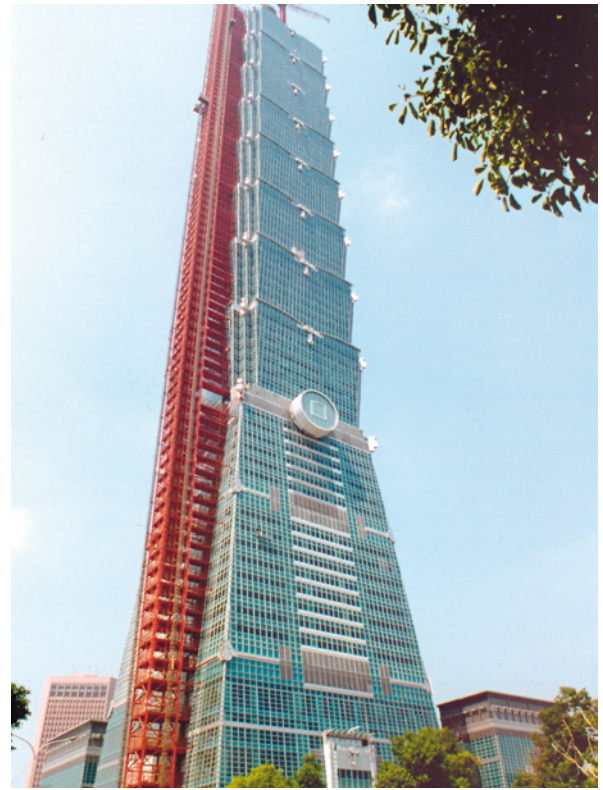
Kuva 1.5 Tällä hetkellä Taipei 101 on maailman korkein rakennus. Se on 509 metriä korkea (45 metriä korkea huippu mukaan luettuna). Tornia rakennettaessa käytettiin ruotsalaisen Alimak-yhtiön kuljetushissejä. Myös tämä pilvenpiirtäjä on mielenkiintoinen teräsrakennus.
