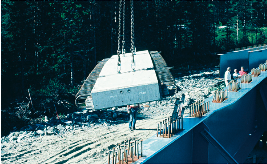
Kuva 7.12 Liittopalkkisilta, jossa käytetään esivalmistettuja betonielementtejä.
