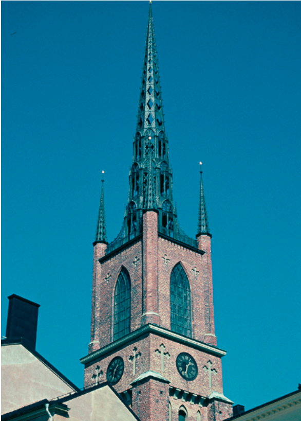
Kuva 1.2 Tukholmassa sijaitsevan Riddarholmenin kirkon tornin huippu on Ruotsin ensimmäinen suuri valurautarakenne vuodelta 1846. Noin 10 tonnia painava huippu nostettiin paikoltaan helikopterilla, kun sitä korjattiin vuosina 1967–1970.
