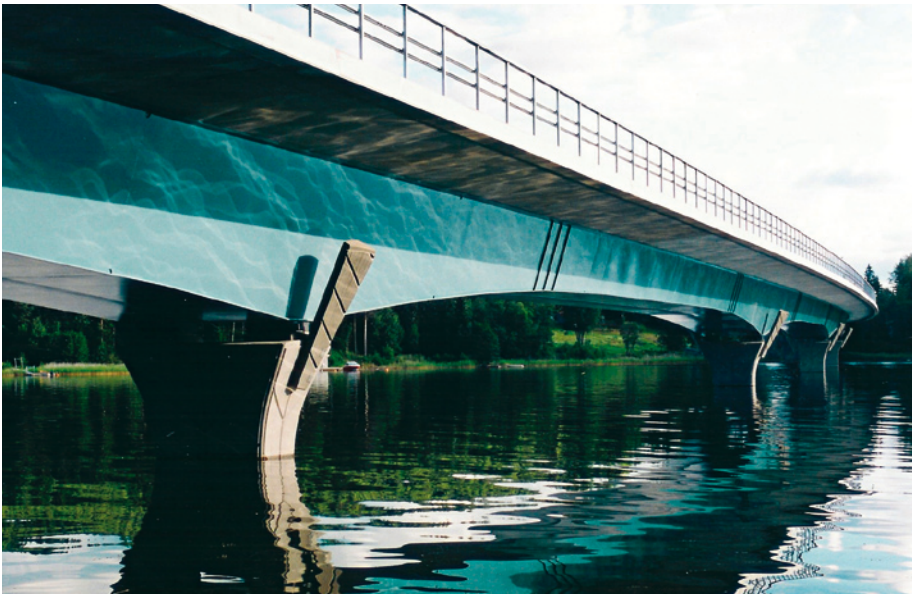
Kuva 7.6 Majorsviken-lahden yli kulkeva silta (Ruotsissa), jossa liittokotelo. Alareuna on paraabelin muotoinen.
