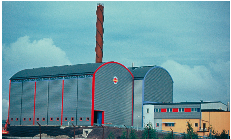
Kuva 1.10 Kaupunkien lämpövoimalat ovat tavanomaisia teräsrakennuksia. Tämä voimala Trollhättanin kaupungissa Ruotsissa on hyvä esimerkki hyvästä teräsarkkitehtuurista.
