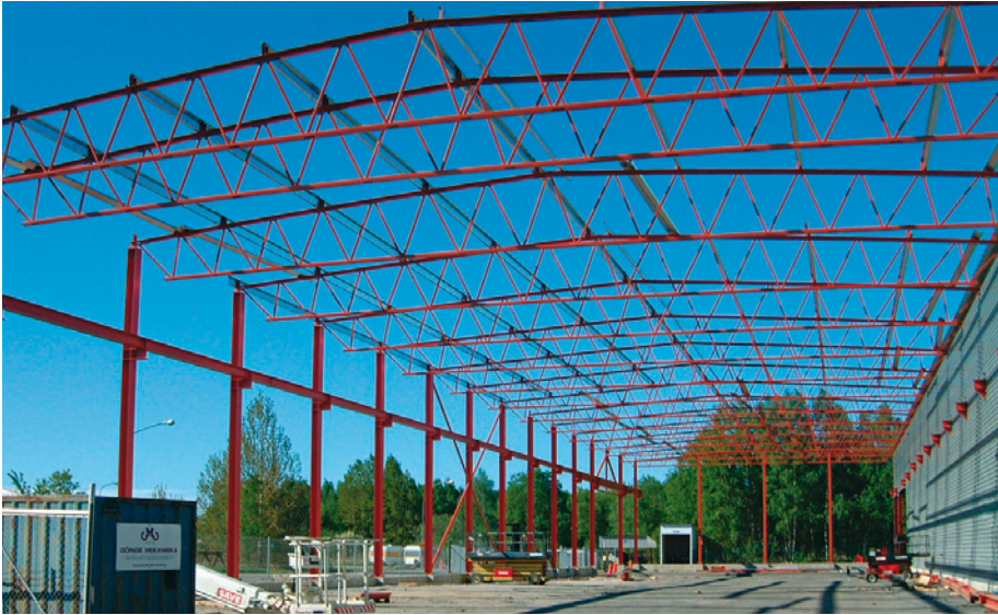
Kuva 3.12 Ristikkopalkki hallirakennuksen katto-rakenteessa.
