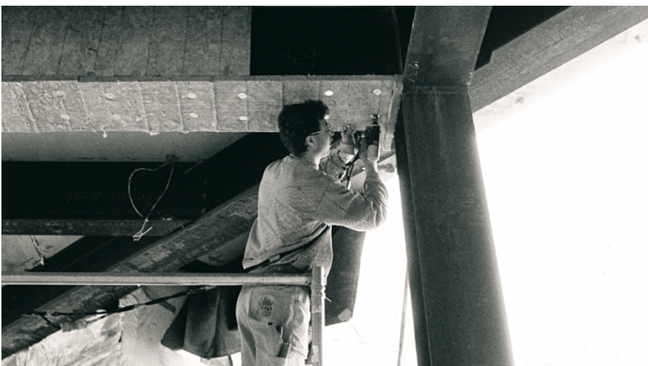
Kuva 10.13 Kivivillalevyjen kiinnittäminen.
