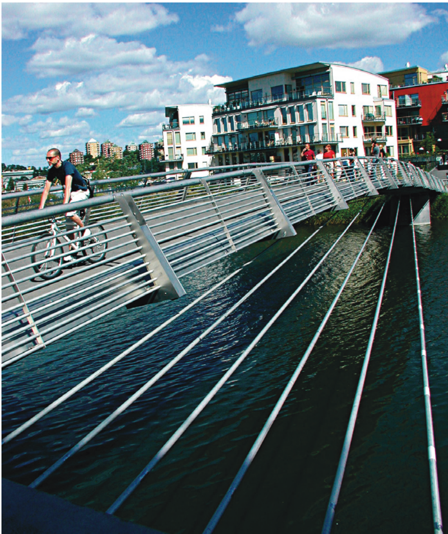
Kuva 15.8 Ruostumattomasta teräksestä valmistettu Apatébron-silta Tukholmassa.
