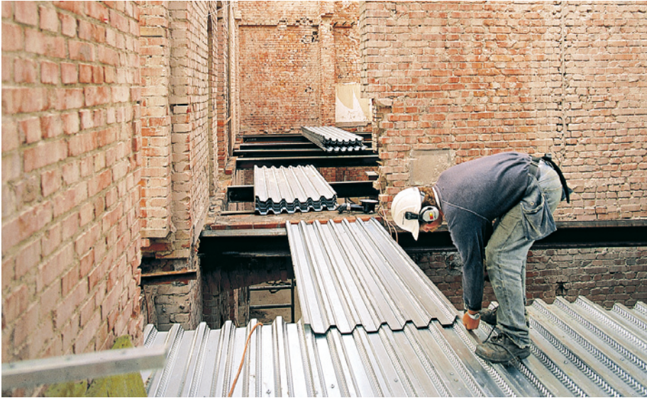
Kuva 14.5 Liittovälipohja. Levyn asennus.
