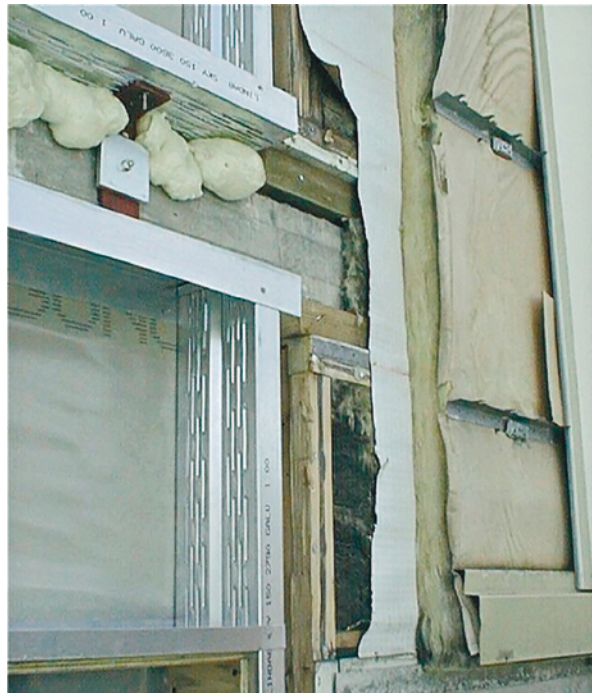
Kuva 15.7 Kosteuden vaurioittamia puutukia vaihdetaan ohutlevytukiin.
