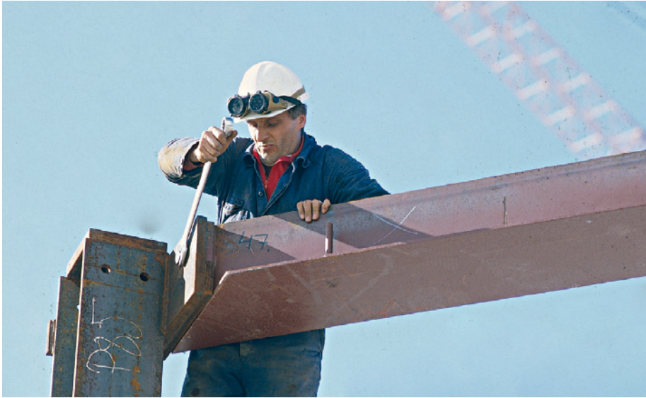
Kuva 9.11 Ruuvi-liitoksen asentaminen.
