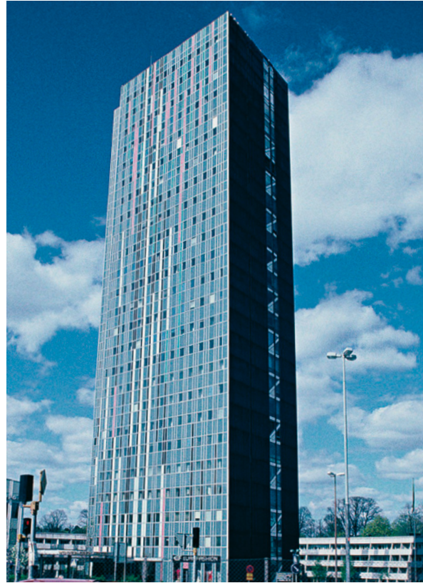
Kuva 1.8 Vuonna 1960 valmistunut Wenner-Gren Center edustaa teräsrakentamisen uutta kautta toisen maailmansodan aikaisen teräspulan jälkeen. Rakennus on 74 metriä korkea, ja se on rakennettu amerikkalaisella tekniikalla.
