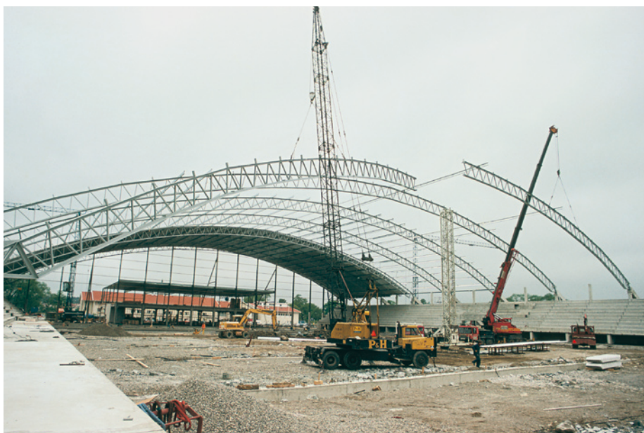
Kuva 5.5 Jalkapallohallissa on usein ristikkorakenteisista kaarista muodostuva runko ja suuri jänneväli.
