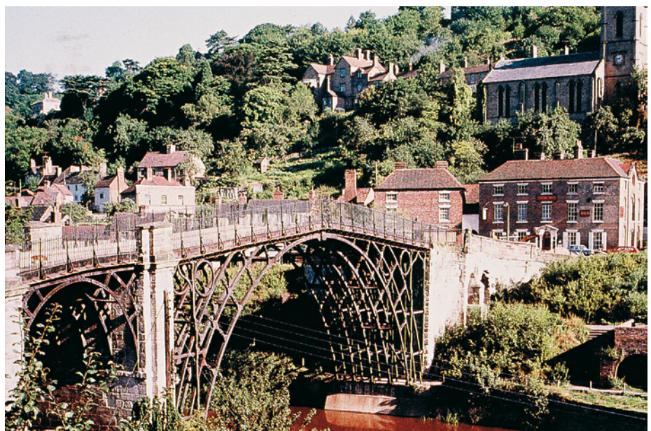
Kuva 1.1 Severn-joen yli kulkeva Ironbridge-silta Englannissa valmistui vuonna 1779. Se on ensimmäinen suuri valurautarakennelma. Holvikaaaret ovat perua kivsiltatekniikasta, mutta ne ovat tarkoituksenmukaiset myös valurautaa käytettäessä, koska valurauta ei sovellu käyttöön vetojännityksen ollessa suuri.
