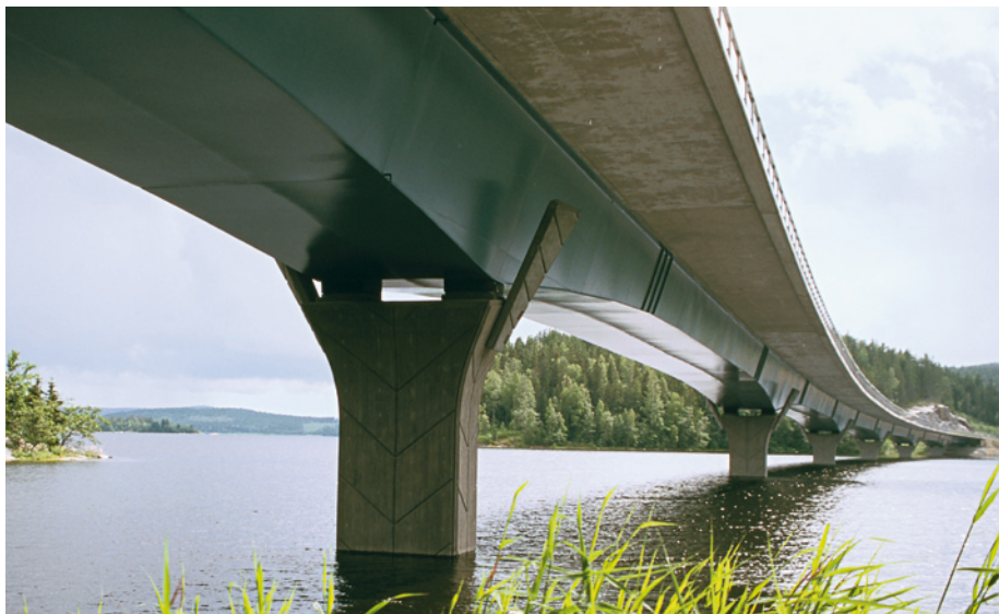
Kuva 11.6 Liittopalkkisillan teräksinen kotelopalkki on hyvä esimerkki tasaisesta ja sileästä pinnasta.
