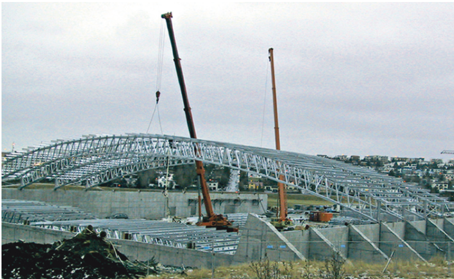
Kuva 9.15 Suuren kattorakenteen nostaminen.
