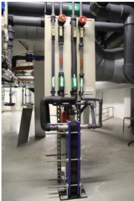
KUVA 9. PROHEAT-lämmöntalteenottojärjestelmä. Viihdeuimala Rantakeidas
