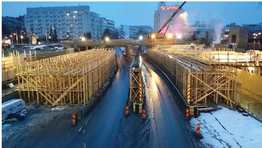
Kuva 12. Vesijärvenkadulla ajoneuvoliikenne ja kevyt liikenne ohjattu sillankannen telineiden kulkuaukkoihin.
