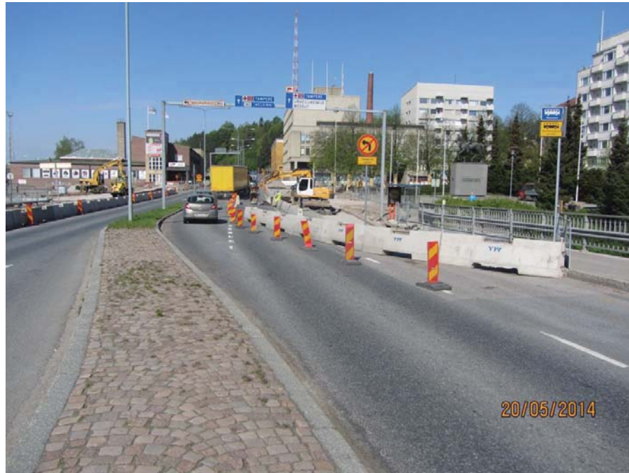
Kuva 8. Mannerheiminkadulla betonielementtijono työalueen suojana.
