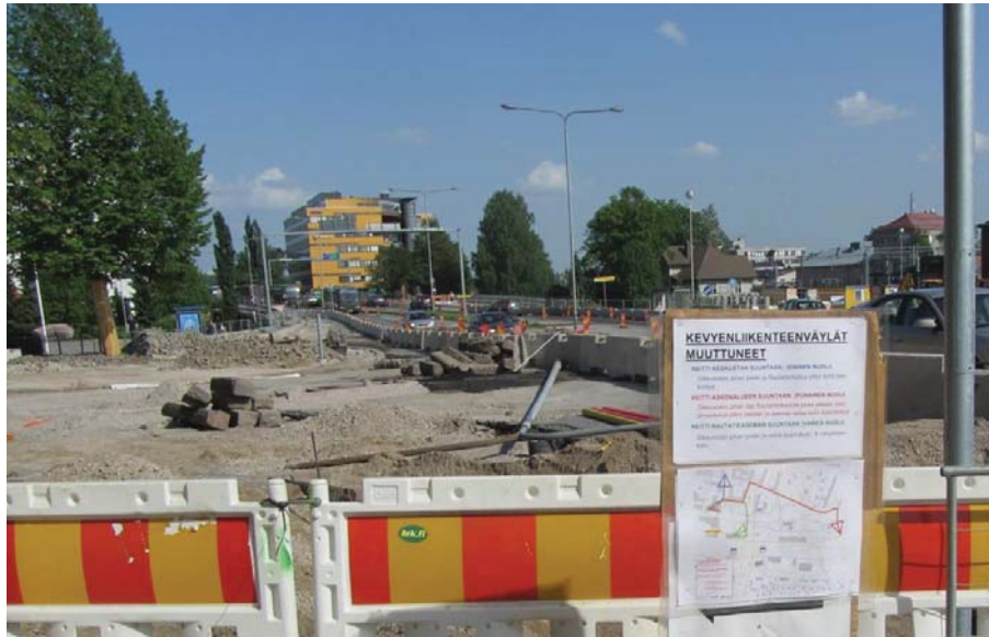
Kuva 14. Kevyen liikenteen opaste, jossa kartan lisäksi on sanallisesti kerrottuna reitti tärkeimpiin suuntiin.
