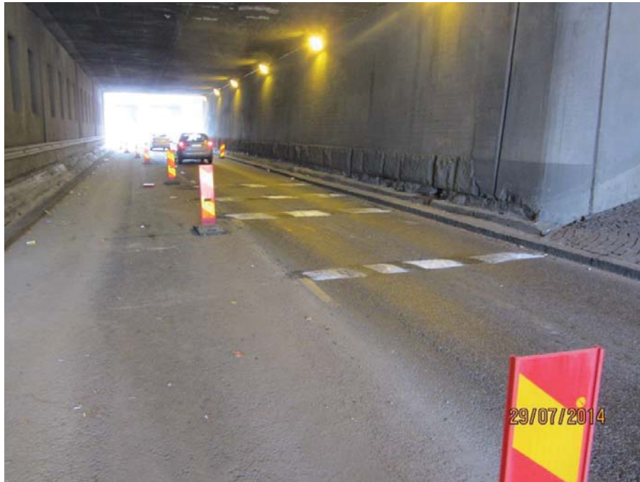
Kuva 10. Vesijärvenkadulle Asemapäällikön sillan alle tehtiin hidastetöyssyt nopeuksien rajoittamiseksi.
