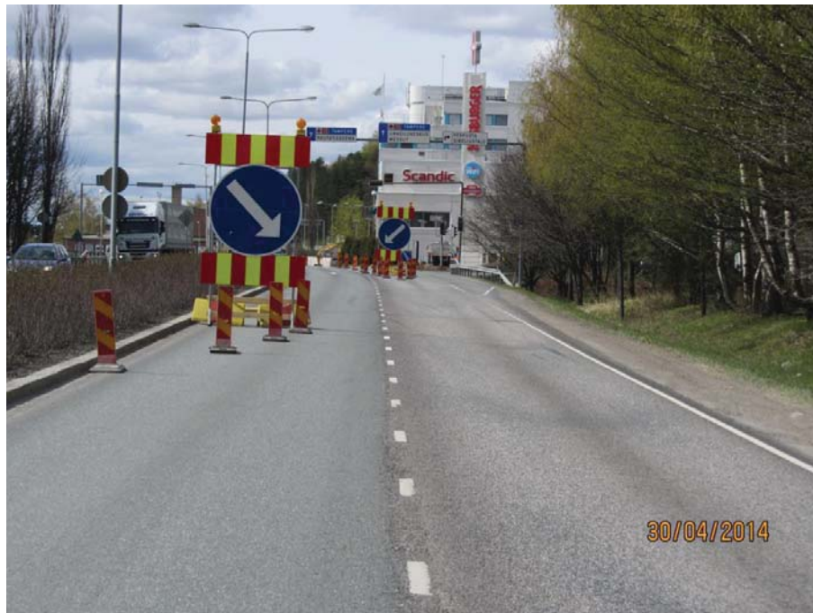
Kuva 7. Mannerheiminkadulle toteutettu šikaani liikenteen ohjaamiseksi yhdelle ajokaistalle S3-luokassa.
