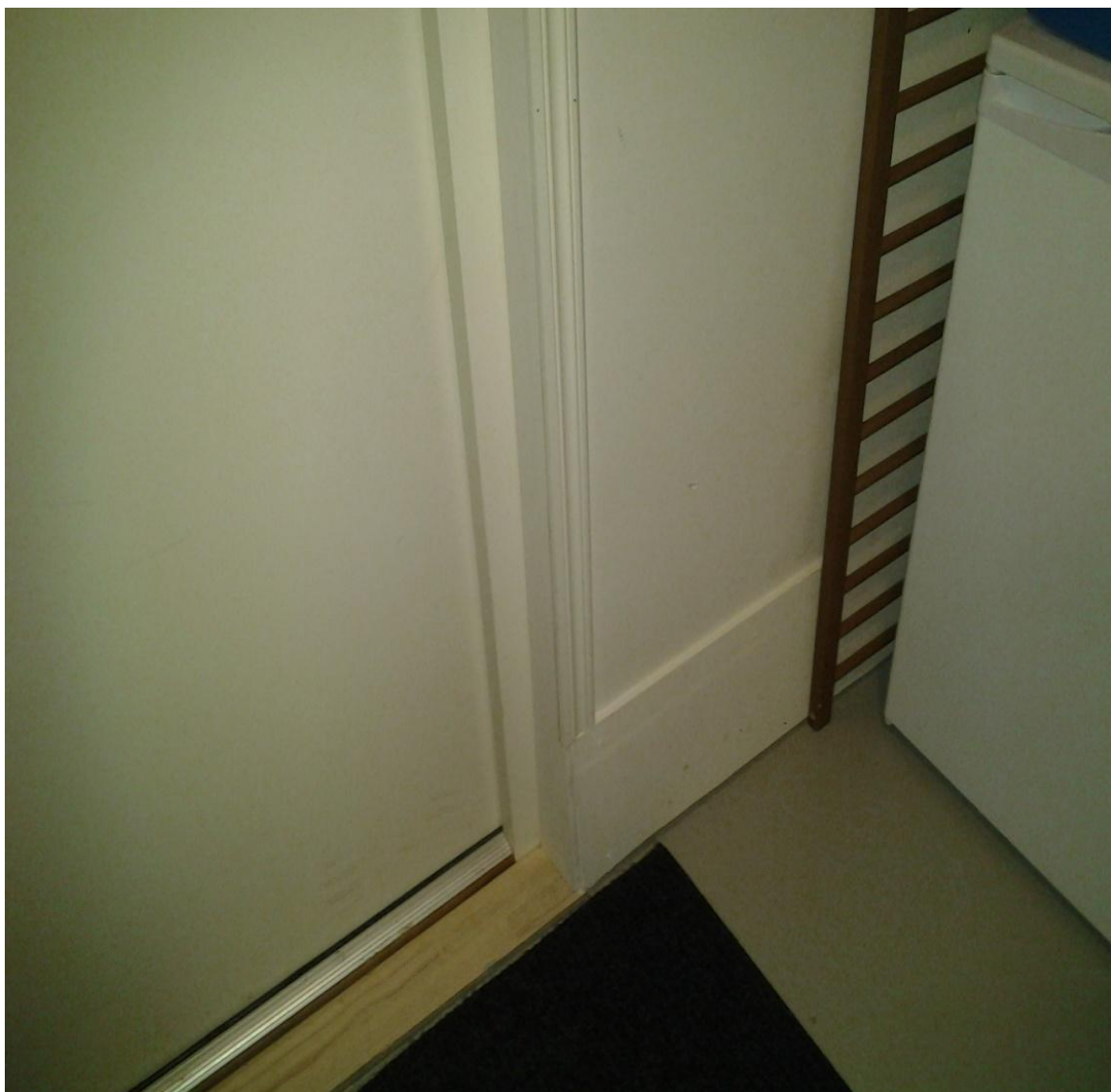
KUVA 6. Purettava alareunan levytys (Hartikainen 2014-10-15)
