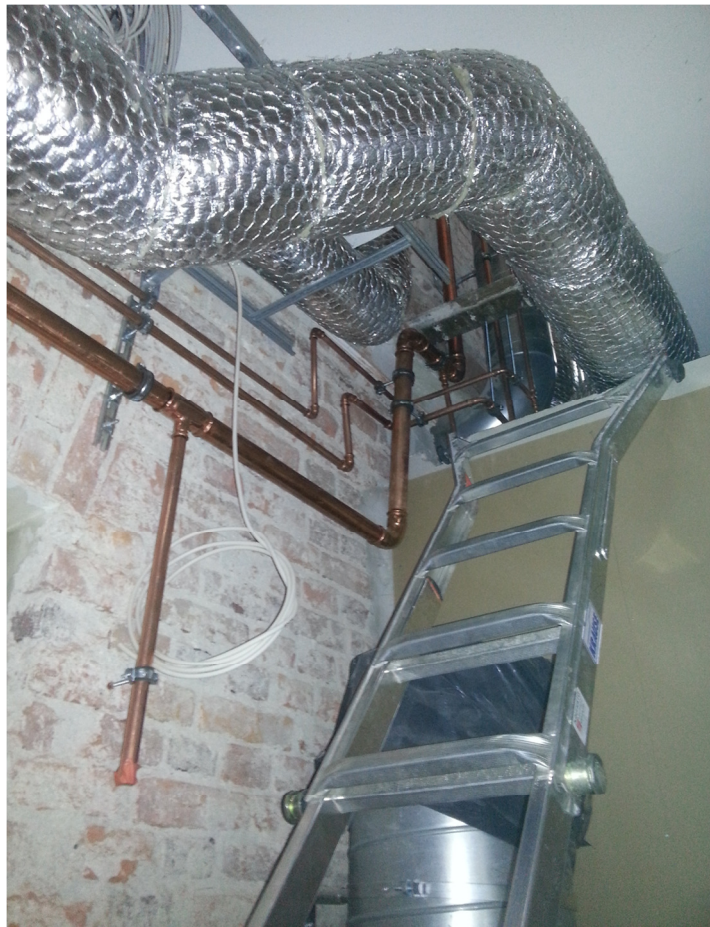
KUVA 31. Itäpään kuilu 2. kerroksesta
