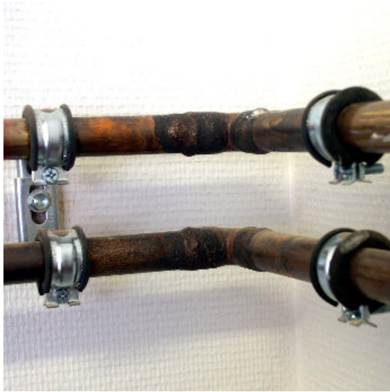
KUVA 14: Kovajuottamalla tehtyjä liitoksia kupariputkissa ( www03.edu.fi )
