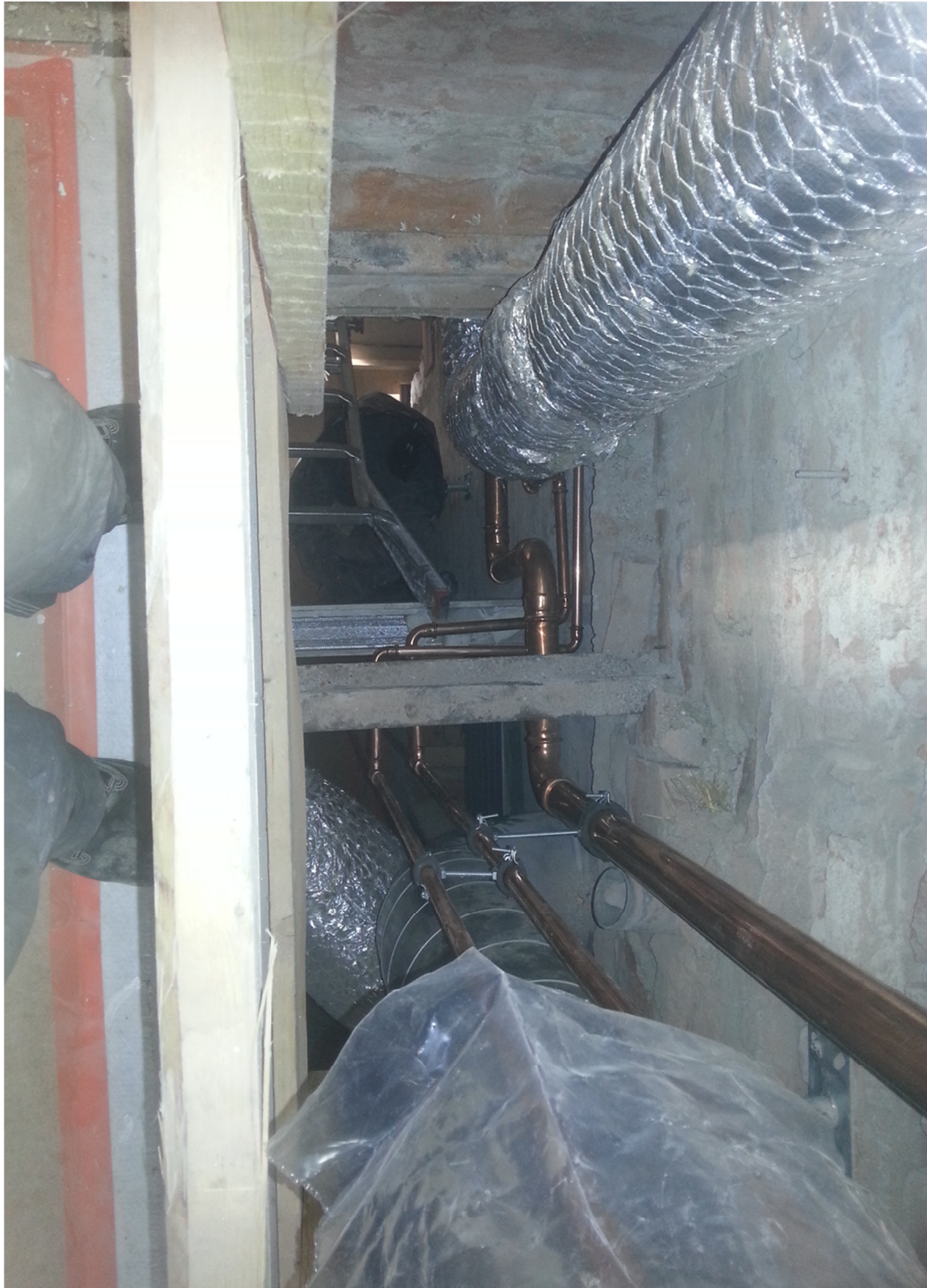
KUVA 32. Itäpään kuilu 3. kerroksesta
