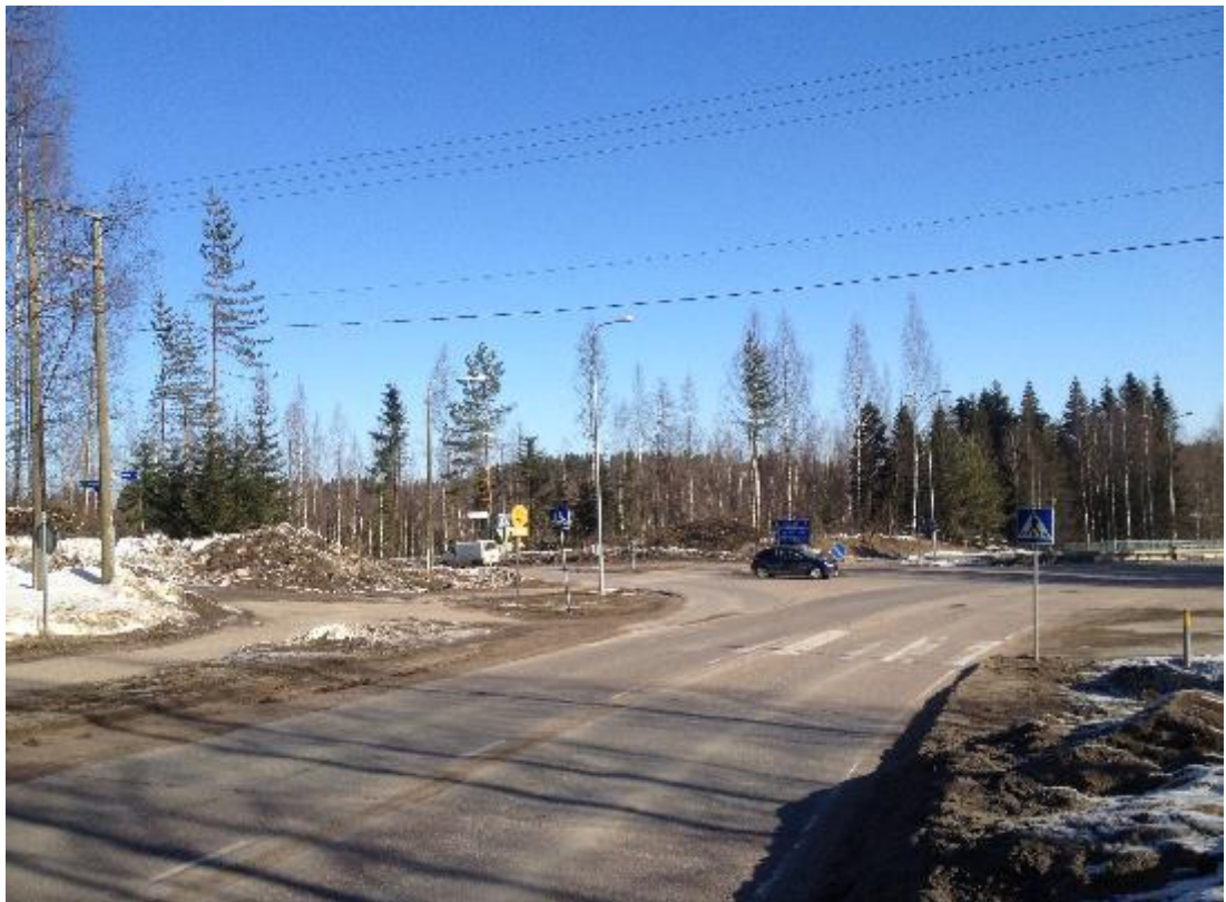
KUVA 24. Ronsuntaipaleentiellä Keltinmäen pilottikohde hakkuun jälkeen. Valoisuus lisääntyi ja etenkin kesällä näkee paremmin, tuleeko vasemmalta Keuruuntien rampilta autoja Ronsuntaipaleentille.
