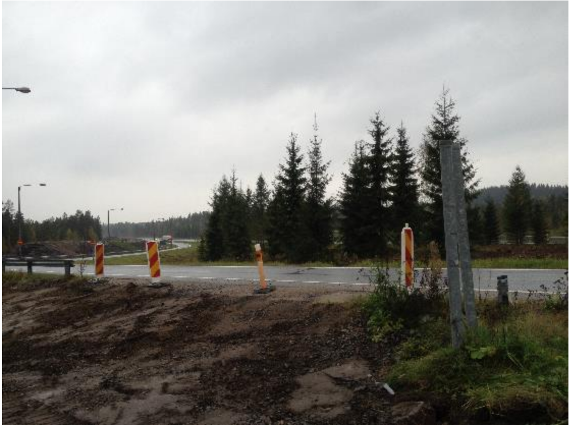
KUVA 55. Keljonkankaan ABC:n viereinen sisääntuloramppi Keljonkankaalla harvennuksen jälkeen
