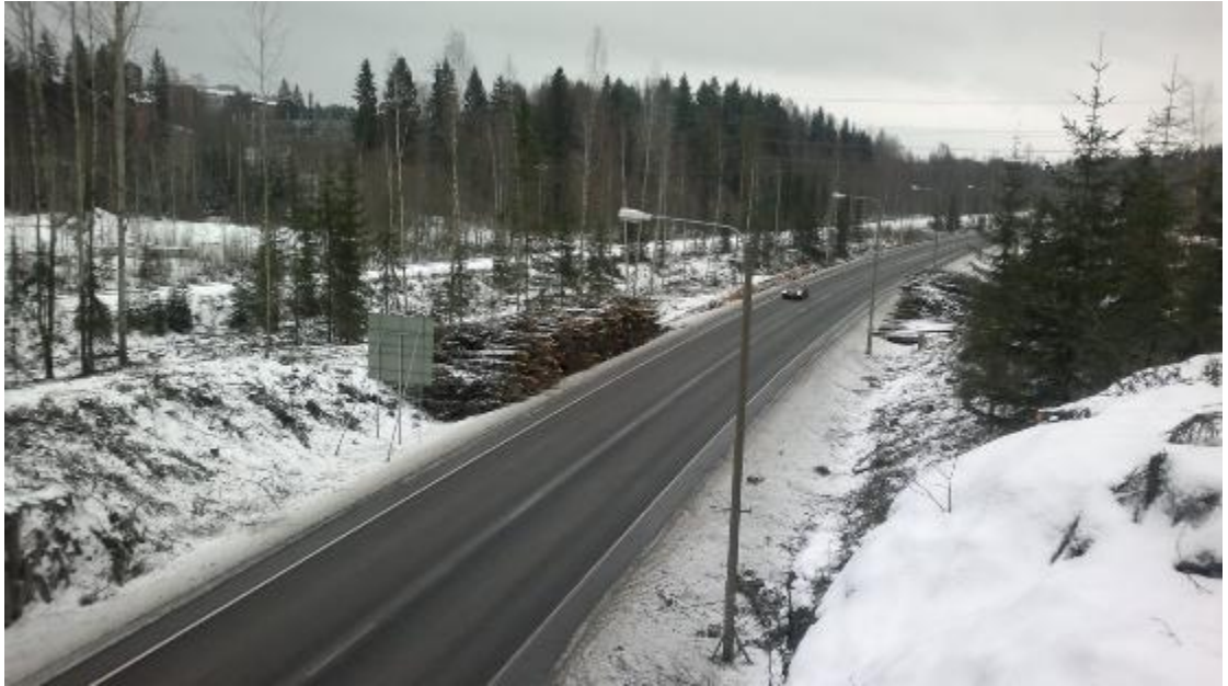
KUVA 92. Ronsuntaipaleentien silta ja maisema hakkuiden jälkeen. Huomaa paljastunut junarata vasemmalla
