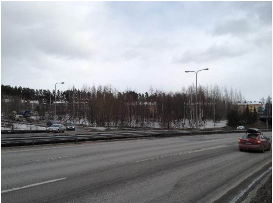
KUVA 43. Holstin pilotikohteen näkymä nelostieltä katsottuna ennen hakkuuta
