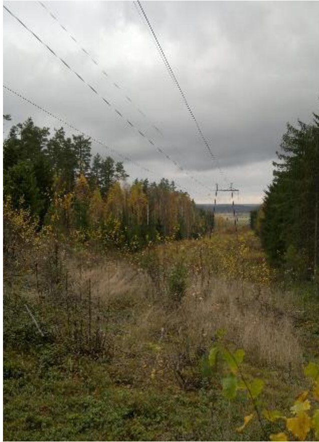
KUVA 3. Suurjännitelinjan alla oleva avoin alue eli johtoaukea. Kyseiselle alueelle tulee myöhemmin aluskasvien raivaus, jotta puiden taimet eivät pääse kosketukseen tai ylitä turvaetäisyyksiä sähkölinjojen kanssa.
