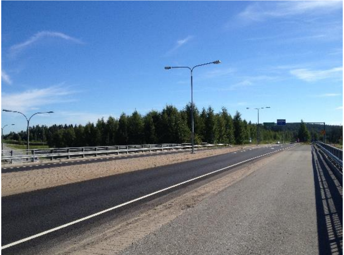
KUVA 58. Keljonkankaan lähtöramppi Jyväskylään päin ennen harvennusta. Sisääntuloramppi (kuva 51–54) on kuvassa oikealla
