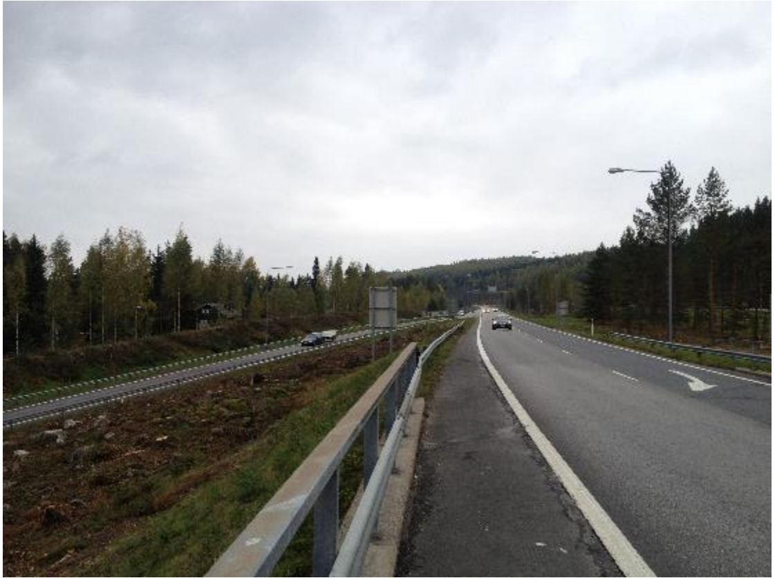
KUVA 86. Maisema samaiselta sillalta vastaantulevaa liikennettä päin hakkuiden jälkeen. Alas vievän liuskan vasemmalla puolella kulkee kevyenliikenteenväylä meluvallin takana
