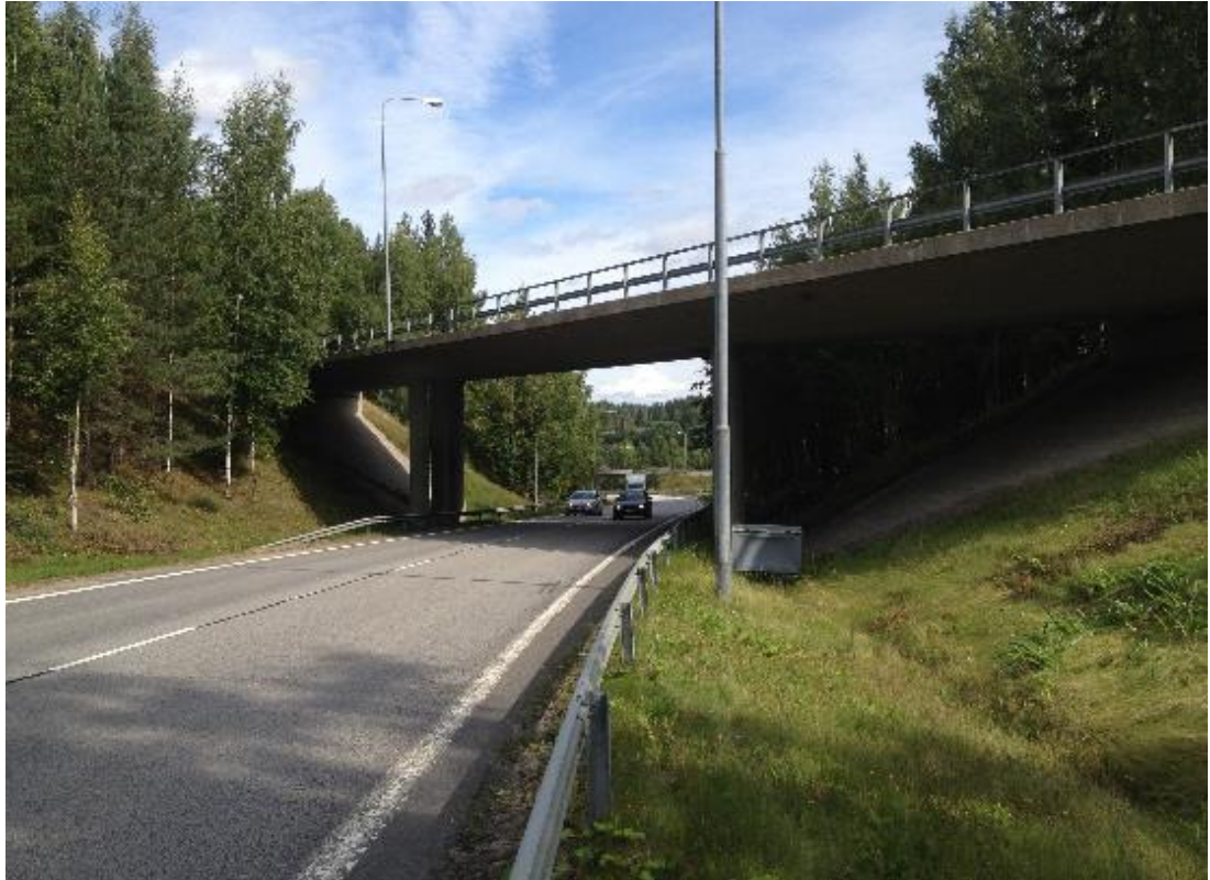
KUVA 77. Jyväskylästä tuova tie ja yllä Tampereelta tuovan tien silta. Maisema ennen hakkuuta
