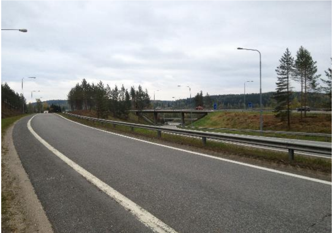
KUVA 61. Keljonkankaan moottoritien kiihdytyskaista Tampereen suuntaan hakkuiden jälkeen
