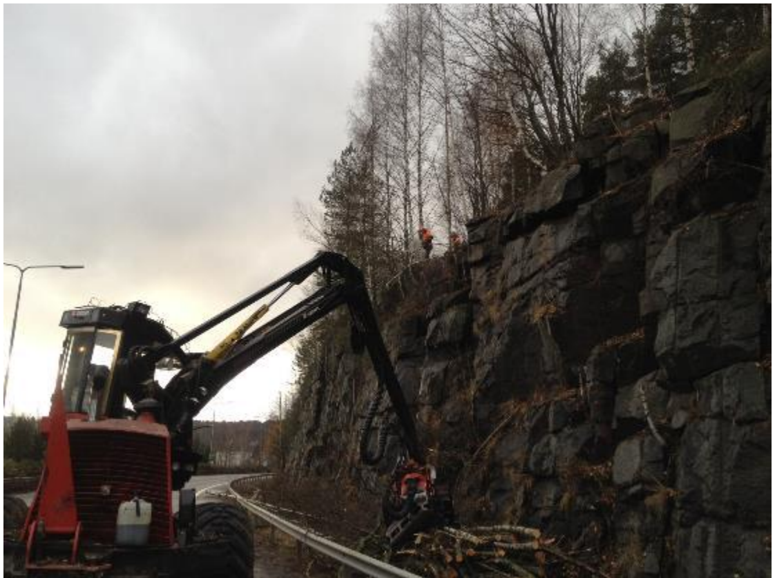
KUVA 49. Vaajakosken moottoritiellä vaativat hakkuut toteutettiin metsurin ja hakkuukoneen yhteisvoimin
