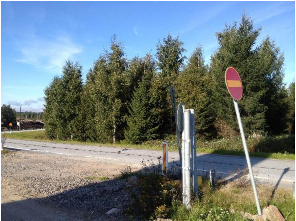
KUVA 54. Keljonkankaan Abc:n viereinen sisääntuloramppi ennen harvennusta
