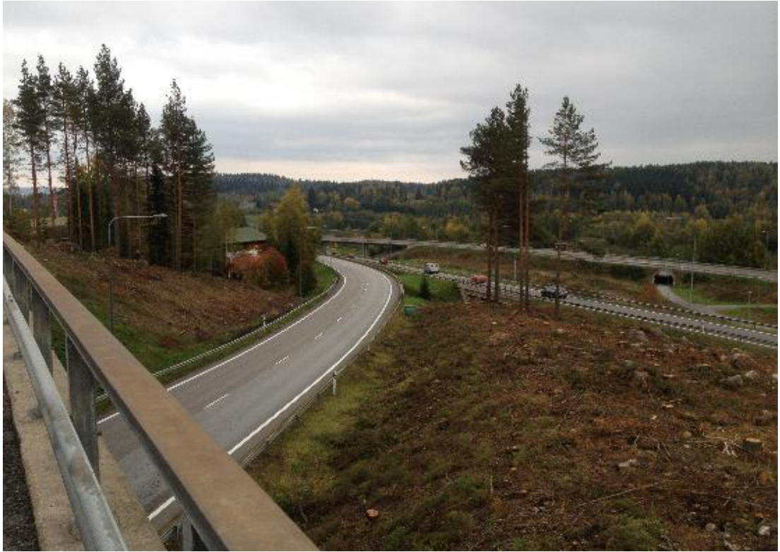
KUVA 84. Maisema hakkuiden jälkeen sillalta moottoritien loppupäässä. Valta- vasti pusukoitunut piennar on hakattu kokonaan
