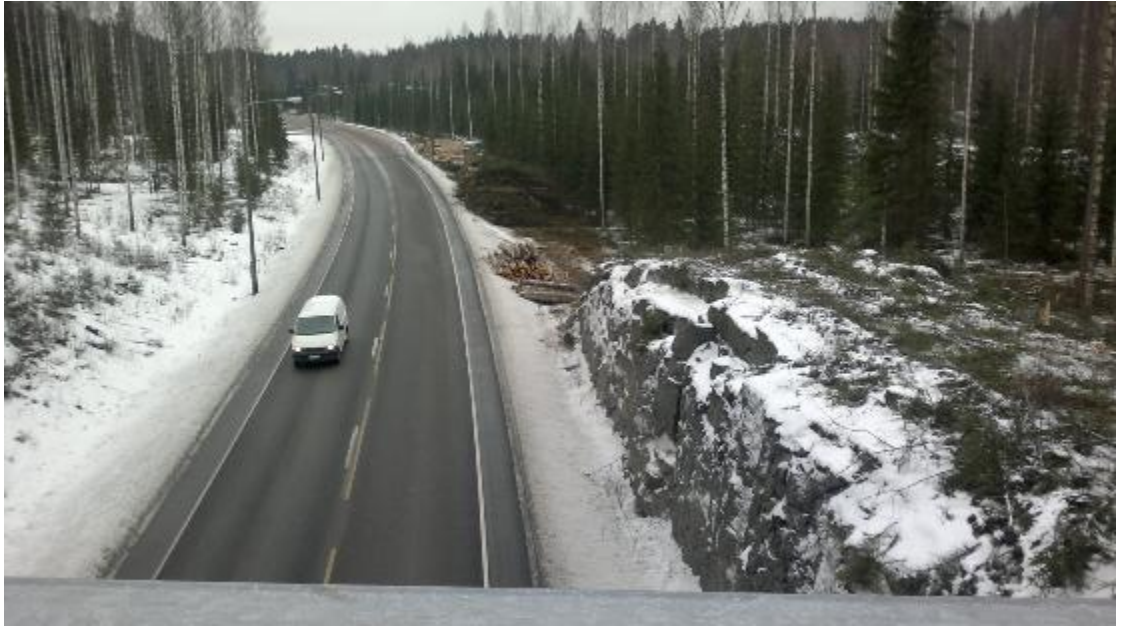
KUVA 94. Ronsuntaipaleentien silta Keuruun suuntaan hakkuiden jälkeen
