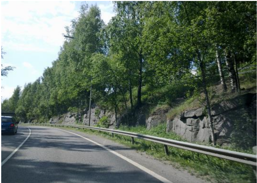
KUVA 51. Tien varrelta poistetaan pääosin koivuja ja leppiä. Hakkuu on tehtävä tieltä käsin mies- ja konetyönä. Kuva Vaajakosken sisääntuloväylän alkupäästä
