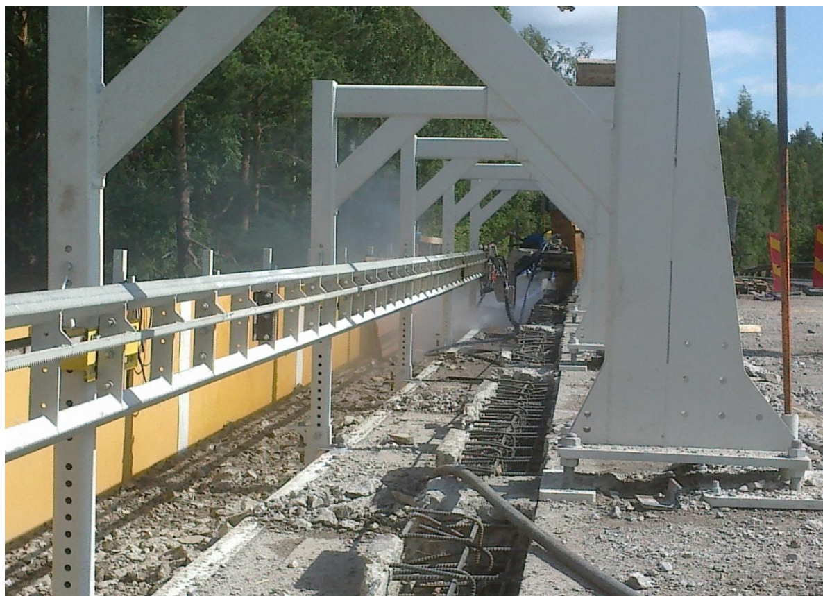
Kuva 2. Reunapalkin piikkaus vesipiikkausrobotilla n. 700 bar. paineella. Kuva Niko Juutilainen
