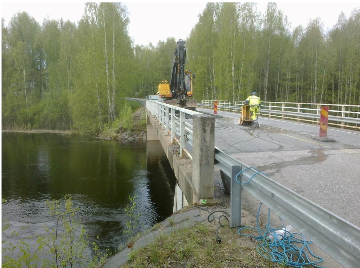
Kuva 1. Pintarakenteiden purku. Kuva Niko Juutilainen
