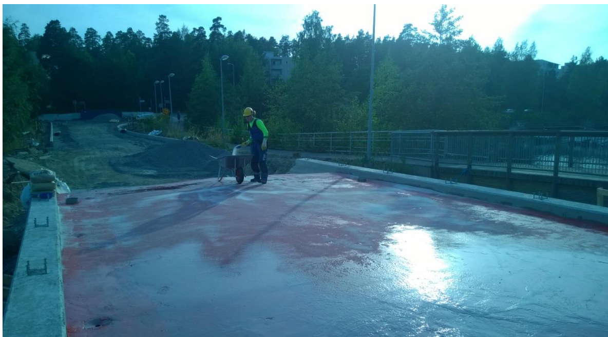
Kuva 7. Siroitehiekan levittäminen kannelle. Kuva Niko Juutilainen
