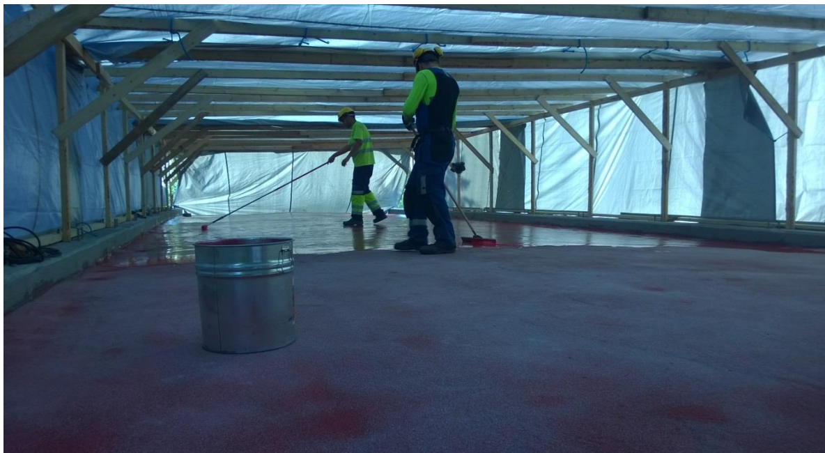
Kuva 8. Toisen epoksikerroksen levittäminen ja telaaminen sääsuojassa. Kuva Niko Juutilainen
