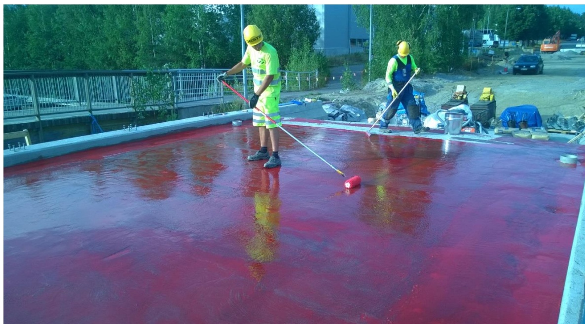
Kuva 6. Ensimmäisen epoksikerroksen levittäminen ja telaaminen Tuokkolan sillalle. Kuva Niko Juutilainen
