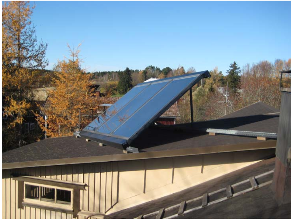
Kuva 10 Parvekkeen katto ja keräimet
