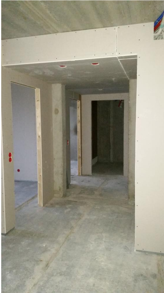
Kuva 8. Seinät ja alas laskettu katto levytettynä
