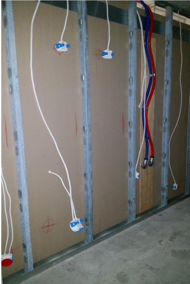
Kuva 7. Väliseinän levytyö ja talotekniikka
