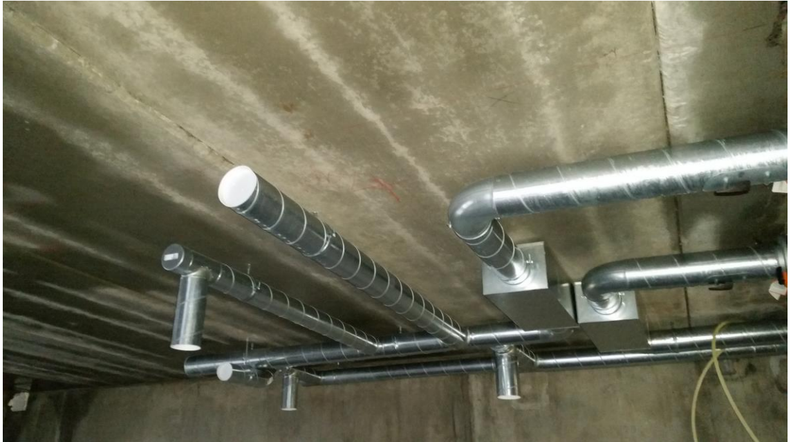
Kuva 6. Alakaton talotekniikan asennuksia.
