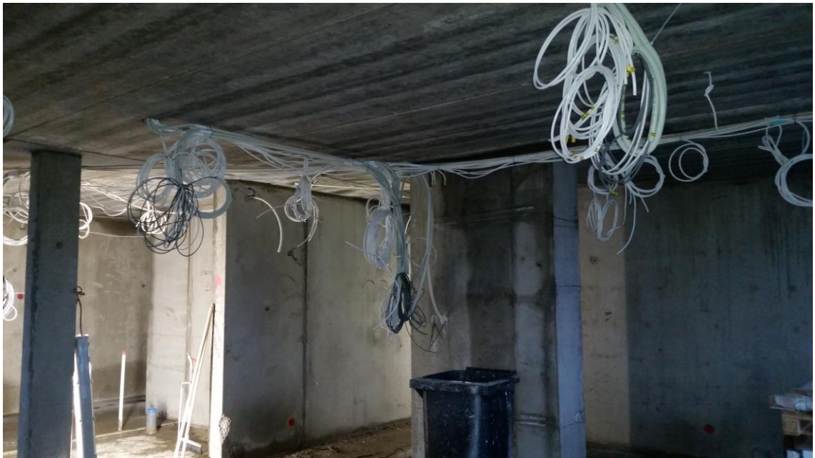
Kuva 5. Väliseinän ja alakaton sähkötöiden valmistelu
