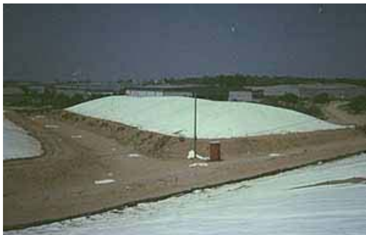
Kuva 6 Maahan tehty viljabunkkeri /17/
