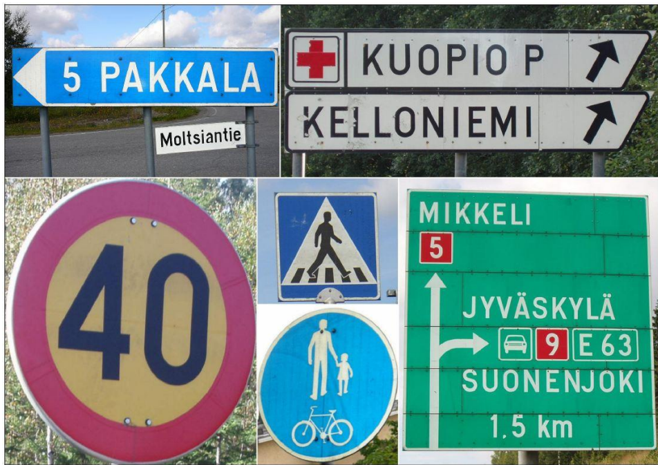
Kuva 17. Esimerkkikuva: Tyydyttävässä kunnossa olevista liikennemerkeistä (Tiehallinnon julkaisuja Liikennemerkkien kuntoluokitus, 2009)
