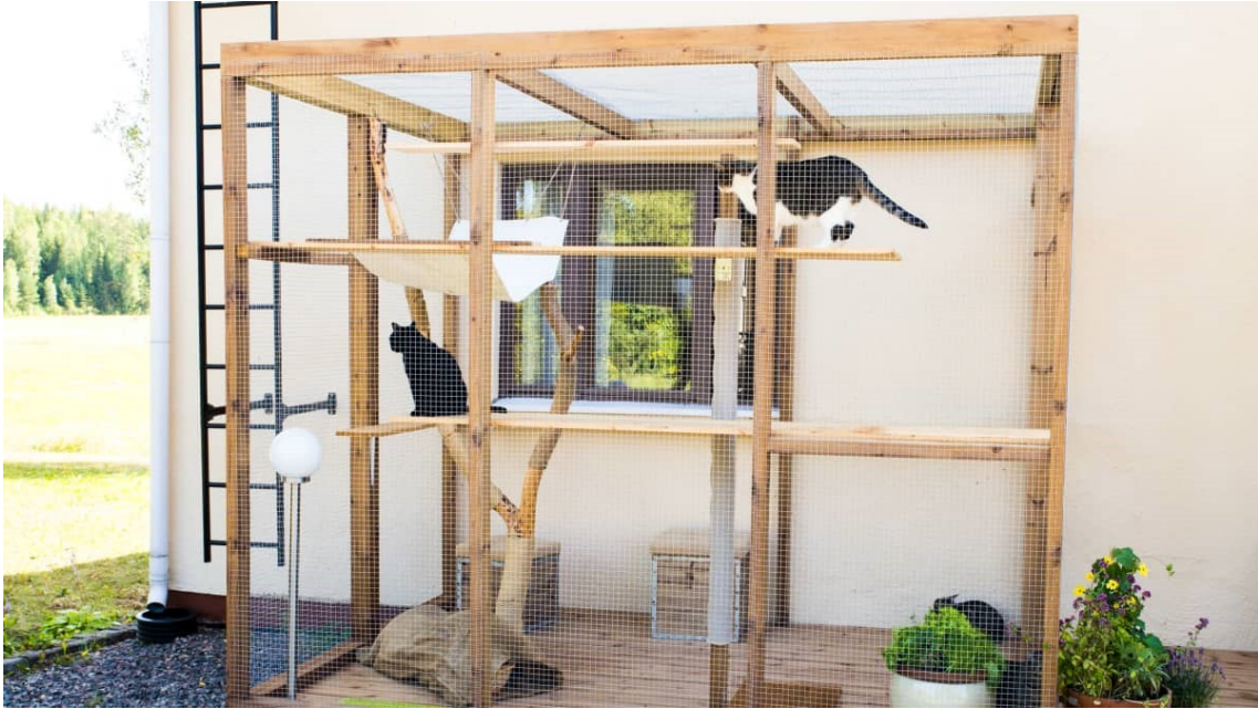
KUVA 7. Kissatarha ikkunan ympärille asennettuna (29)
