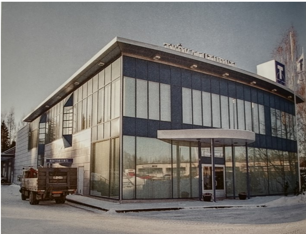
KUVA 16. HESY-keskus ennen remonttia (64)
