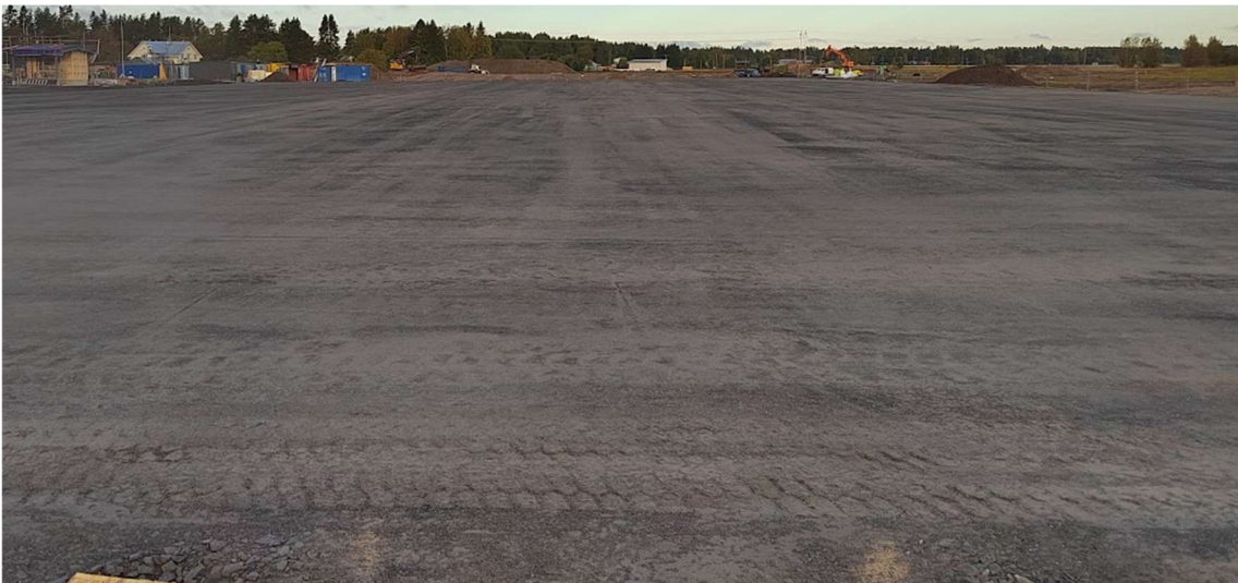
KUVA 9: Valmis kivituhkapinta.
