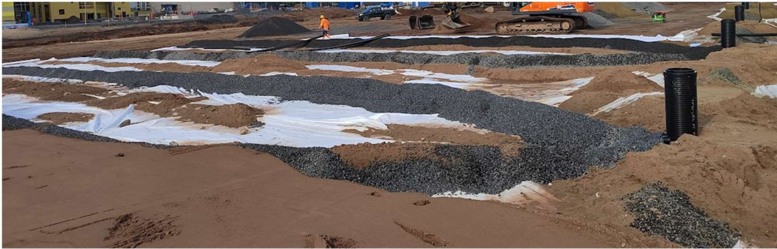
KUVA 7: Salaojituksen rakentamista
