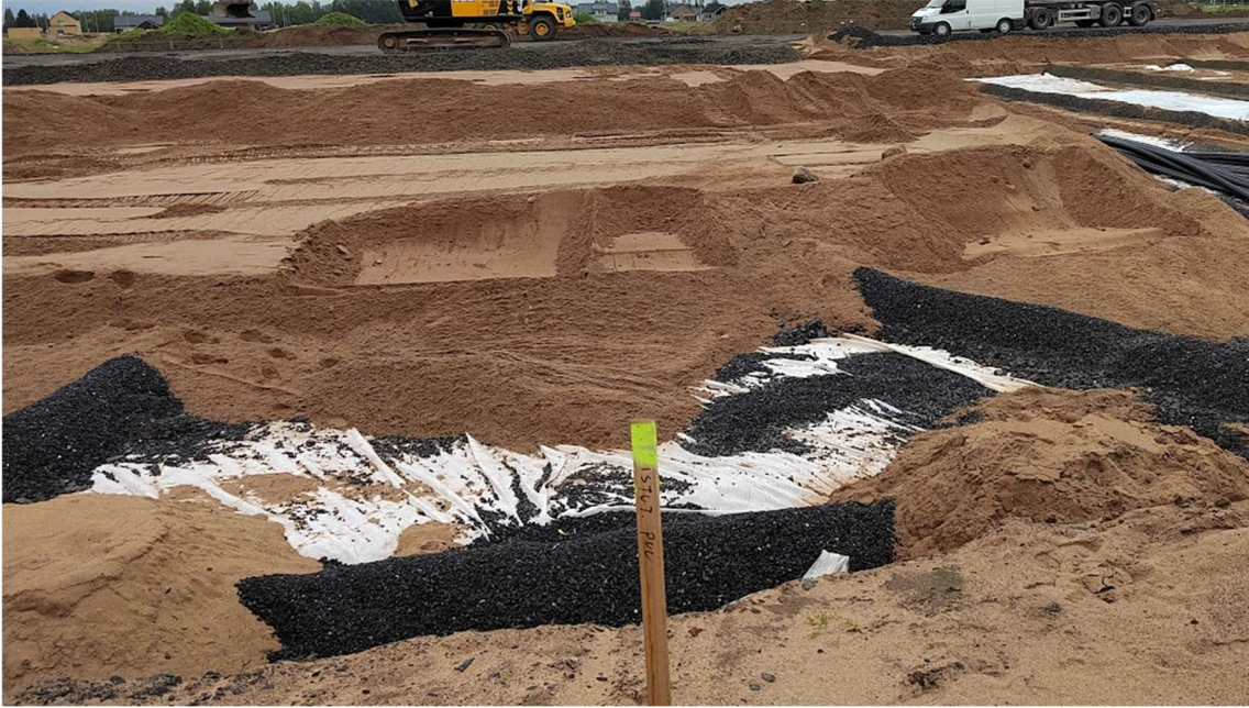
KUVA 8: Rakennekerrokset
