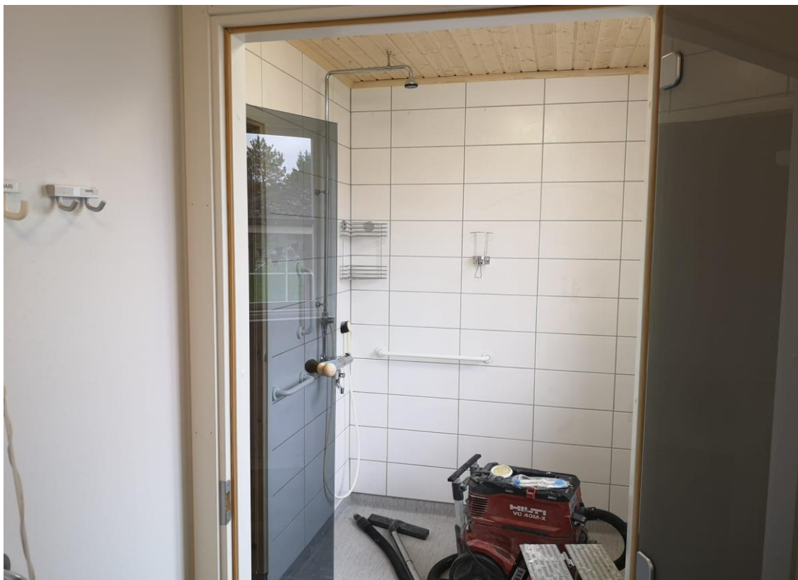
KUVA 22. Kylpyhuoneen korjaustyöt valmiit.
