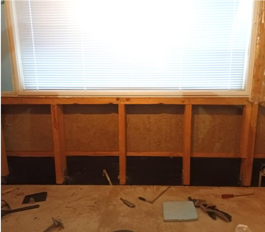
KUVA 15 Ulkoseinän levytys, höyrynsulkumuovi ja eristeet poistettu
