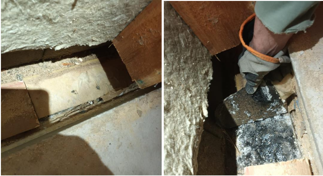
KUVA 16 Ulkoseinän runkotolppa katkaistu ja alajuoksu poistettu.
