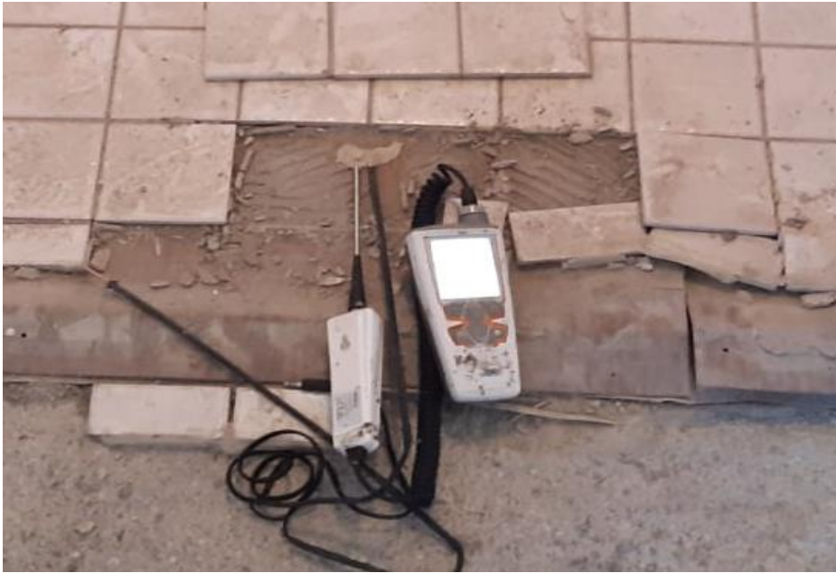
KUVA 12 Viiltomittaus kylpyhuoneen laatoituksen alapuolisen muovimaton alta.
