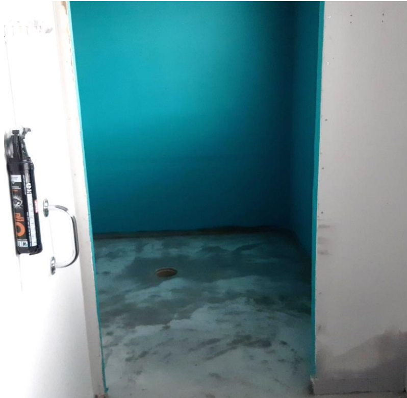
KUVA 21. Kylpyhuoneen seinät vesieristetty
