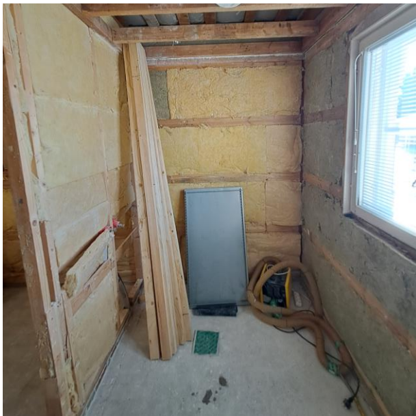
KUVA 19. Kylpyhuoneen pinnat purettu ja rakenteet kuivattu
