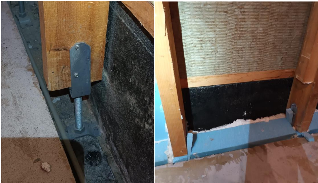
KUVA 17. Valesokkelikenkä kiinnitetty paikalleen ja rungon välit eristetty lattiapinnan alapuolelta
