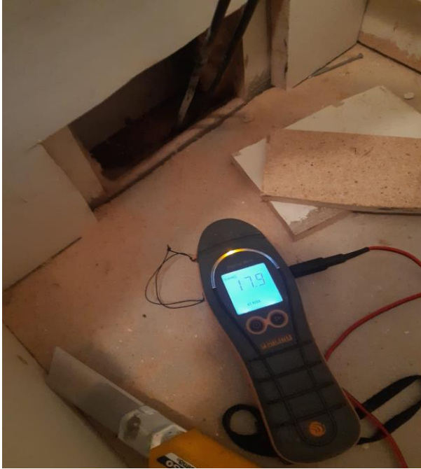
KUVA 8 Rivitaloasunnon ulkoseinän alaosan levytystä avattu.
