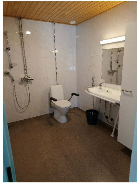
KUVA 2 ASUKAS HUONEEN ESTEETÖN WC 1
