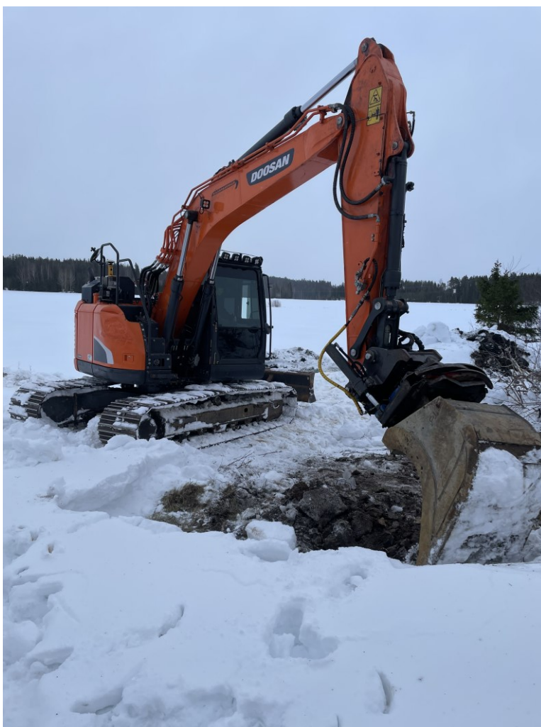
KUVA 6. Kaivinkoneella koekuoppien kaivuuta (Hyytiäinen, 2/2024)
