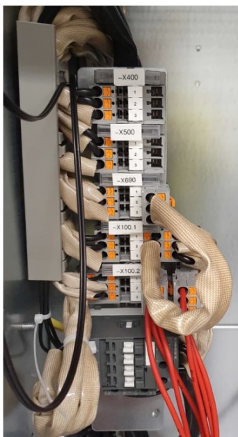
Kuva 11. AC-jännitteen valikointi: X400 (400 V), X500 (500 V) ja X690 (690 V).
