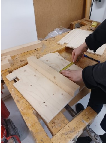
Kuva 56. a) Reikien paikkojen mitoitusta, b) reikien poraus vaneriin.
