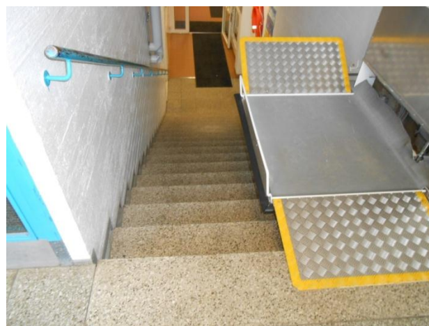
Kuva 7: Hissin ollessa käytössä se vie paljon tilaa portaissa
