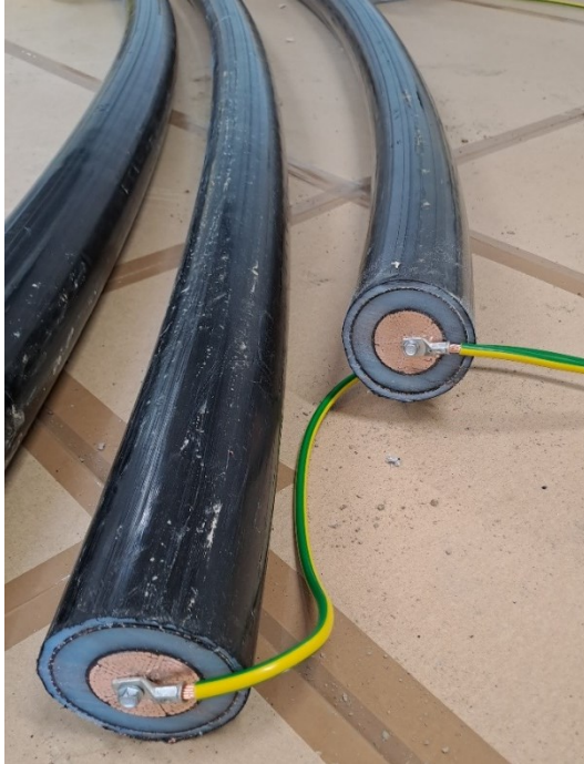
Kuva 13. Työnaikaiset kaapelimaadoitukset.
