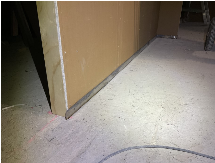
KUVA 8. Väliseinän alaosan saumaus lyijynauhalla
