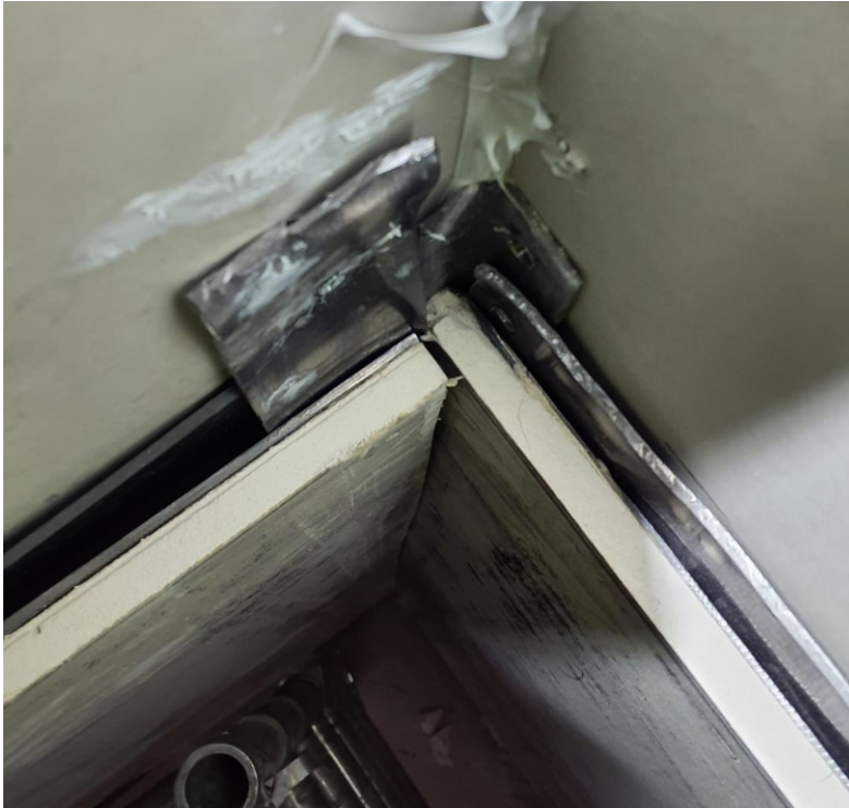
KUVA 10. Nurkan säteilysojauksen toteutus
