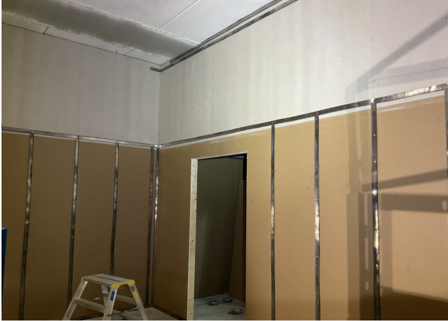
KUVA 9. Lyijylevyjen saumojen saumaaminen lyijynauhalla
