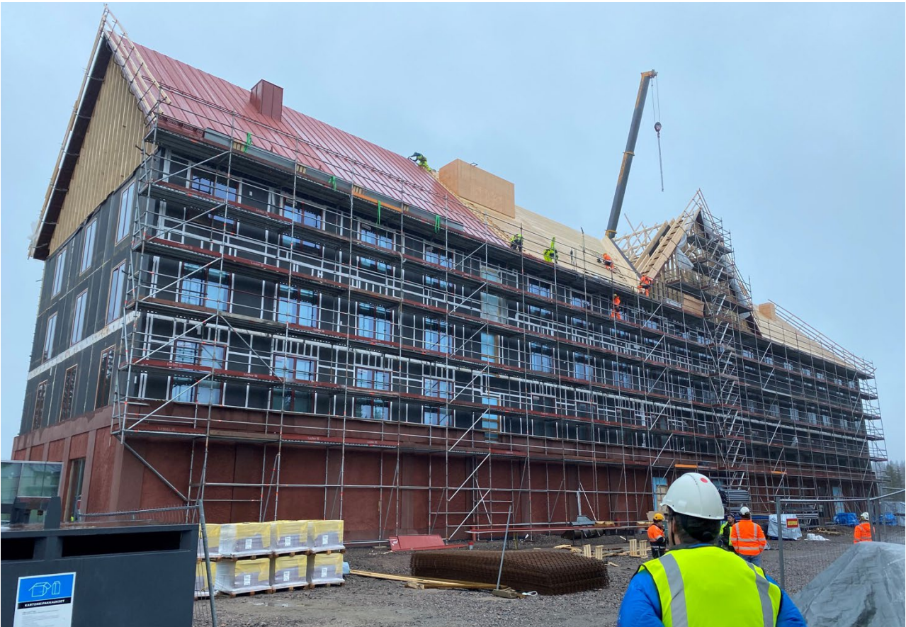
Kuva 3. Kolin kylän uuden hotellin työmaa, marraskuu 2022. Kuva: Juuso Kokkonen
