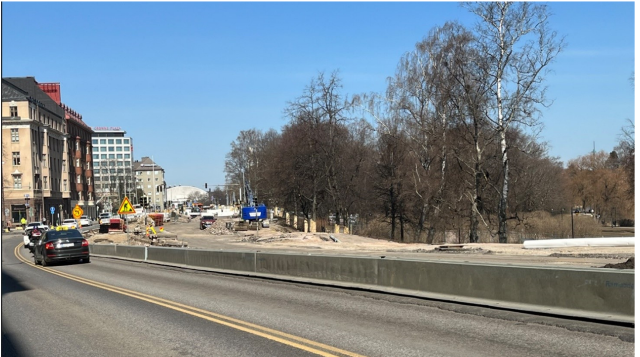
Kuva 2. Yleiskuvaa Mannerheimintien perusparannuksen työmaalta 17.4.2023.
