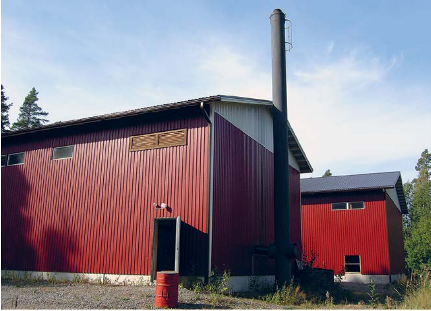
Kuva 14.1 Ähtärin Tuomarniemen hakelämpölaitos, jonka kattilateho on 950 kW. (Kuva: Jussi Laurila).
