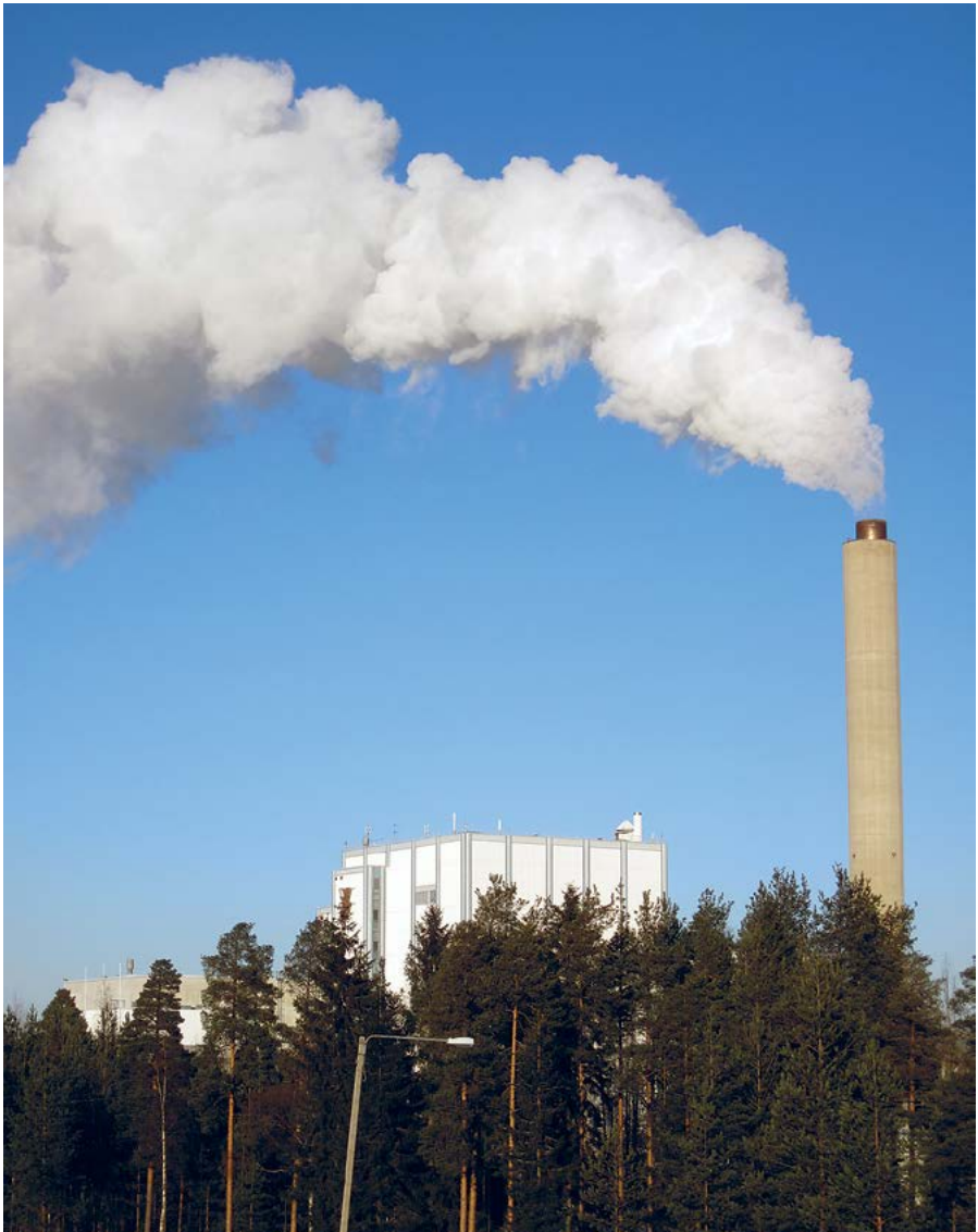
Kuva 15.2 Sähköä ja kaukolämpöä tuottava Seinäjoen energialaitos, Sevo. (Kuva: Ismo Makkonen).
